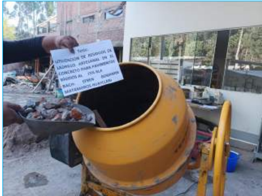
Se aprecia el material de residuo de ladrillos con el cual se preparó el concreto..
