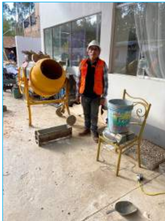
Se aprecia la mezcladora y algunos materiales utilizados para la preparación del concreto con residuo de ladrillos.
