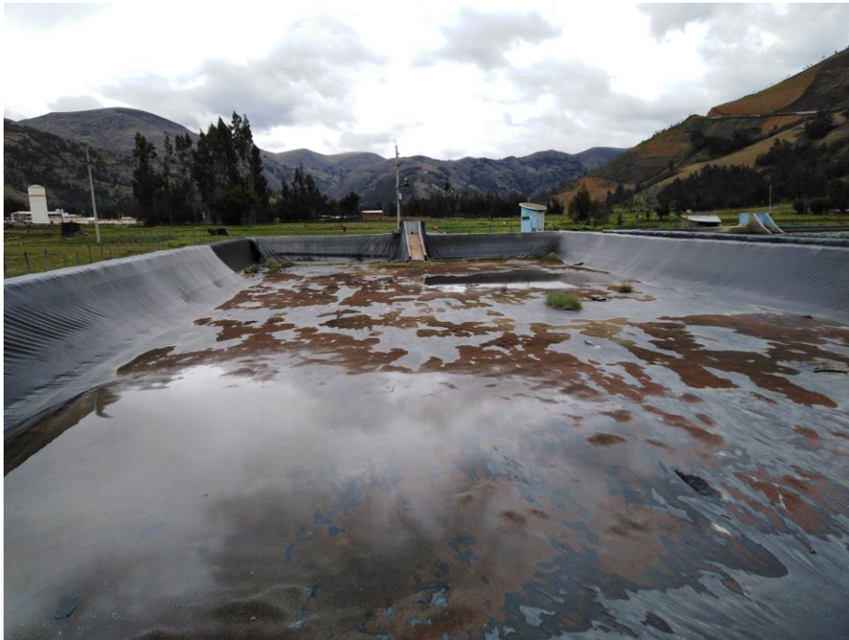
Fotografía 2: Laguna de estabilización n° 2 falta dar mantenimiento.
