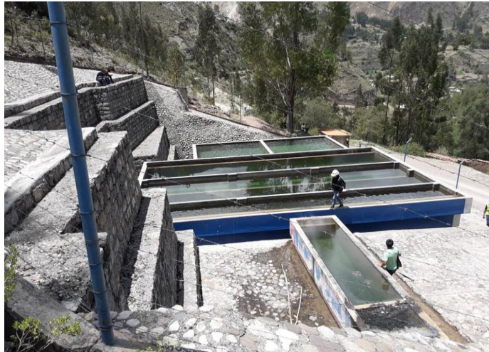
Imagen 10: Captación subterránea Rajayacu.
