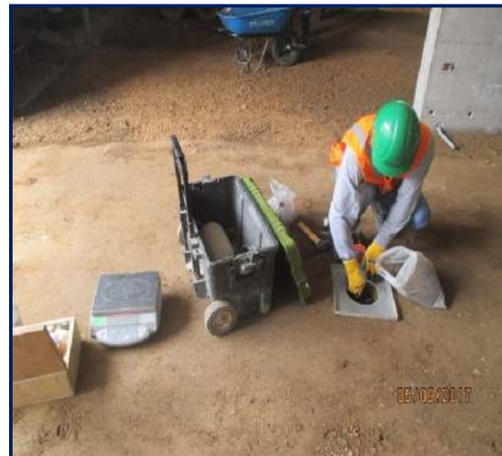
Figura 97. Pruebas de compactación. Fuente: propia
