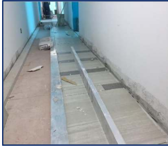
Figura 156. Mayólica en pasadizos. Fuente: propia
