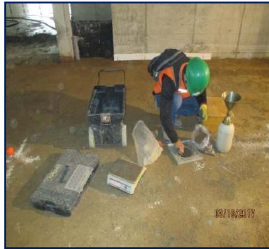
Figura 103. Prueba de compactación.
