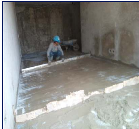
Figura 107. Regleado en contrapiso.
