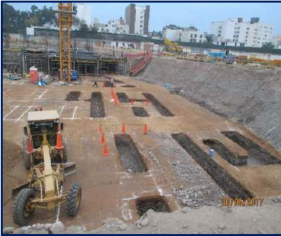
Figura 66. Trabajos de cimentación. Fuente: propia
