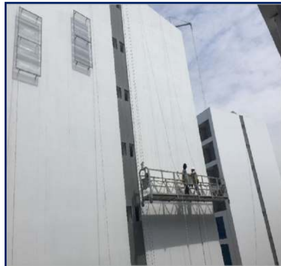
Figura 154. Acabados en fachada. Fuente: propia
