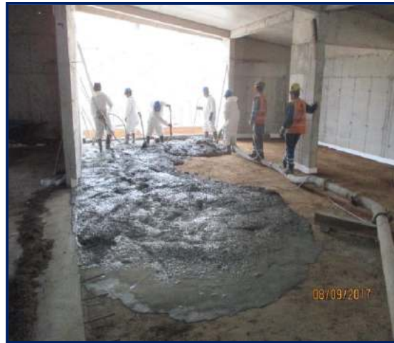
Figura 93. Vaciado de piso. Fuente: propia
