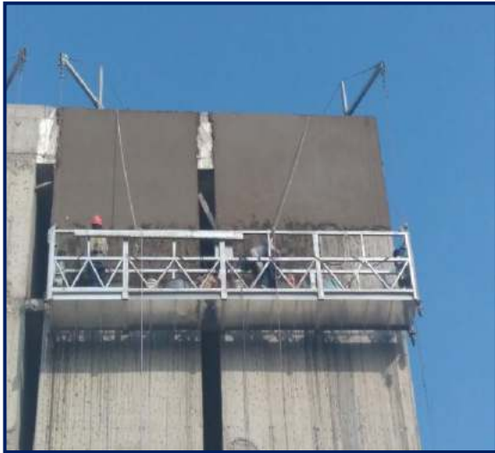
Figura 112. Tarrajeo de fachadas. Fuente: propia
