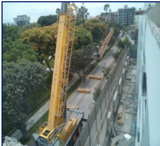
Figura 152. Grúa en operación. Fuente: propia
