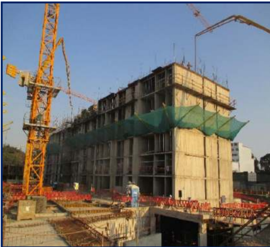
Figura 84. Vaciado de losa torre D.
