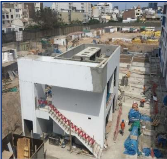
Figura 153. Acabados salón gourmet. Fuente: propia
