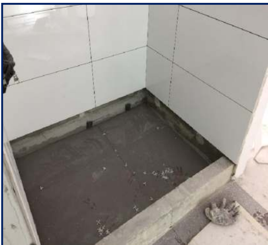
Figura 135. Enchape en baño visita.
