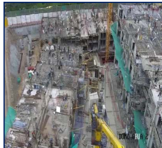
Figura 87. Vista general de techos.
