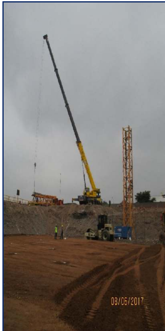
Figura 49. Armado de torre grúa. Fuente: propia
