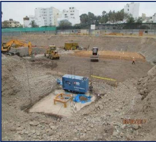
Figura 47. Trabajos de compactación. Fuente: propia
