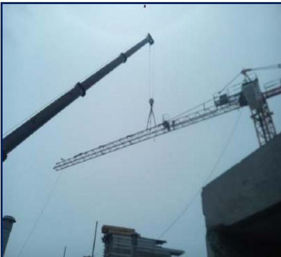
Figura 151. Retiro de torre grúa. Fuente: propia
