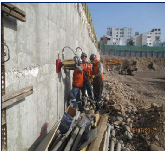
Figura 63. Tensado de muro.
