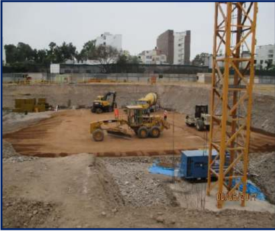
Figura 50. Nivelación del terreno. Fuente: propia
