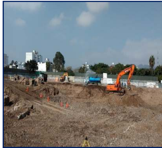
Figura 33. Excavadora Doosan. Fuente: propia
