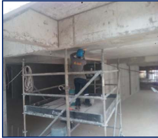
Figura 125. Solaqueo en sótano. Fuente: propia
