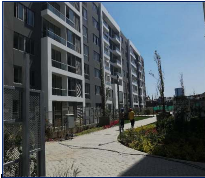
Figura 13. Torre D. Fuente: Propia.
