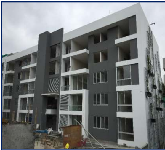
Figura 167. Vista torre B. Fuente: propia
