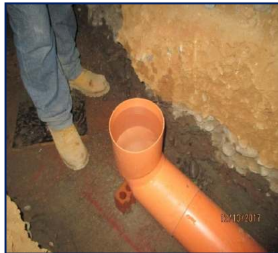
Figura 115. Prueba de estanqueidad. Fuente: propia
