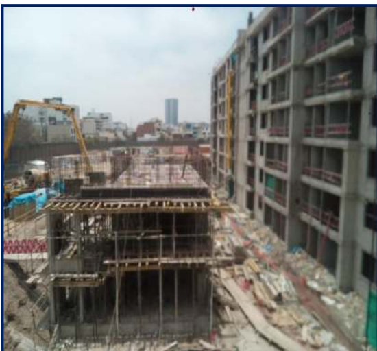
Figura 122. Estructuras salón gourmet. Fuente: propia
