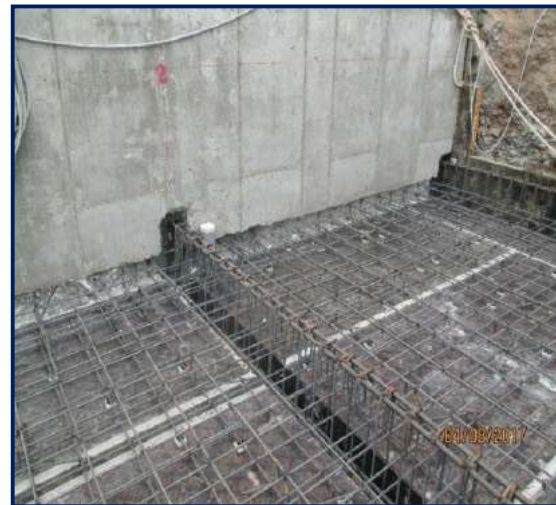
Figura 79. Techo de sótano Sector 3. Fuente: propia
