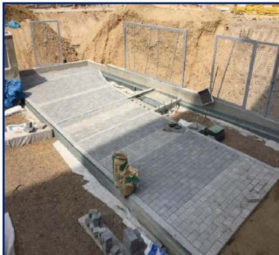
Figura 160. Colocación de adoquines. Fuente: propia
