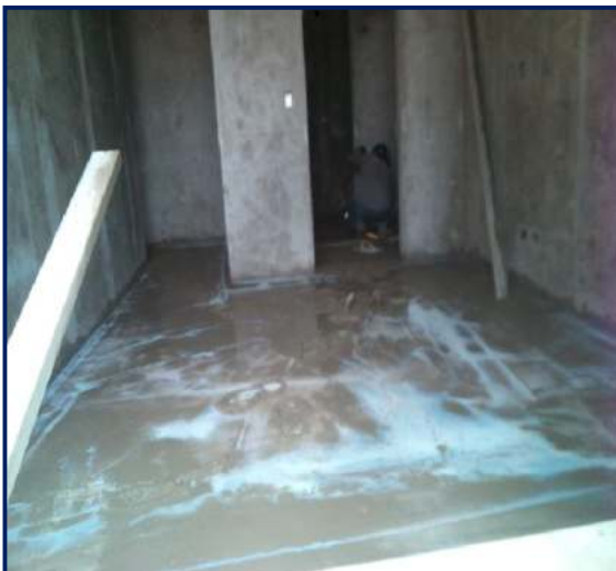
Figura 106. Vaciado de contrapiso.
