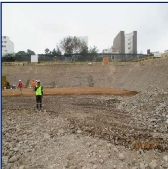
Figura 37. Nivelación de terreno.
