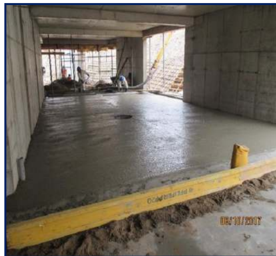
Figura 105. Acabado de losa sótano
