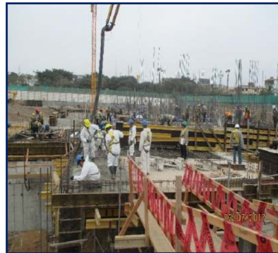
Figura 69. Vaciado de losa. Fuente: propia
