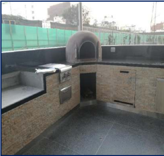
Figura 175. Acabados salon gourmet. Fuente: propia
