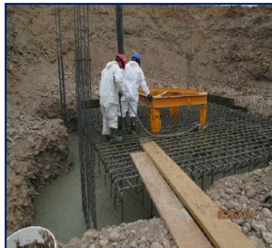
Figura 44. Concreto en base de grúa.
