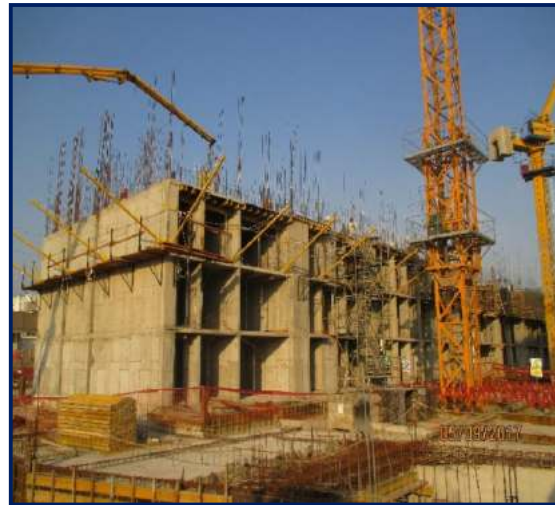
Figura 85. Vaciado de losa torre C.
