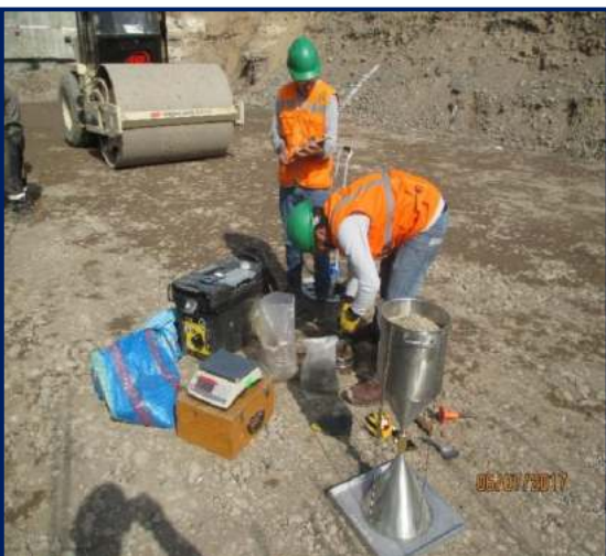
Figura 70. Pruebas de compactación. Fuente: propia
