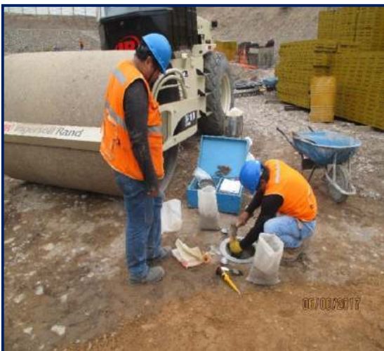
Figura 43. Prueba de compactación.
