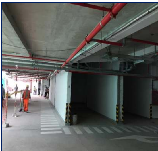
Figura 161. Pintura en piso.
