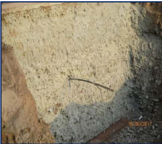
Figura 61. Perfilado de muro pantalla.
