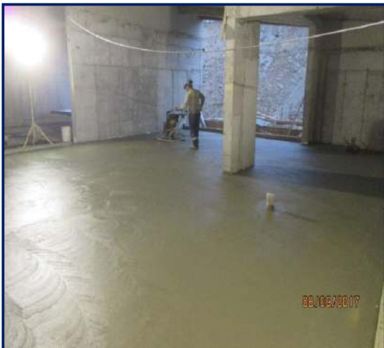
Figura 96. Alisado de piso. Fuente: propia
