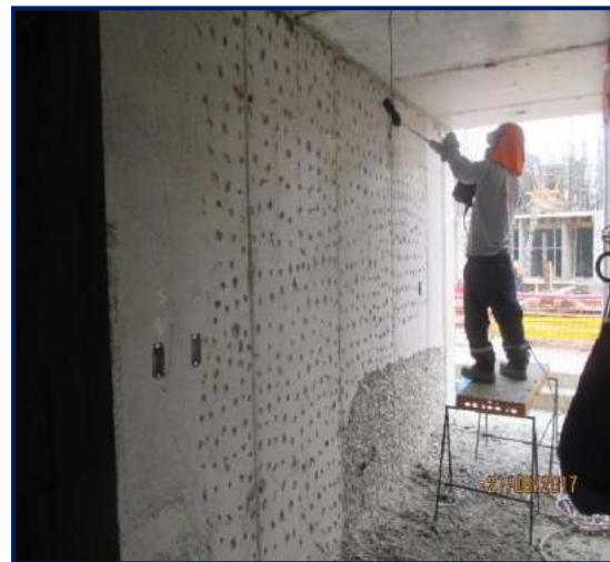
Figura 89. Escarificado de muro. Fuente: propia
