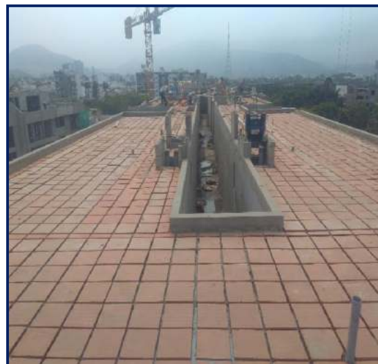
Figura 146. Acabados en techos.
