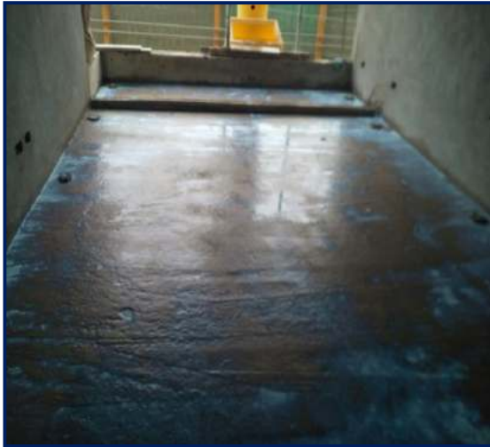
Figura 141. Avance de contrapiso. Fuente: propia
