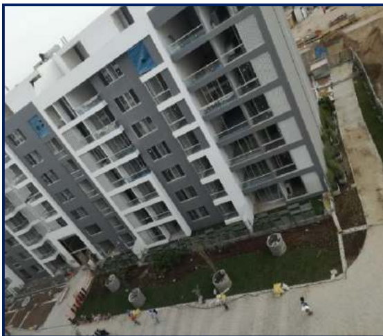
Figura 177. Vista torre D. Fuente: propia
