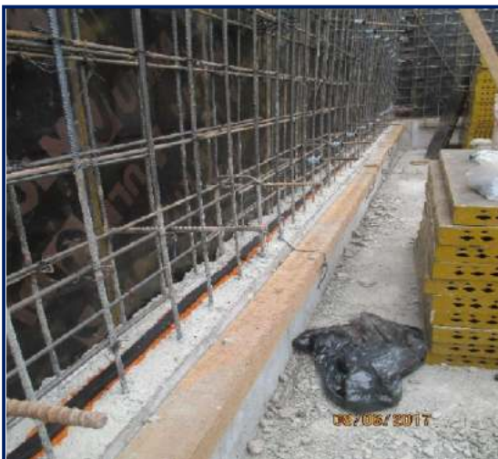
Figura 54. Encofrado de Cisterna. Fuente: propia
