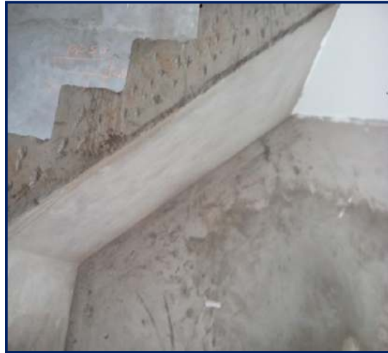
Figura 142. Escarificado de escaleras. Fuente: propia
