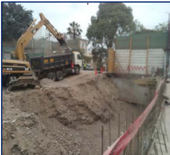
Figura 143. Eliminación de material. Fuente: propia
