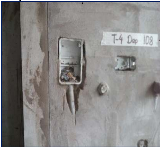
Figura 120. Fijación de puntos de IIEE.
