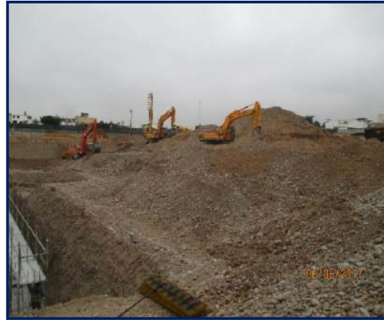
Figura 46. Excavación. Fuente: propia
