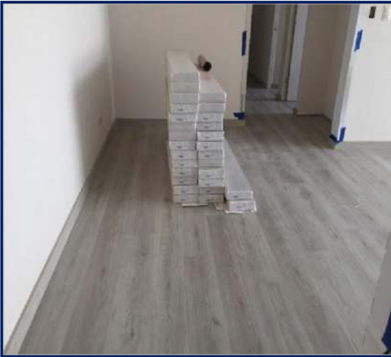
Figura 157. Piso laminado en depa. Fuente: propia
