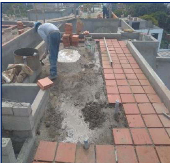
Figura 145. Instalación de ladr. paste.
