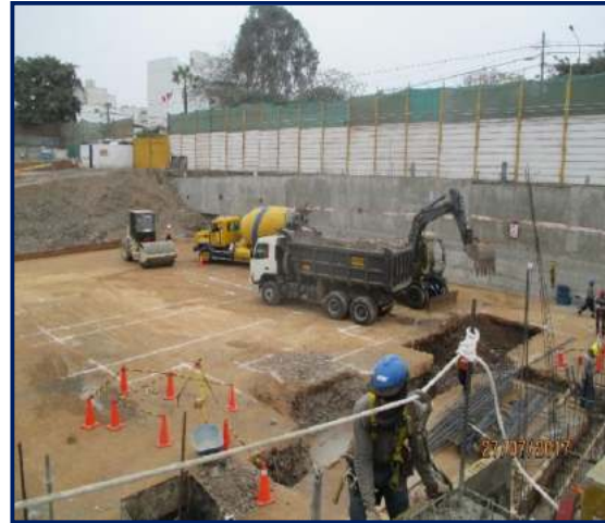
Figura 75. Cimentación sector 3. Fuente: propia
