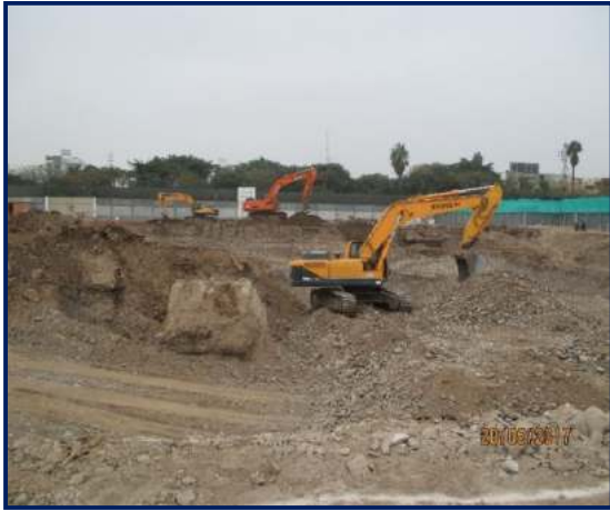
Figura 30. Inicio de excavación masiva. Fuente: propia
