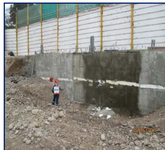
Figura 64. Curado del primer anillo.
