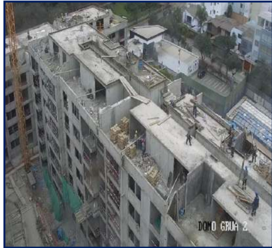
Figura 127. Torre D. Fuente: propia
