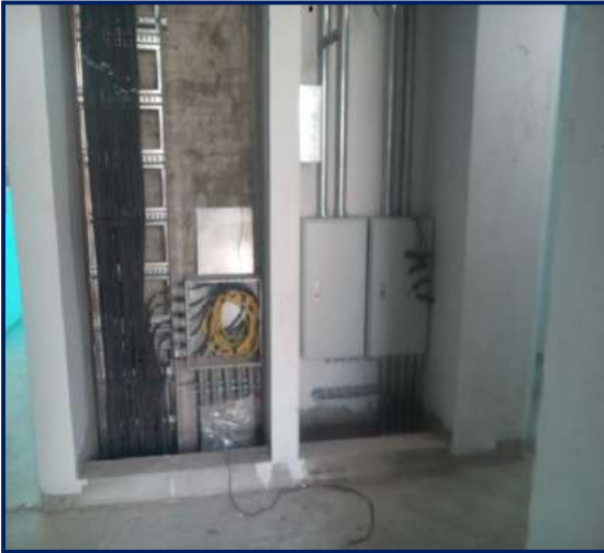
Figura 149. Montantes eléctricos. Fuente: propia
