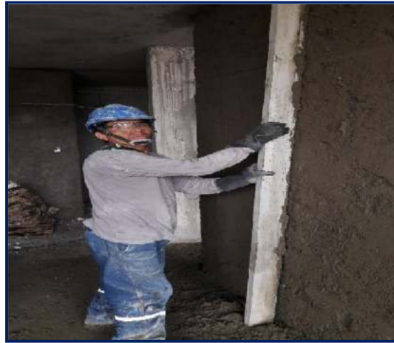
Figura 111. Tarrajeo de muros. Fuente: propia
