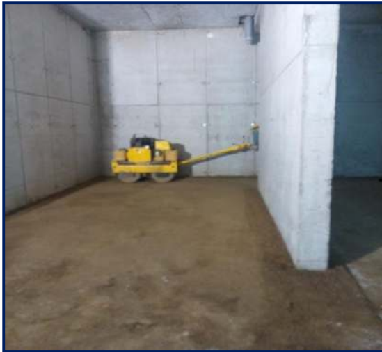
Figura 102. Compactado en sótano.
