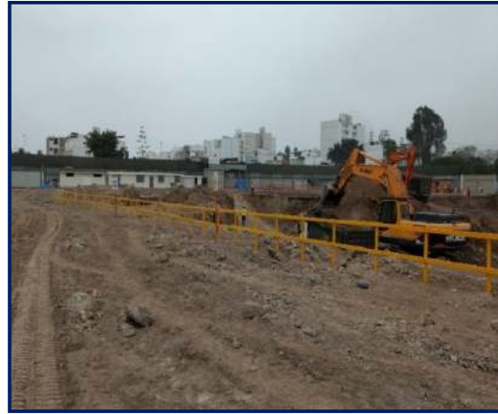
Figura 31. Excavadora Hyundai. Fuente: propia
