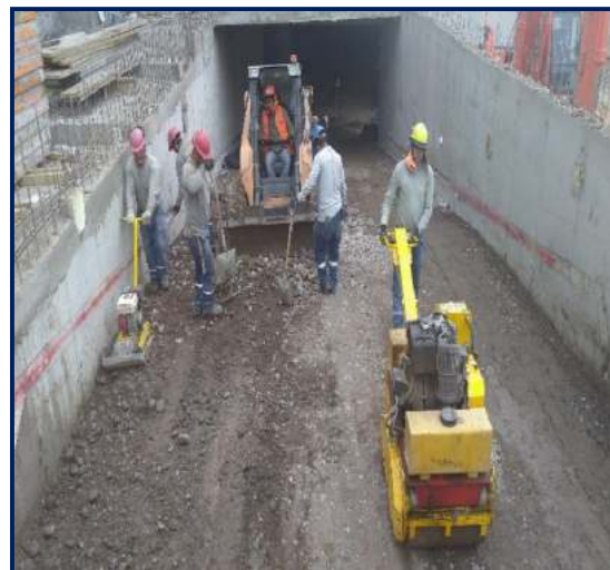
Figura 123. Compactación en rampa. Fuente: propia
