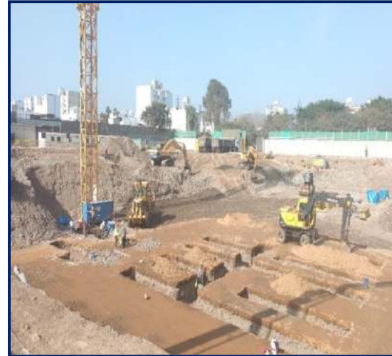
Figura 53. Cimentación sector 1. Fuente: propia
