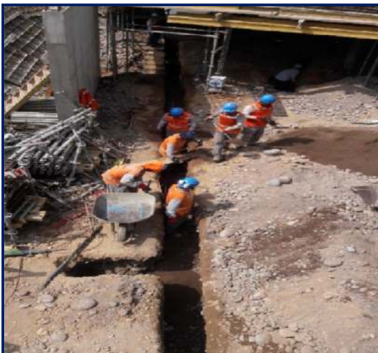
Figura 108. Excavación para malla IIEE. Fuente: propia
