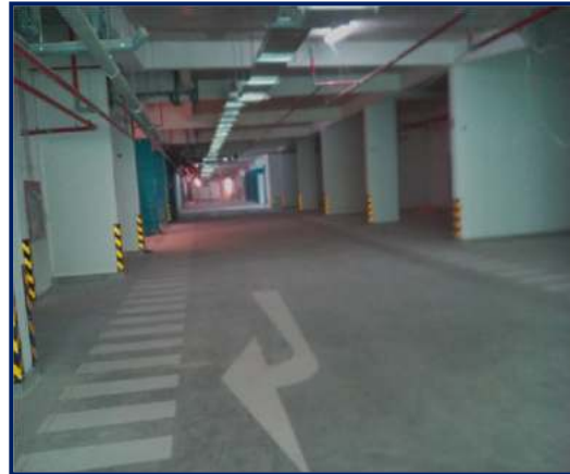
Figura 5. Acabados en sótano
