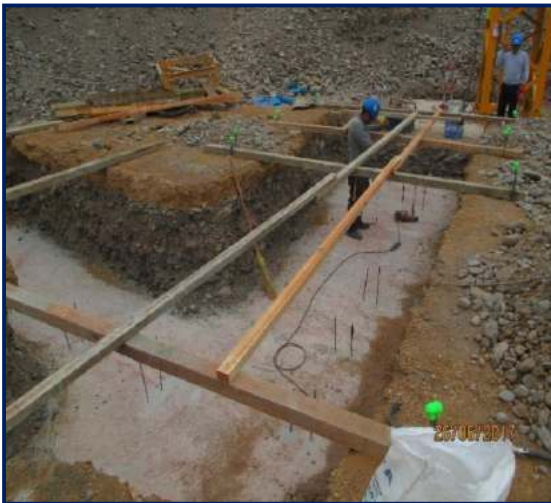
Figura 58. Solado para zapata.
