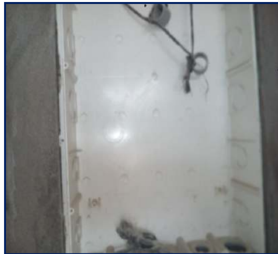
Figura 121. Fijación de tableros IIEE.
