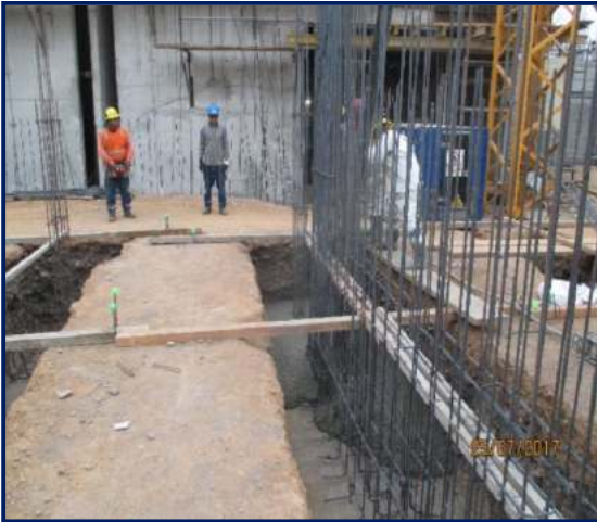
Figura 74. Vaciado de zapata. Fuente: propia
