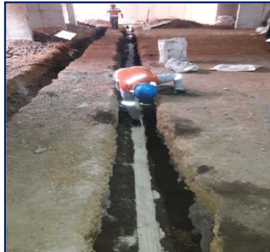
Figura 109. Aditivo para malla a tierra. Fuente: propia
