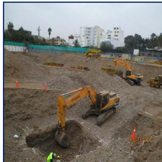
Figura 38. Excavación para zapatas.
