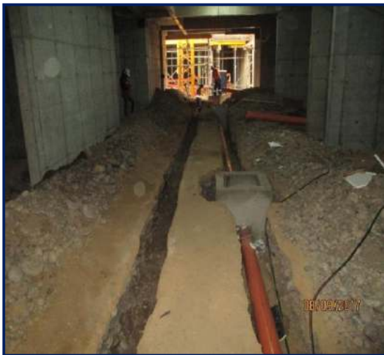
Figura 90. Red de desagüe sótano. Fuente: propia
