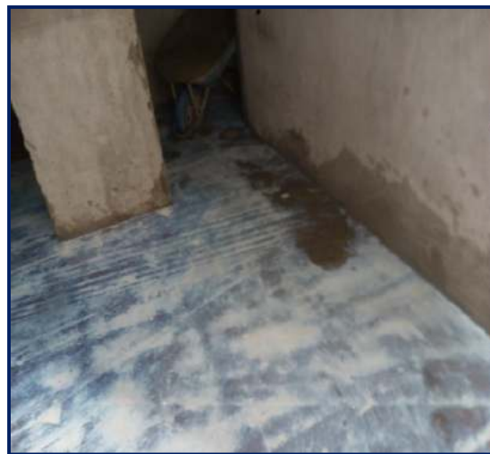
Figura 119. Contrapiso y tarrajeo.
