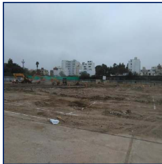
Figura 27. Trazos para inicio de obra.
