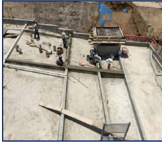
Figura 140. Acabados en exteriores. Fuente: propia
