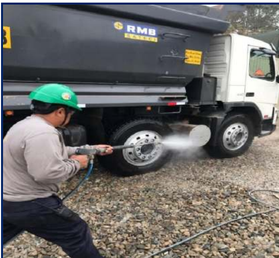
Figura 34. Limpieza de llantas. Fuente: propia
