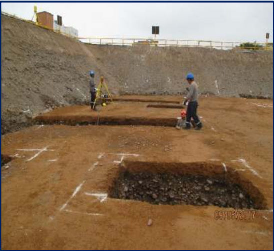
Figura 52. Excavación localizada. Fuente: propia
