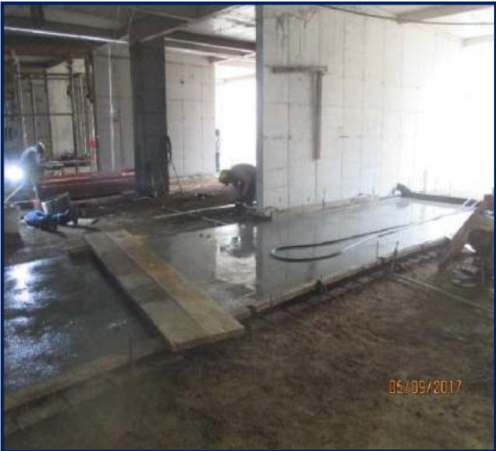
Figura 94. Curado de piso. Fuente: propia
