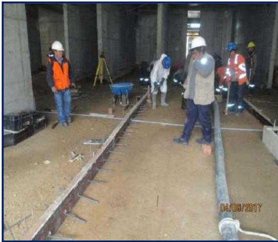
Figura 92. Colocación de dowells. Fuente: propia
