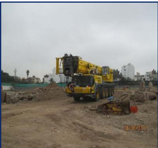
Figura 48. Ingreso de grúa. Fuente: propia
