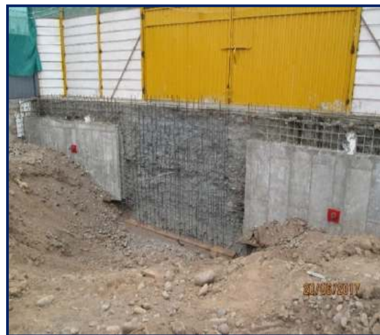
Figura 62. Colocación de acero en muro.
