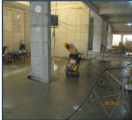
Figura 95. Corte en piso. Fuente: propia
