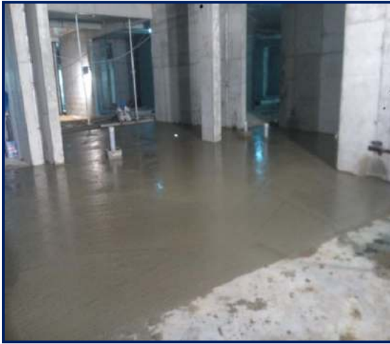
Figura 124. Vaciado en sótano. Fuente: propia
