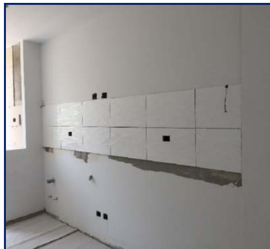
Figura 136. Enchape en cocina.
