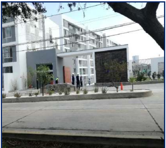
Figura 184. Ingreso principal Home T. Fuente: propia
