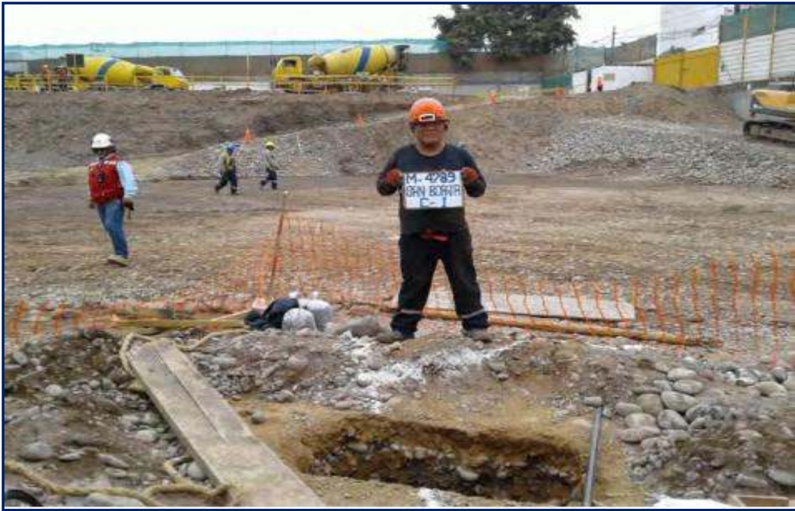
Figura 187. Calicata C-1 realizada durante ejecución de obra.
