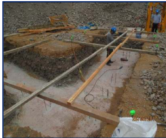
Figura 67. Solado de zapatas. Fuente: propia
