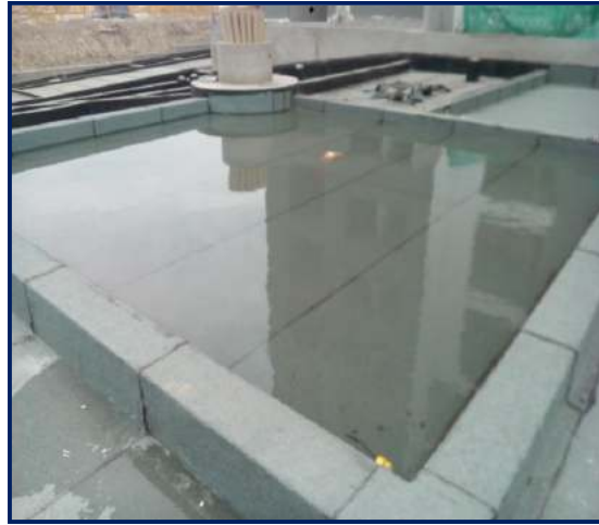
Figura 148. Estanqueidad en jardín. Fuente: propia
