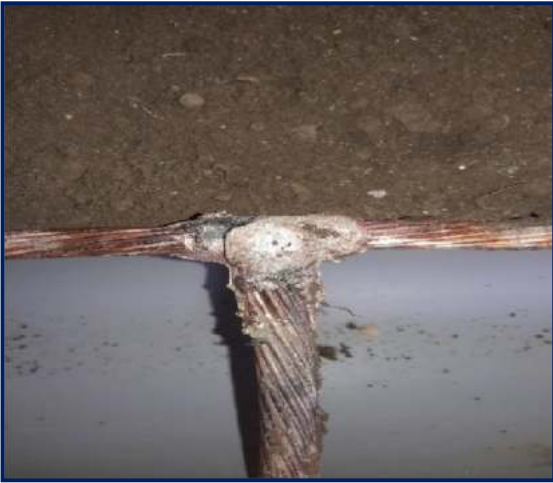
Figura 110. Soldadura cadwell. Fuente: propia
