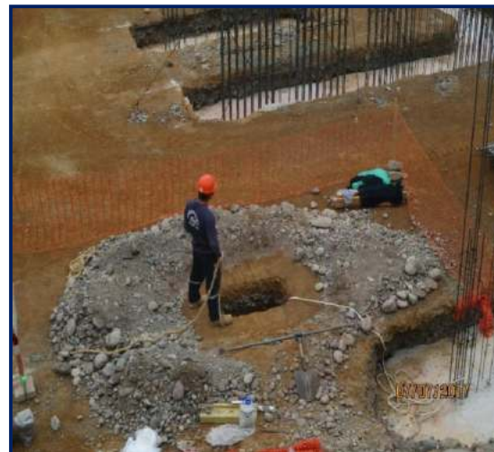
Figura 71. Calicata para EMS. Fuente: propia
