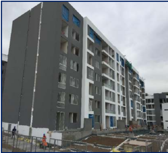
Figura 165. Vista torre D. Fuente: propia
