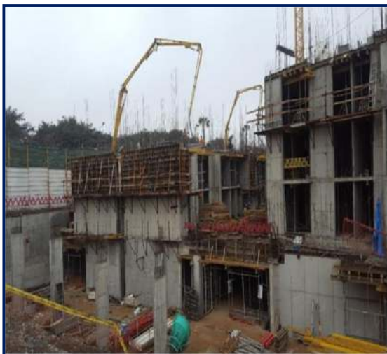
Figura 86. Vaciado de losa torre C.
