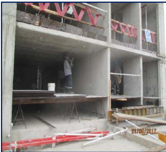
Figura 88. Escarificado de cielo raso. Fuente: propia
