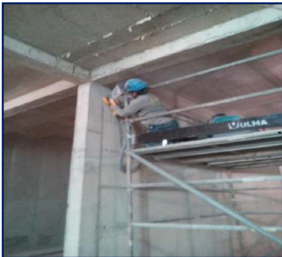
Figura 114. Amolado de placas. Fuente: propia
