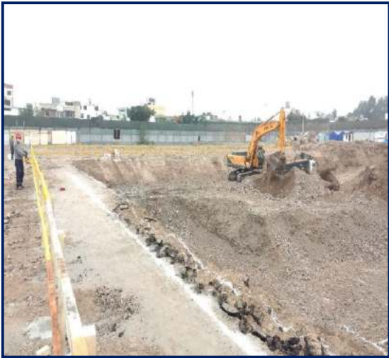
Figura 32. Carguío de material. Fuente: propia
