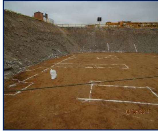
Figura 51. Trazos para excavación. Fuente: propia
