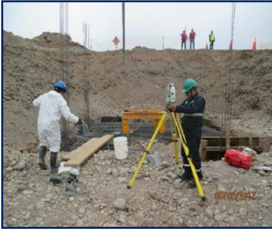
Figura 45. Base de torre grúa. Fuente: propia
