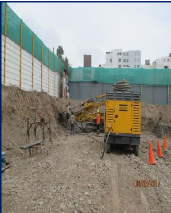
Figura 41. Vista de zona para anclaje.
