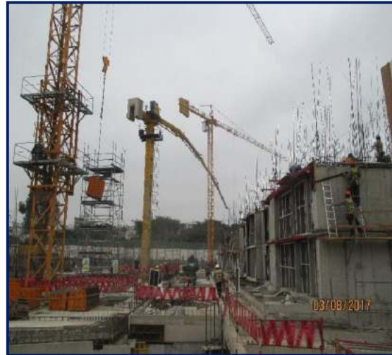
Figura 77. Vaciado de techo torre D. Fuente: propia
