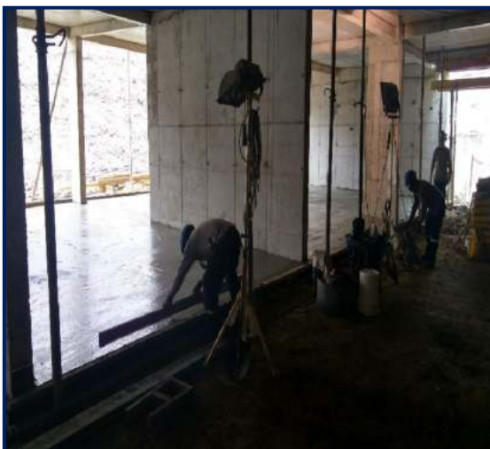
Figura 104. Acabado de losa sótano.
