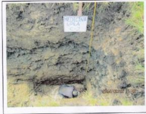
FOTO 07.- ALTURA DE EXCAVACION 5.00 mts, FACULTAD DE MEDICINA UPLA
