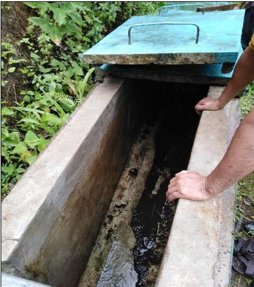
Fotografía 2. Inspección del desarenador existente.
