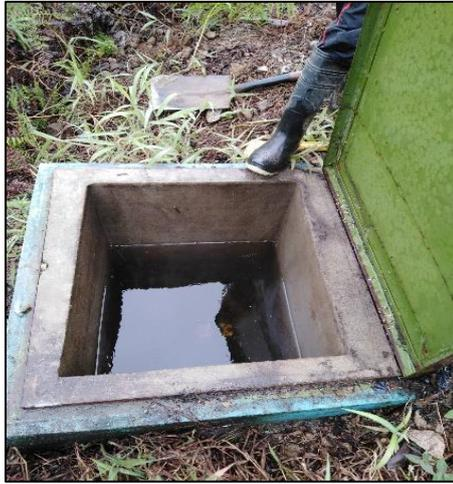
Figura 4.10. Válvula de aire con presencia de agua.
