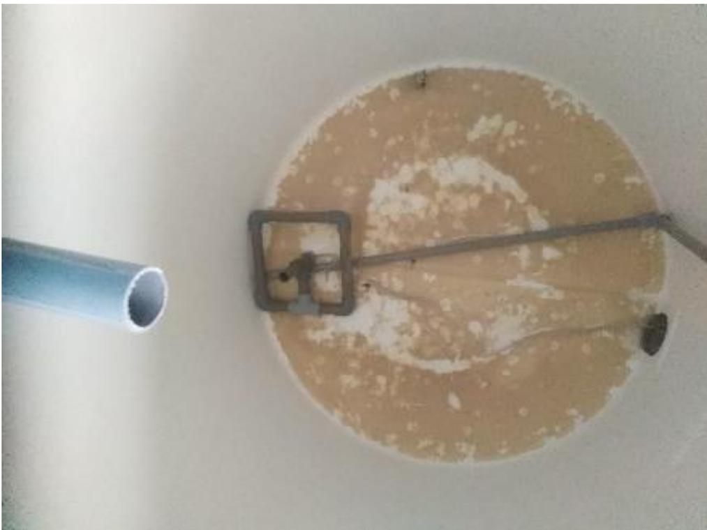
Fotografía 6. Sistema de cloración sin funcionamiento.
