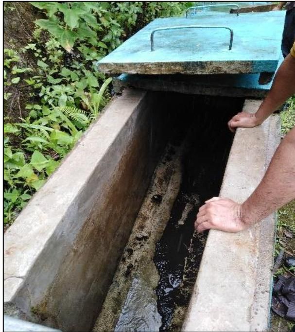
Figura 4.2. Desarenador existente funcionando ineficientemente.
