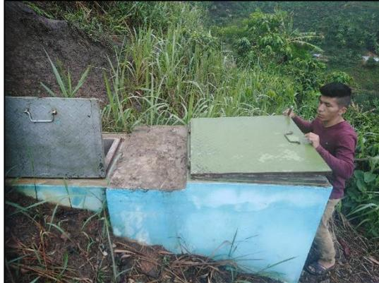
Figura 4.8. Cámara rompe presión tipo 07.
