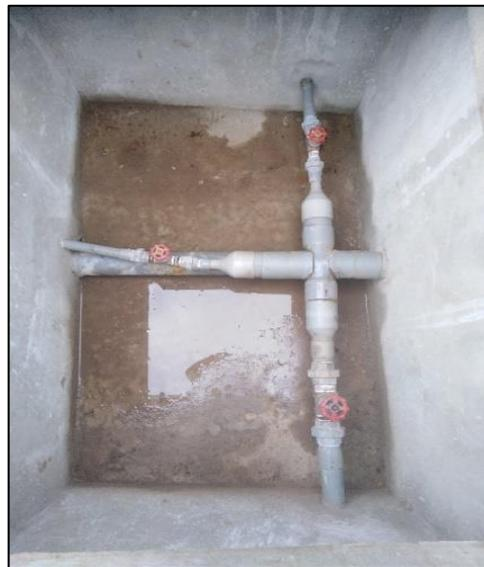
Figura 4.7. Caja de distribución del reservorio.
