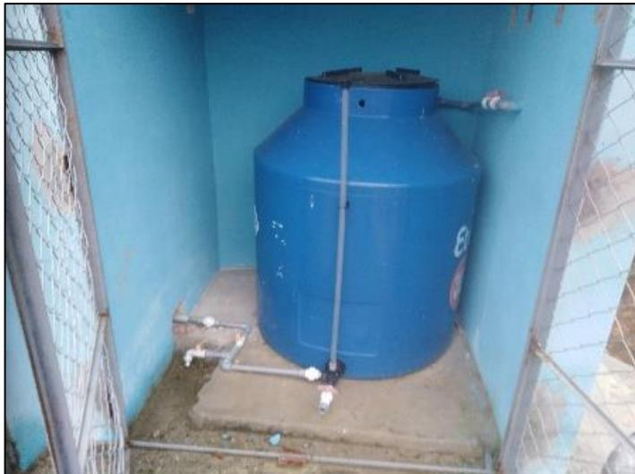
Figura 4.5. Sistema de cloración existente no se encuentra funcionando.
