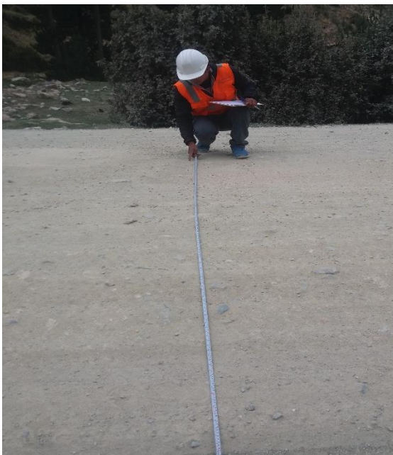
Medición de la Sección de la Calzada
