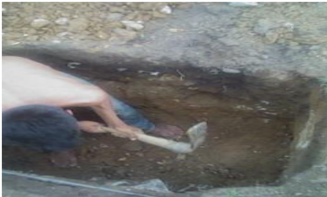
Figura N°11: Excavación de calicatas en el tramo en estudio
