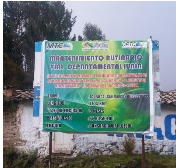
Cartel de Obra de Mantenimiento Rutinario
