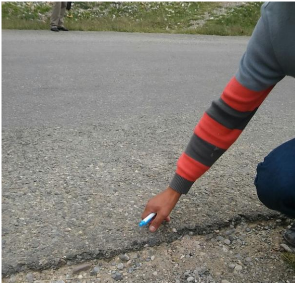
Tramo de la Carretera de Ñawinpuckio ha sido ejecutado en el año 1996, el espesor.
