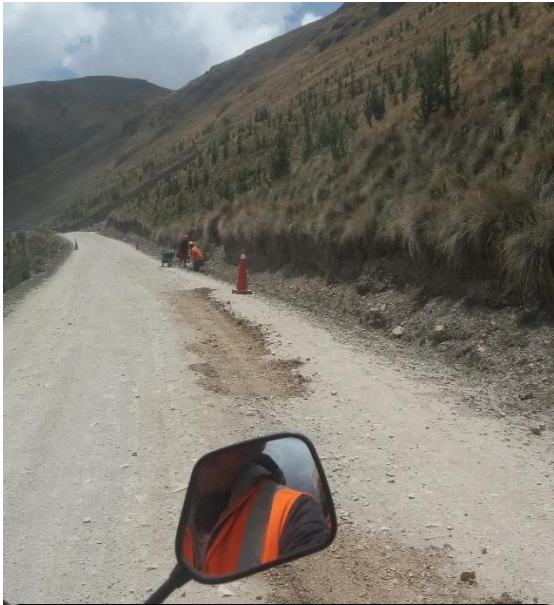
Trabajos de Mantenimiento Rutinario en Tramo Prog. 03+40km
