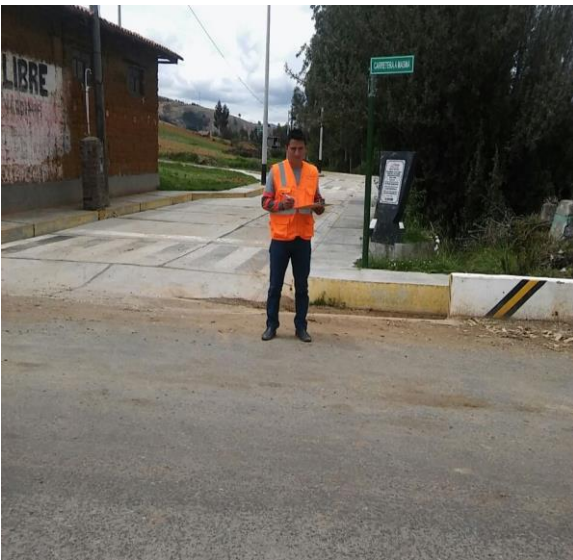
Tramo de la carretera de Valle Yacus, Desvió a Masma ejecutado en 2015
