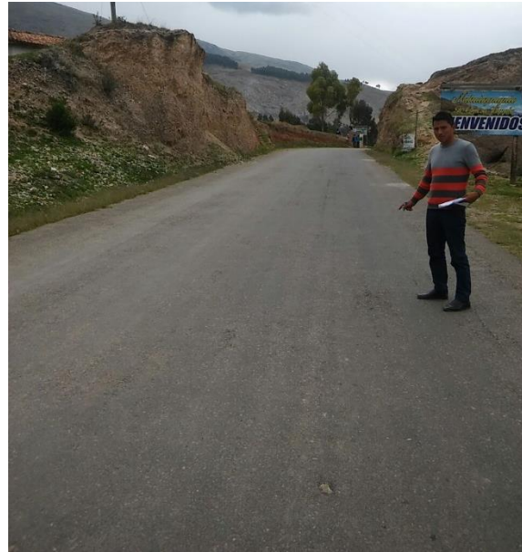
Tramo de la Carretera de Ñawinpuckio ha sido ejecutado en el año 1995, Pro. 00+00km
