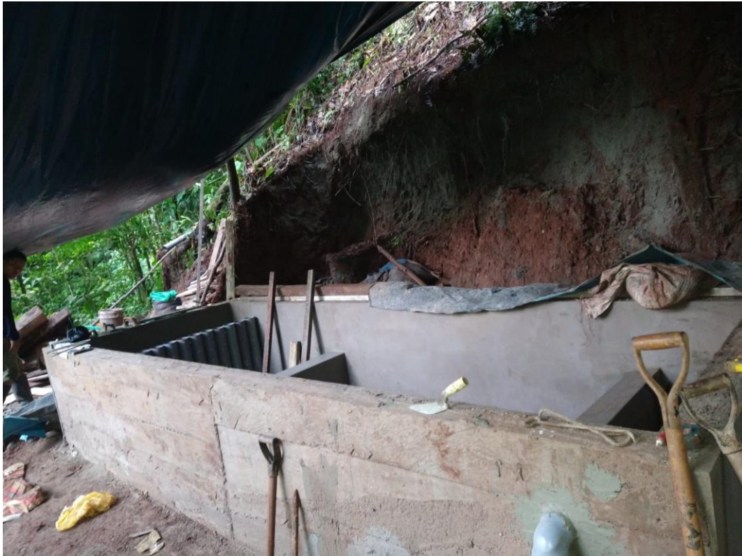
Anexo 5. Construcción del lecho filtrante – Tarrajeo en exteriores
