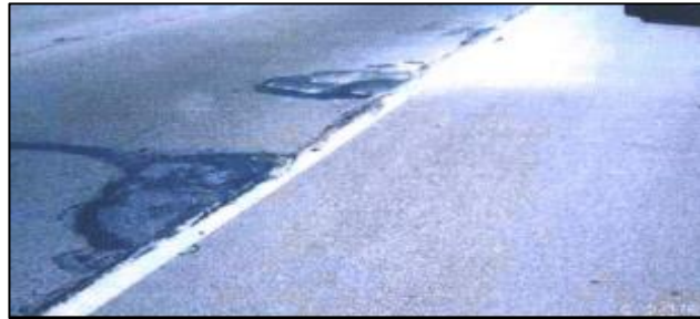
Figura 12. Bombeo de finos
