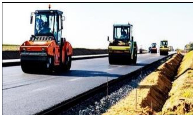
Figura 16. Estabilización con asfalto.
