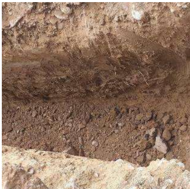
Fotografía 1: Excavación de calicata en la Av. Próceres Progresiva: 1+850 para obtener el material de subrasante según norma ASTM D 420
