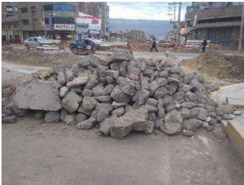
Fotografía 3: Obtención de residuos de concreto de la Av. Leoncio Prado
