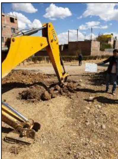
Fotografía 1. Excavación de la calicata N°01 a cielo abierto según norma MTC E 101- 2000, con maquinaria retroexcavadora.
