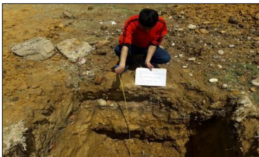
Fotografía 2. Verificación de 1.5 metros de profundidad de la Calicata N°01, según norma MTC E 101 -2000.
