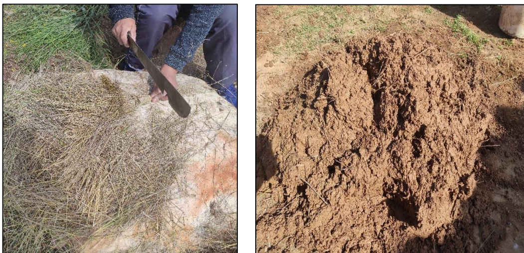
Figura 26: Picado de la paja y mezclado con el barro
