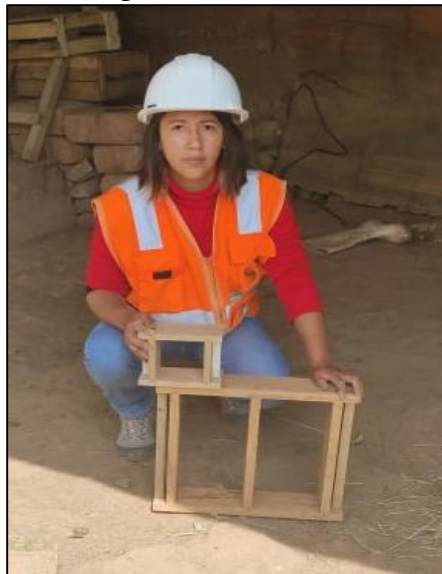
Figura 22: Moldes para la elaboración de adobes
