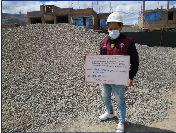
Figura 24. Extracción del agregado grueso.
