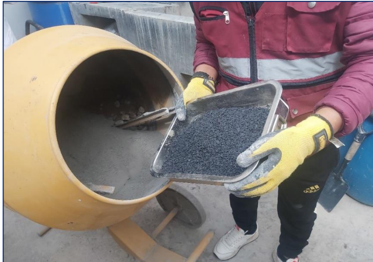
Figura 49. Mezcla del concreto con sustitución del caucho triturado.
