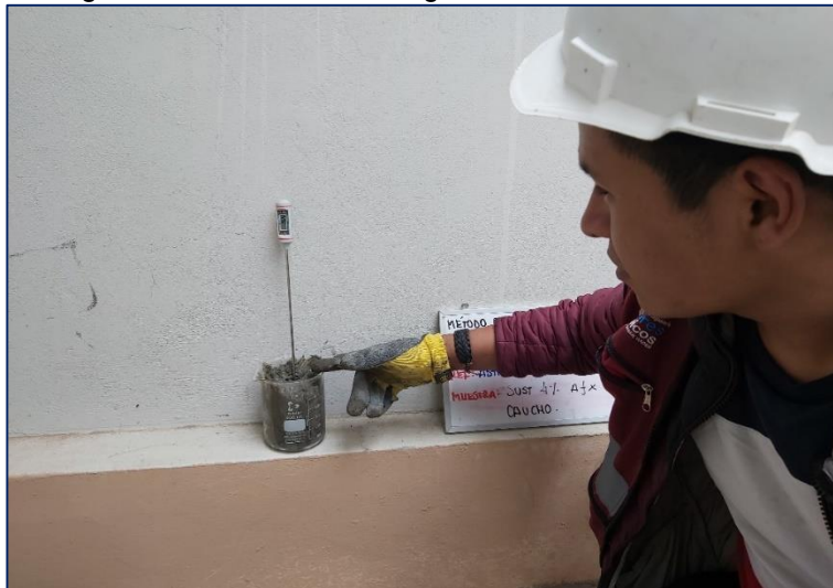
Figura 52. Medición de la temperatura del concreto con caucho triturado.
