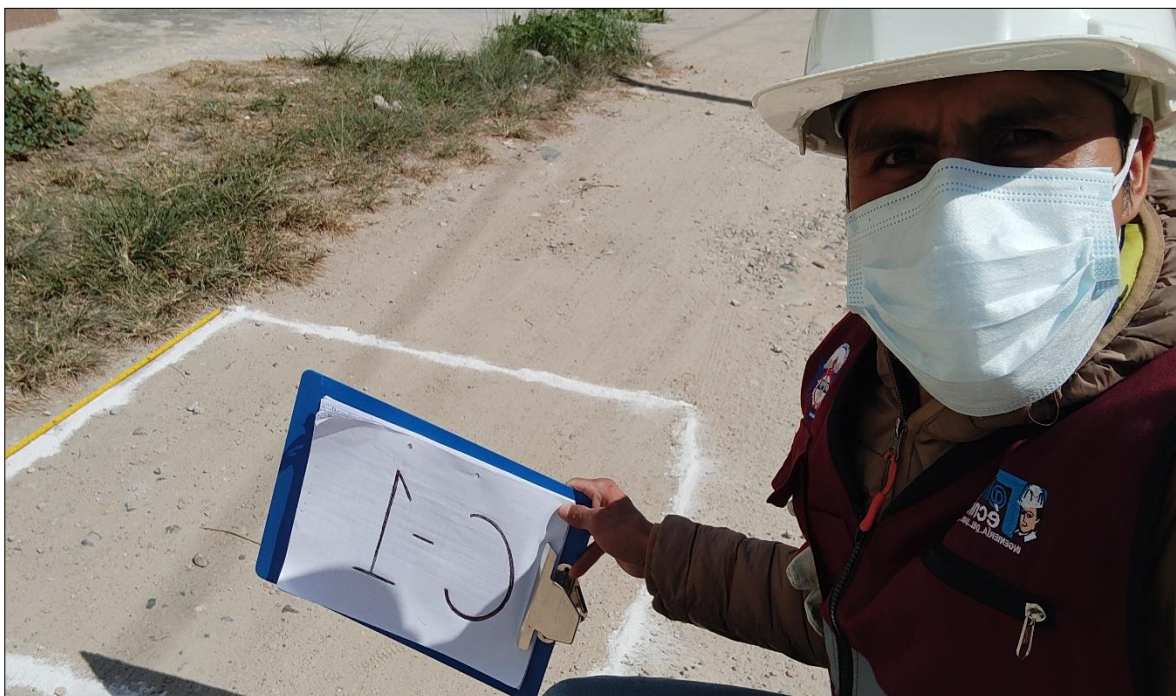
Fotografía 12: Calicata para el Estudio y Ensayo de Mecánica de Suelos, ubicado en la Av. Daniel Alcides Carrión intersección con la Av. Pioneros.
