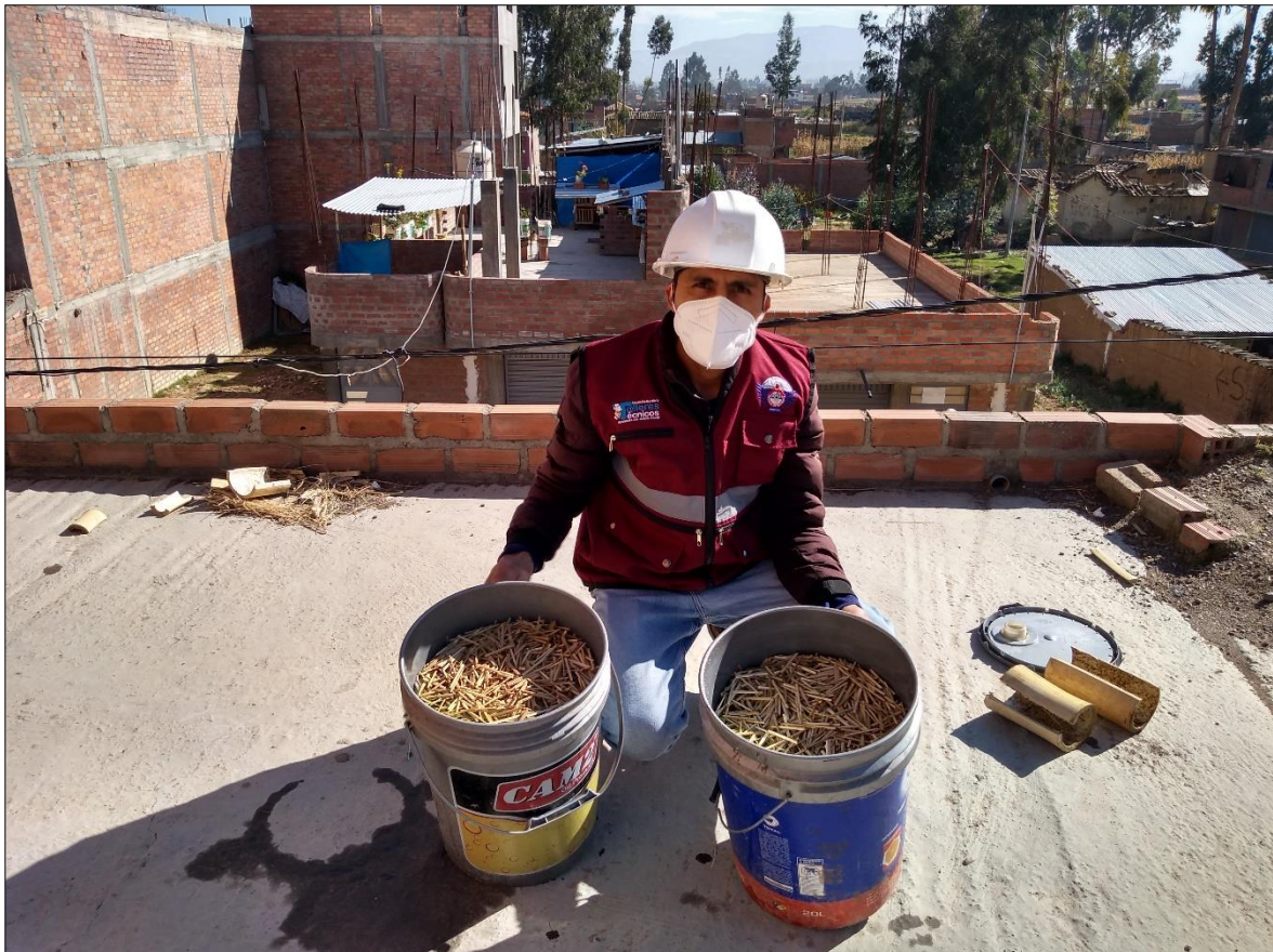
Fotografía 6: Impermeabilización de fibras de Guadua Angustifolia, por 24 Horas.
