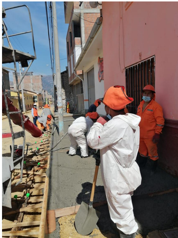
Foto 4.- Trabajo de mezcla de concreto con fibra 4D
