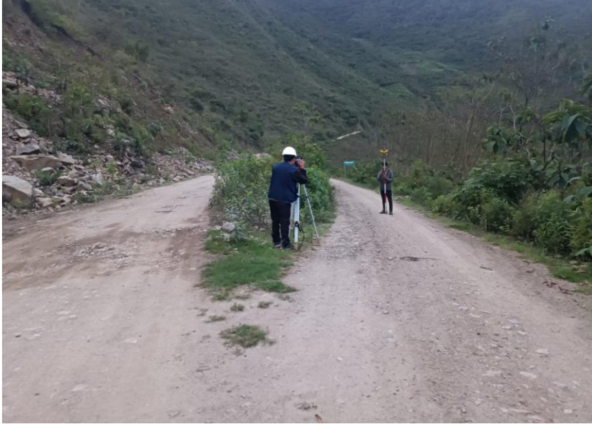
FOTOGRAFÍA N° 03: Inicio de los trabajos topográficos en la carretera en estudio.
