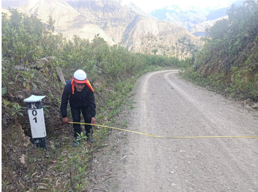
Figura N° 04: Toma de información de campo en el kilómetro 1+ 000.
