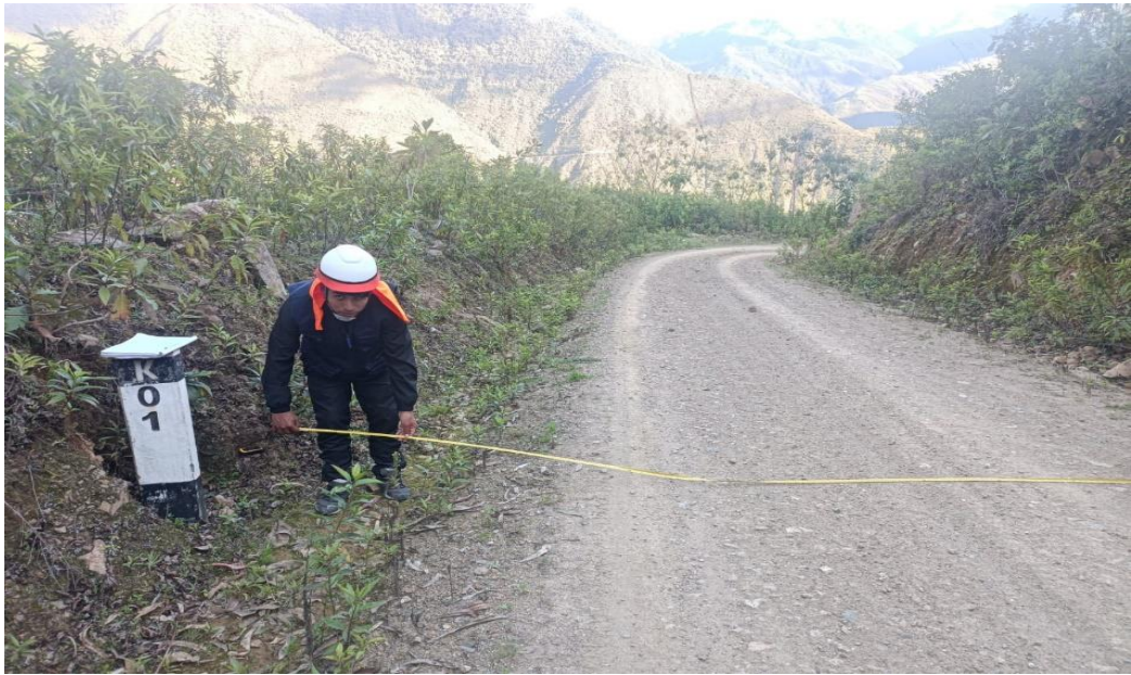
FOTOGRAFÍA N° 05: Medición de la calzada de la vía en la progresiva 1+000
