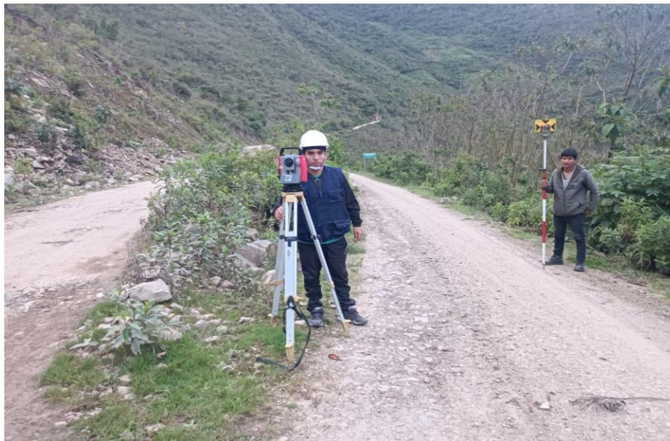
FOTOGRAFÍA N° 02: Verificación del nivel de la estación total.
