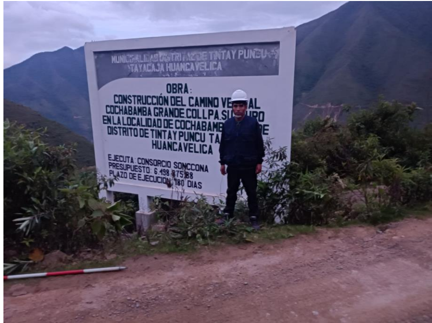
Figura N° 02: Cartel de identificación de obra del proyecto.
