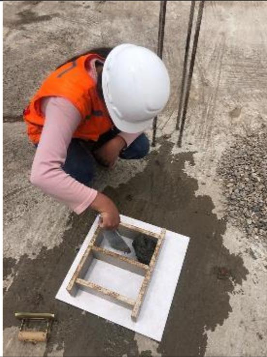
**Vista 09:** llenado de concreto a los moldes de adoquín.
