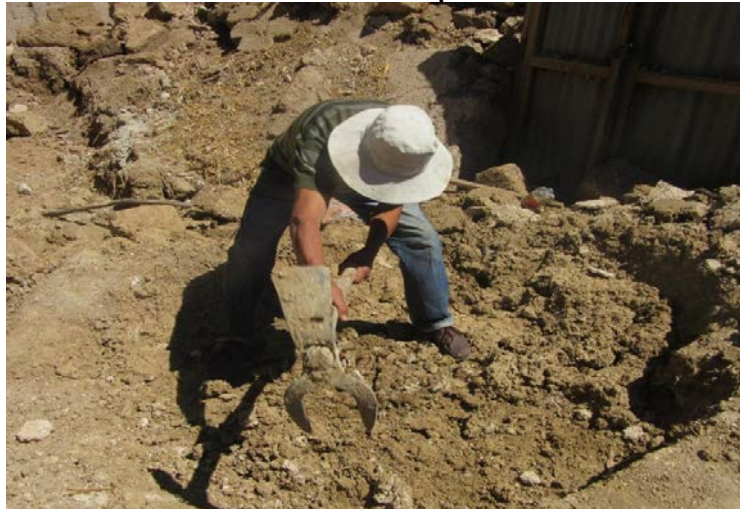
Gráfico 39. Extracción de material para elaboración de adobes
