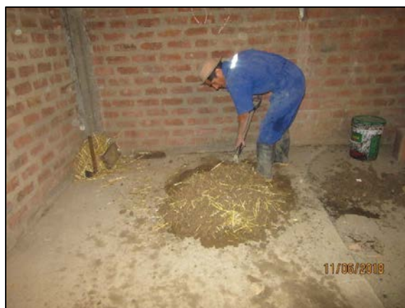
Gráfico 40. Proceso de mezcla de tierra con paja
