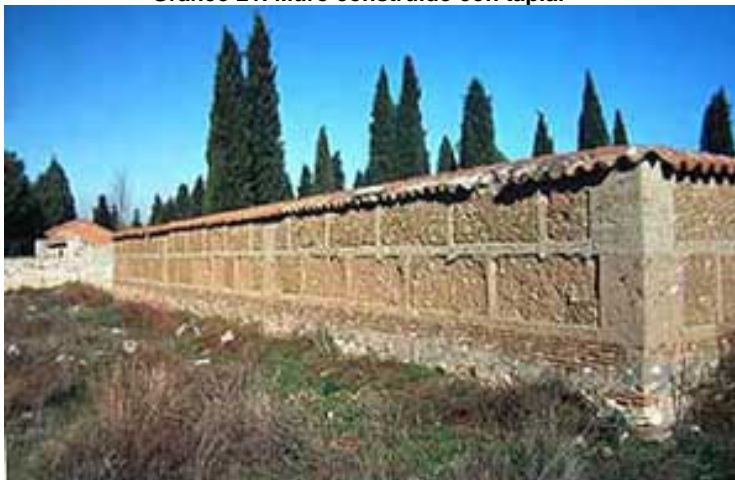
Grafico 21. Muro construido con tapial
