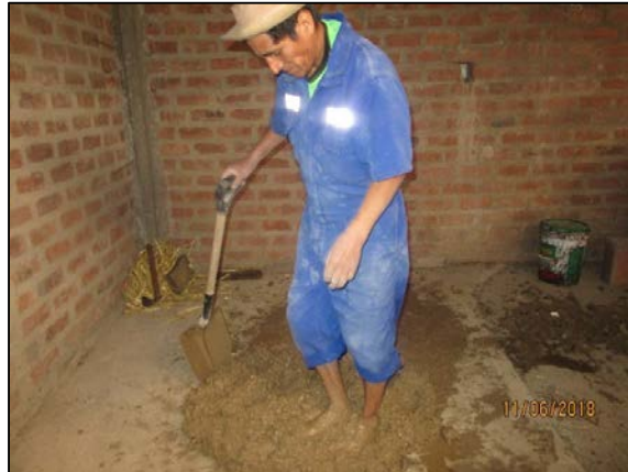
Gráfico 41. Proceso de pisado de la mezcla
