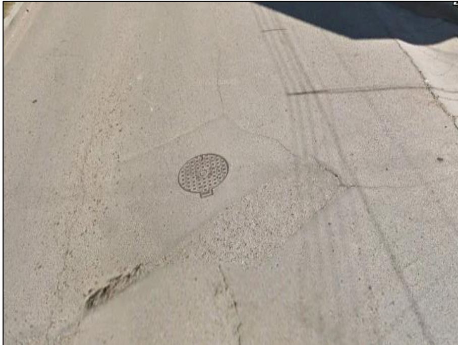
Figura 46, Grietas longitudinales y ahuellamiento en el carril izquierdo Av. Huancavelica progresiva 0+229.8 – 0+268.1
