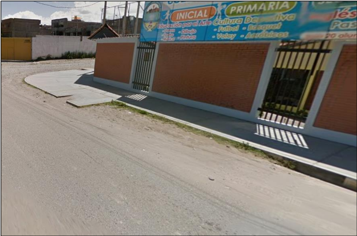
Figura 3. El agua pluvial no tiene desfogue por falta de cunetas.
