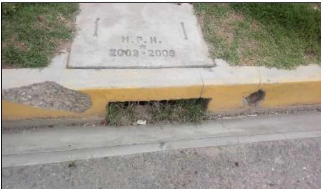
Figura 5. Drenaje saturado.
