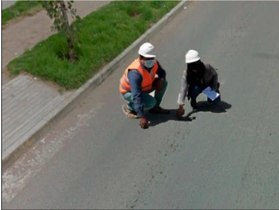
Figura 55. Ahuellamiento en el carril derecho Av. Huancavelica progresiva 0+383.0 – 0+421.3
