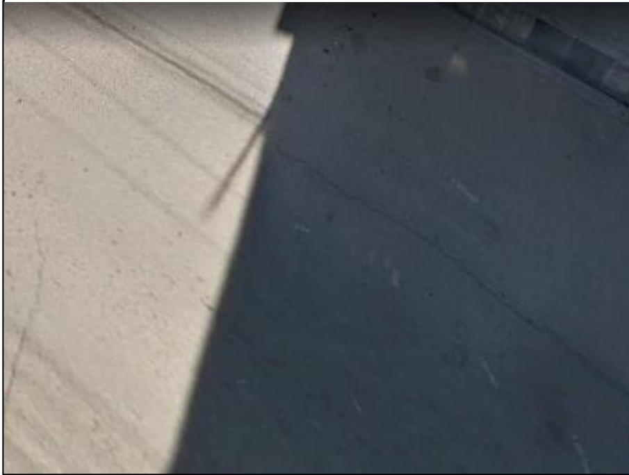
Figura 50. Agrietamiento en bloque en el carril izquierdo Av. Huancavelica progresiva 0+038.3 – 0+076.6
