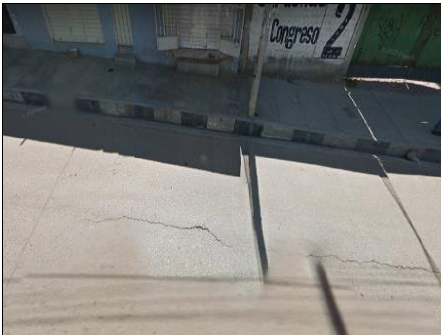
Figura 50. Agrietamiento en bloque en el carril izquierdo Av. Huancavelica progresiva 0+038.3 – 0+076.6
