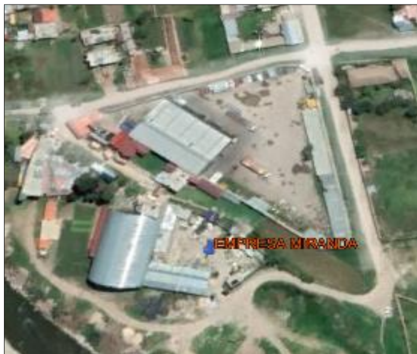
Figura 51. Planta de fabricación de adoquines de concreto , Por elaboración propia,2021.
