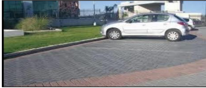
Figura 11. Adoquines empleados en un estacionamiento , Por Multimedia maldoni, 2013
