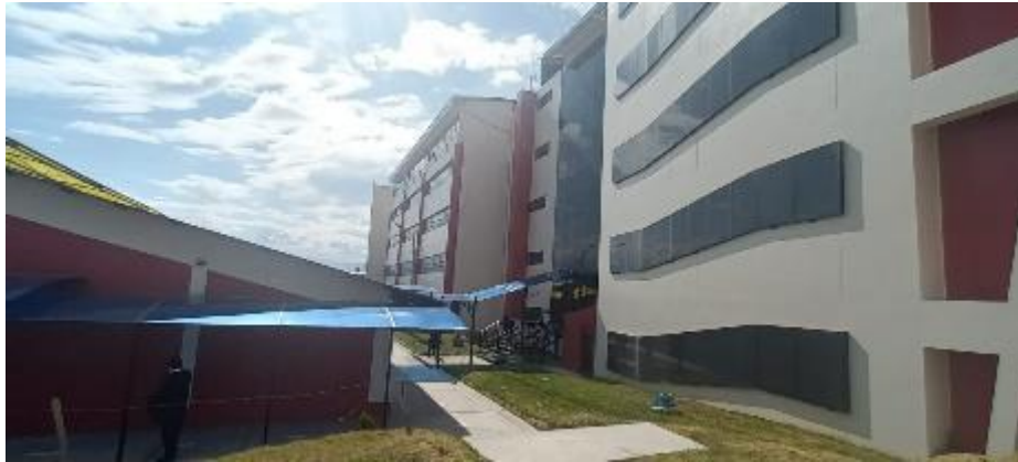
FOTO 1: Trabajo de campo – envoltente UPLA – Se observa las ventanas horizontales.
