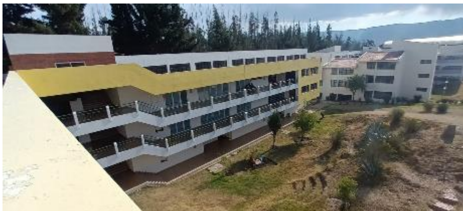
FOTO 3: Trabajo de campo – envoltente UNCP – Se observa la fachada.
