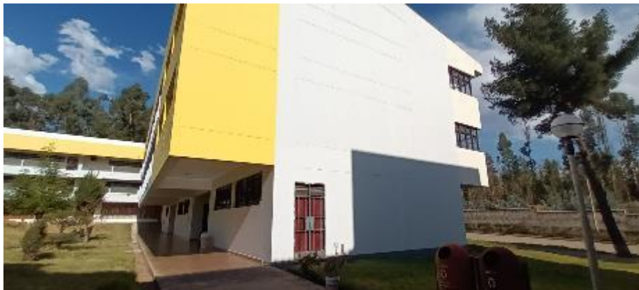
FOTO 12: Trabajo de campo – envolvente UNCP – Se observa la fachada.
