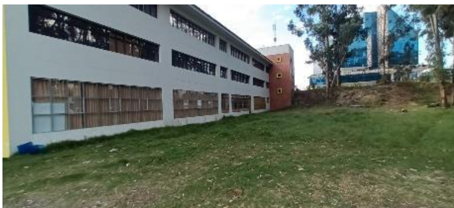
FOTO 23: Trabajo de campo – envoltente UNCP -Se observa columnas, ventanas, muros y vigas.
