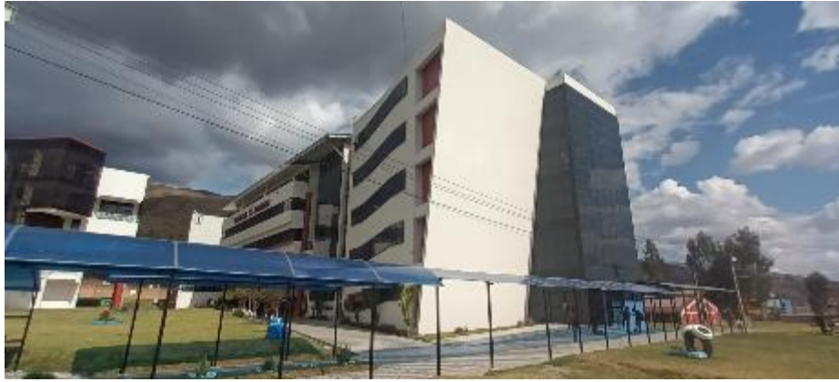
FOTO 4: Trabajo de campo – envoltente UPLA – Se observa columnas, ventanas.
