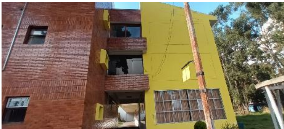
FOTO 18: Trabajo de campo – envoltente UNCP – Se observa ventanas, muros, vigas y losa aligerada.
