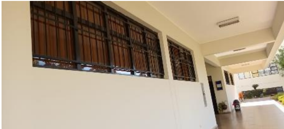
FOTO 11: Trabajo de campo – envolvente UNCP – Se observa las ventanas altas y muros.
