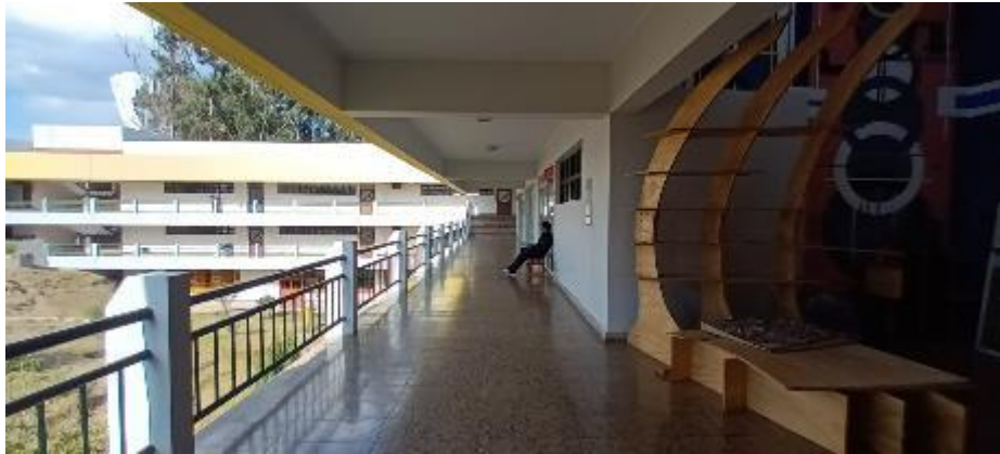
FOTO 7: Trabajo de campo – envolvente UNCP – El pasadizo las ventanas altas.
