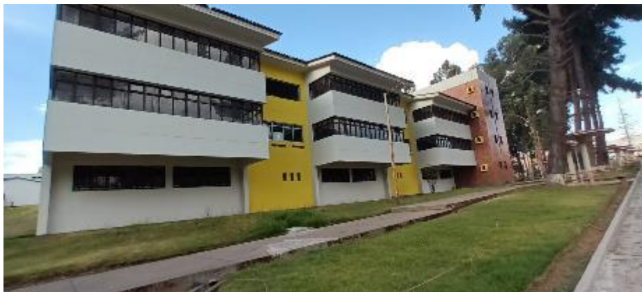
FOTO 2: Trabajo de campo – envoltente UNCP – Se observa ventanas horizontales, muros horizontales, vigas y columnas.
