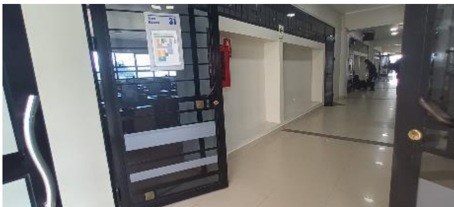
FOTO 12: Trabajo de campo – envoltente UPLA – Se se observa puertas y detalles de muros..
