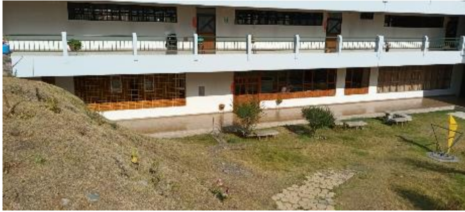
FOTO 10: Trabajo de campo – envolvente UNCP – Se observa ventanas y puertas.
