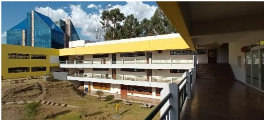
FOTO 14: Trabajo de campo – envoltente UNCP – Se observa puertas, ventanas, columnas y manparas.
