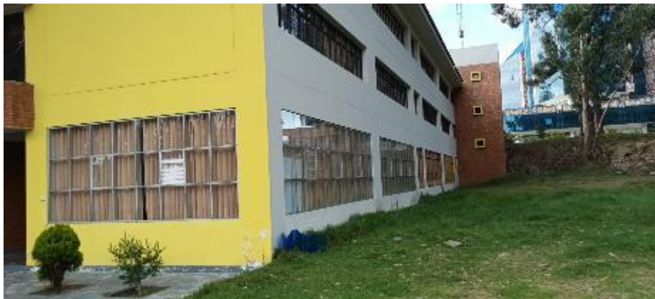
FOTO 20: Trabajo de campo – envoltente UNCP – Se observa columnas, muros, ventanas, y vigas.
