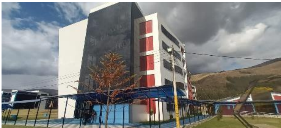
FOTO 3: Trabajo de campo – envoltente UPLA – Se observa muros.
