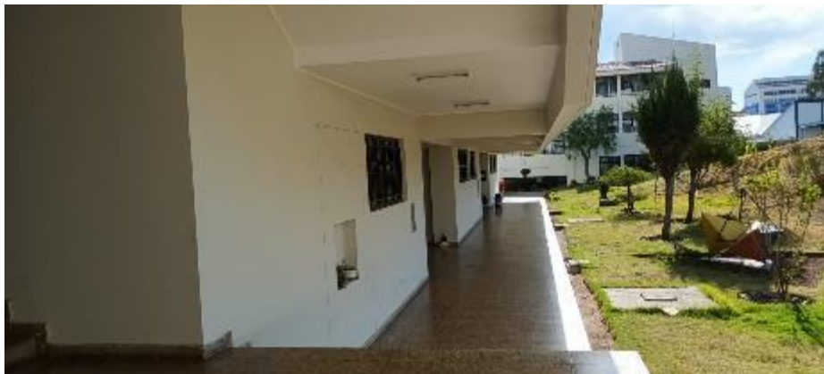
FOTO 8: Trabajo de campo – envolvente UNCP - Se observa las ventanas altas y muros.
