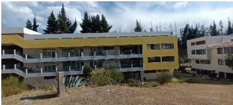
FOTO 9: Trabajo de campo – envolvente UNCP – Se observa la fachada.
