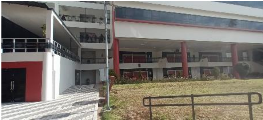
FOTO 8: Trabajo de campo – envoltente UPLA – Se observa columnas, puertas, ventnas y muros.
