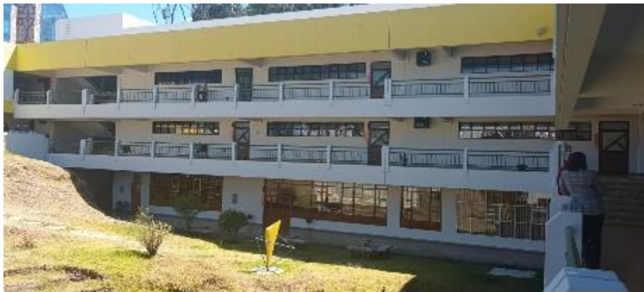
FOTO 21: Trabajo de campo – envoltente UNCP – Se observa ventanas, muros y puertas.
