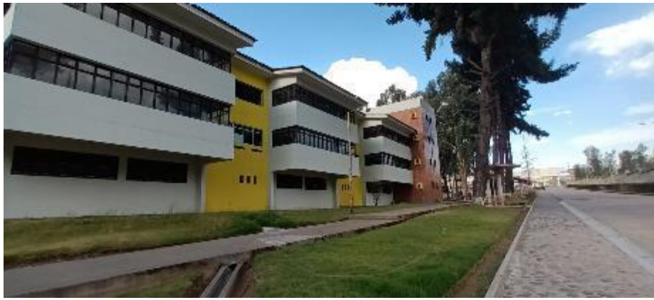
FOTO 19: Trabajo de campo – envoltente UNCP – Se observa ventanas, muros, columna , techos.
