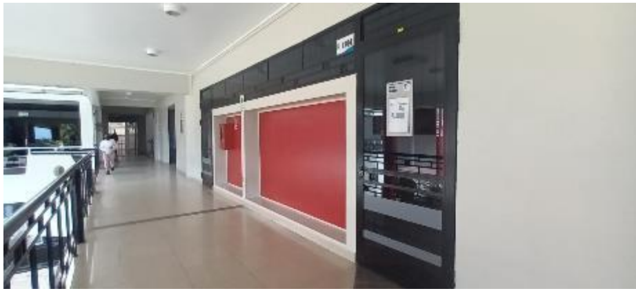
FOTO 10: Trabajo de campo – envoltente UPLA – Se observa detalles de muros y columnas.
