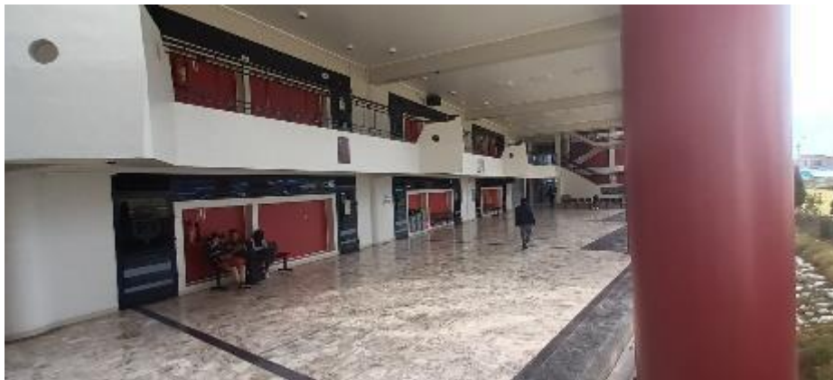
FOTO 11: Trabajo de campo – envoltente UPLA – Se observa puertas, ventanas y detalle de muros.
