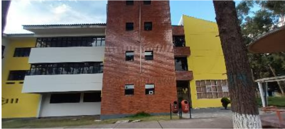
FOTO 1: Trabajo de campo – envoltente UNCP – Se observa ventanas, muros y columnas.
