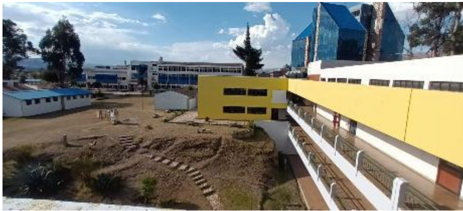
FOTO 17: Trabajo de campo – envoltente UNCP – Se observa muros , puertas y ventanas.
