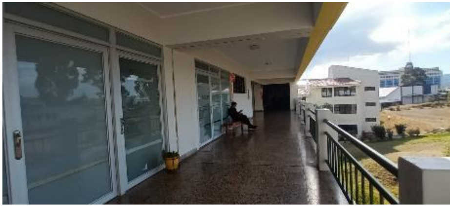
FOTO 13: Trabajo de campo – envoltente UNCP – Se observa las manparas, vigas, columnas y muros.
