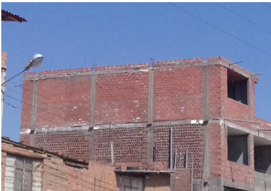
*Figura N° 1.* Edificación construida con ladrillo pandereta en ciudad de Huancayo, con el sistema de albañilería confinada.
