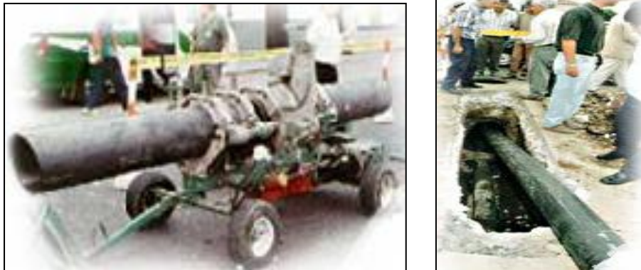
Figura 12 Imágenes de los primeros usos de la maquina Pipe Bursting.en el Peru
