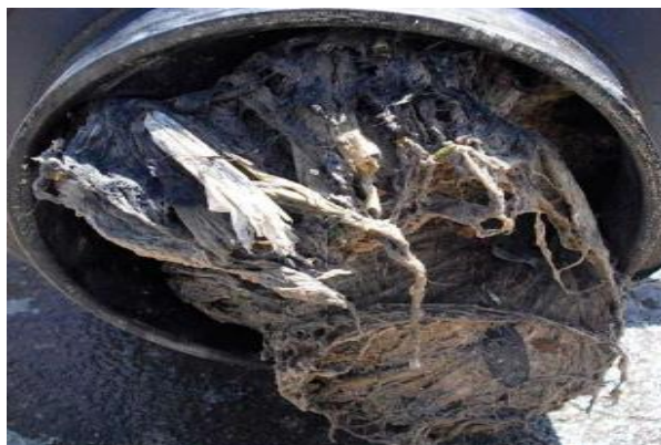
. Figura 4. Gráfico de Obstrucción a causa de trapos, plásticos y vidrio en la tubería
