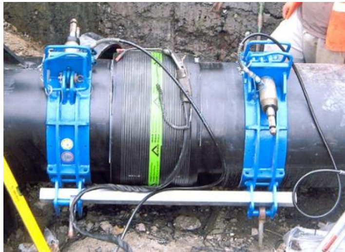
Figura 7. Máquina De Electro Fusión PEAD
