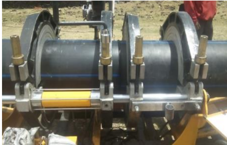
Figura 8. Equipo de Termo fusión
