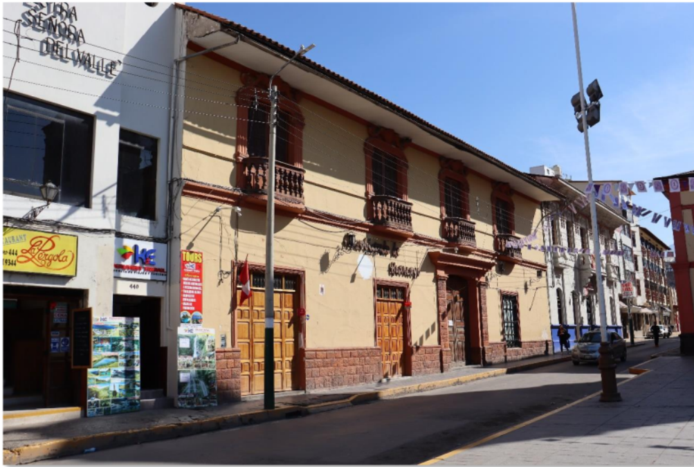
Fotografía frontal (PC 5): JR. PUNO N° 430 ARZOBISPADO DE HUANCAYO Fuente: Elaboración propia
