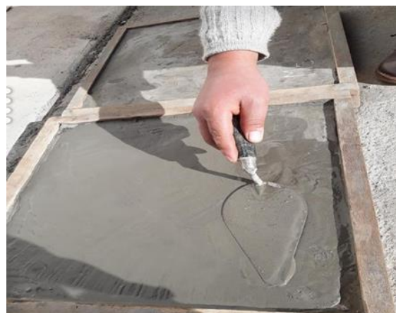
Aplicación del impermeabilizante
