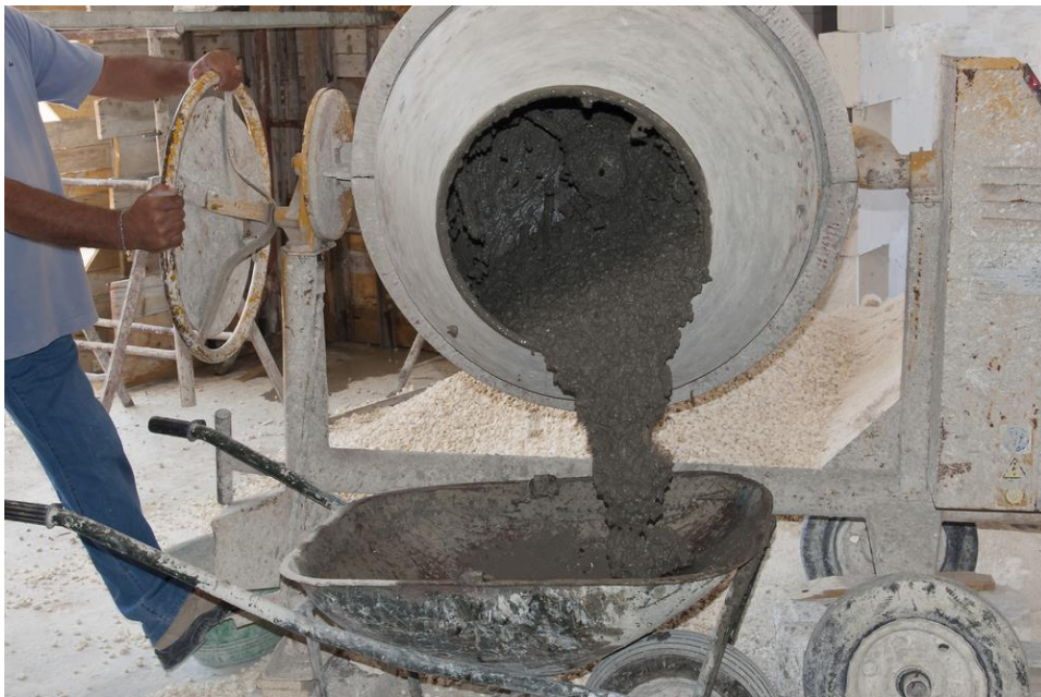
Figura 7 Proceso de mezclado del concreto
