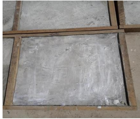
Colocación de la piedra alumbre molida con agua en la estufa
