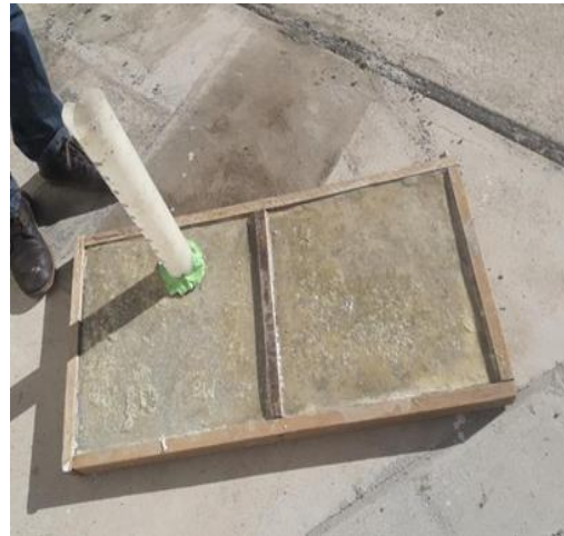
Ensayo de permeabilidad después de la aplicación del impermeabilizante
