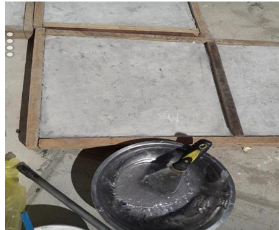
Impermeabilizante listo para ser aplicado.
