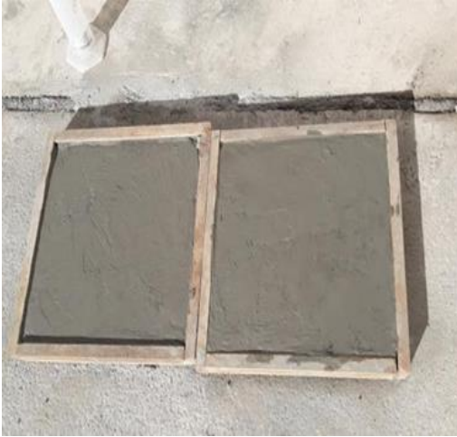
Estado final luego de la aplicación del impermeabilizante.
