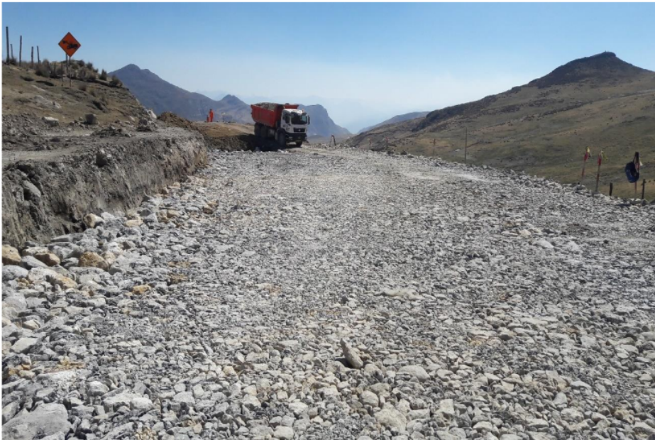
Foto N°18. Mejoramiento de Subrrasante
