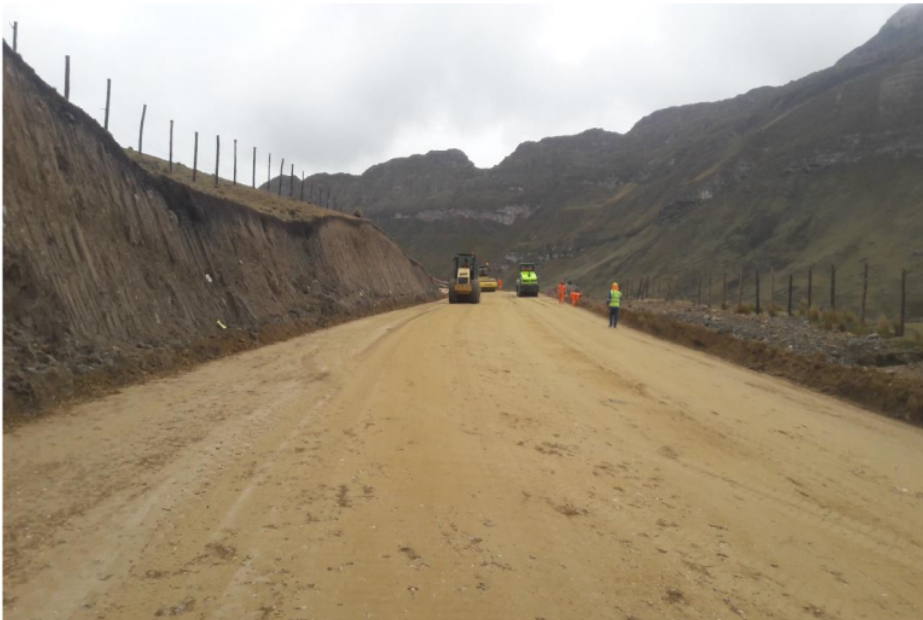
Foto N°32. Trabajos de explanaciones. Conformacion de base
