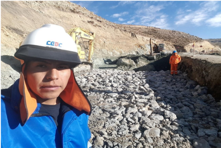
Foto N°14. Mejoramiento de Subrrasante (espolones y colchones drenante)
