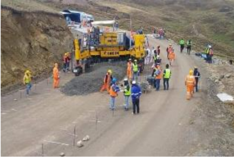
Foto N°43. Colocación de Pavimento Rígido
