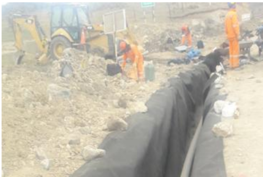
Foto N°40. Colocación de Geomantas en los subdrenes.
