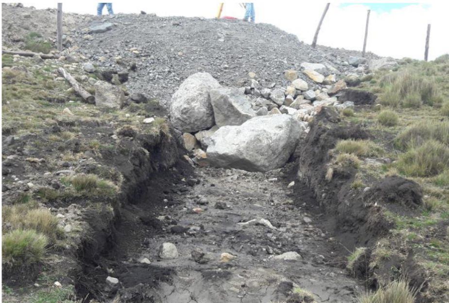
Foto N°28. Mejoramiento de Subrasante. Desfogue a traves de espolones
