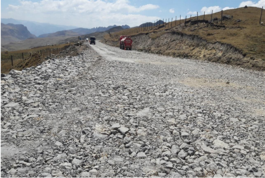
Foto N°25. Mejoramiento de Subrasante
