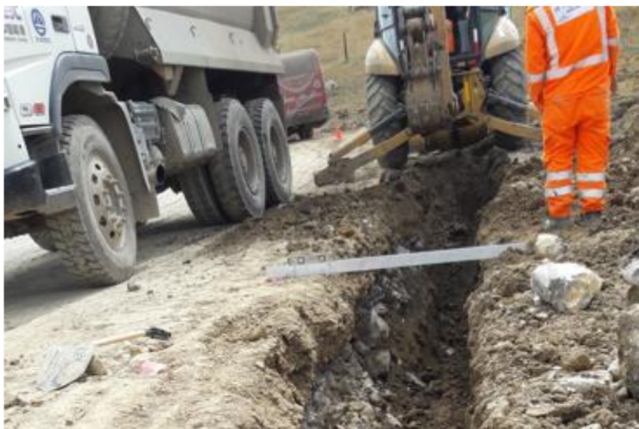
Foto N°39. Excavacion para Subdrenes.
