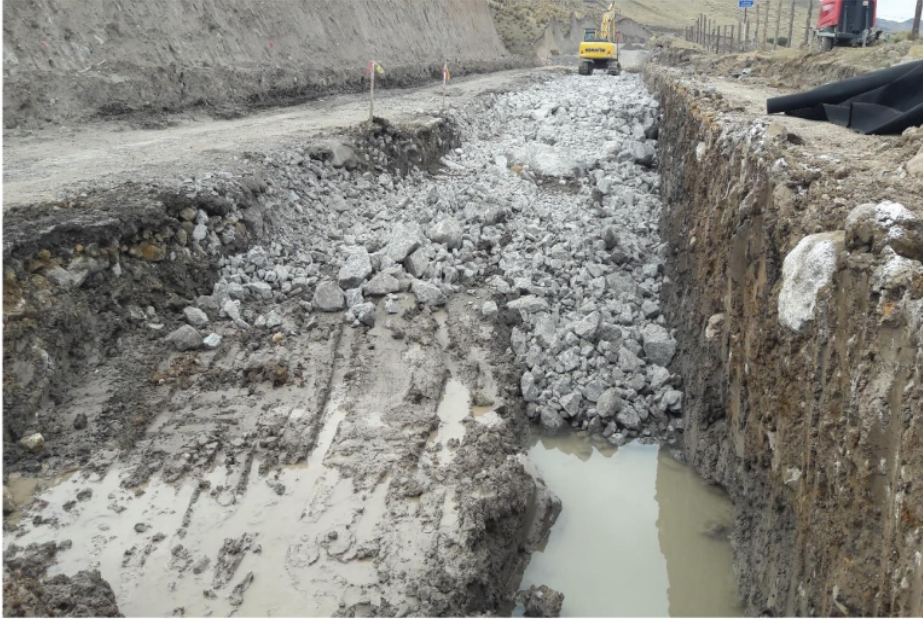
Foto N°9. Mejoramiento de Subrasante (espolones)
