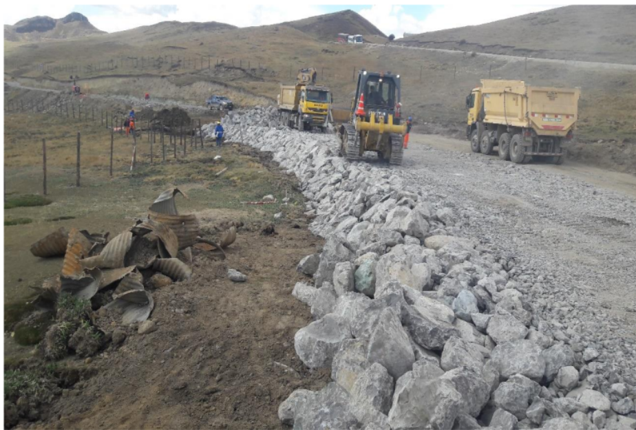
Foto N°20. Mejoramiento de Subrasante
