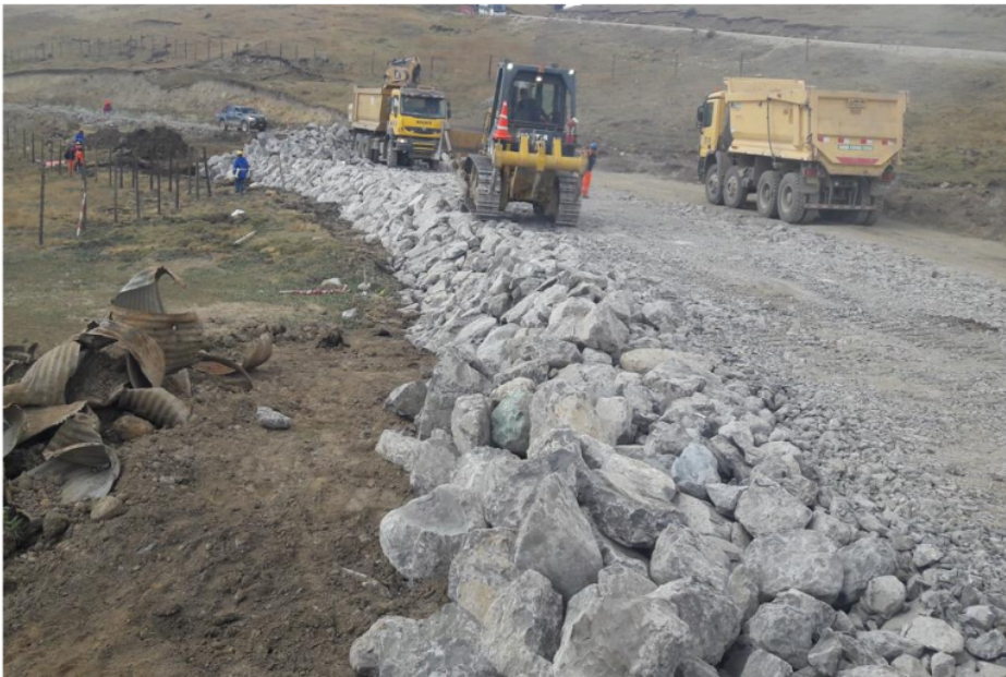
Foto N°16. Mejoramiento de Subrrasante (espolones y colchones drenante)
