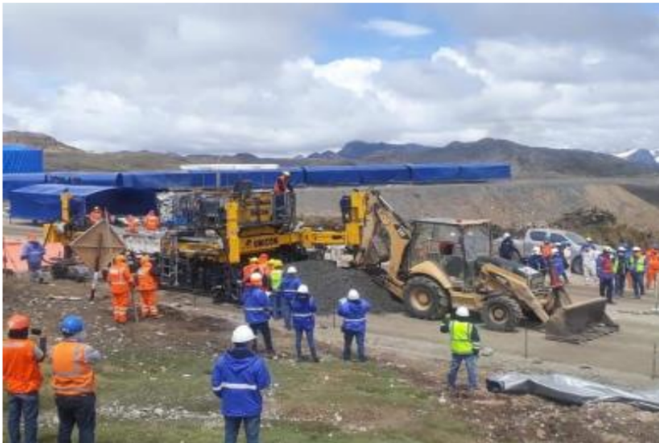
Foto N°42. Colocacion de Pavimento Rigido
