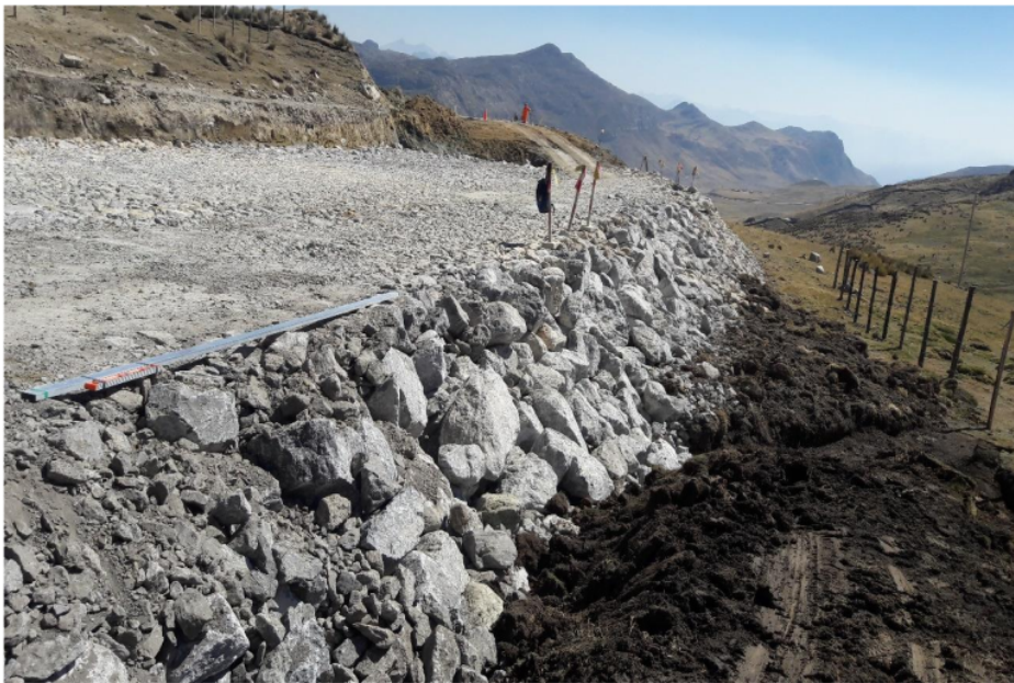
Foto N°24. Mejoramiento de Subrrasante
