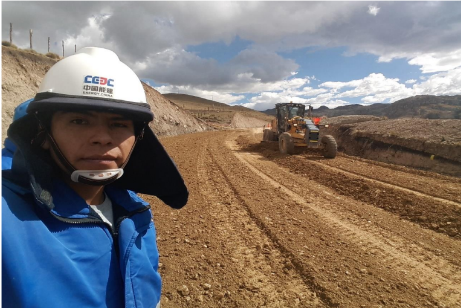
Foto N°29. Trabajos de explanaciones. Conformacion de base
