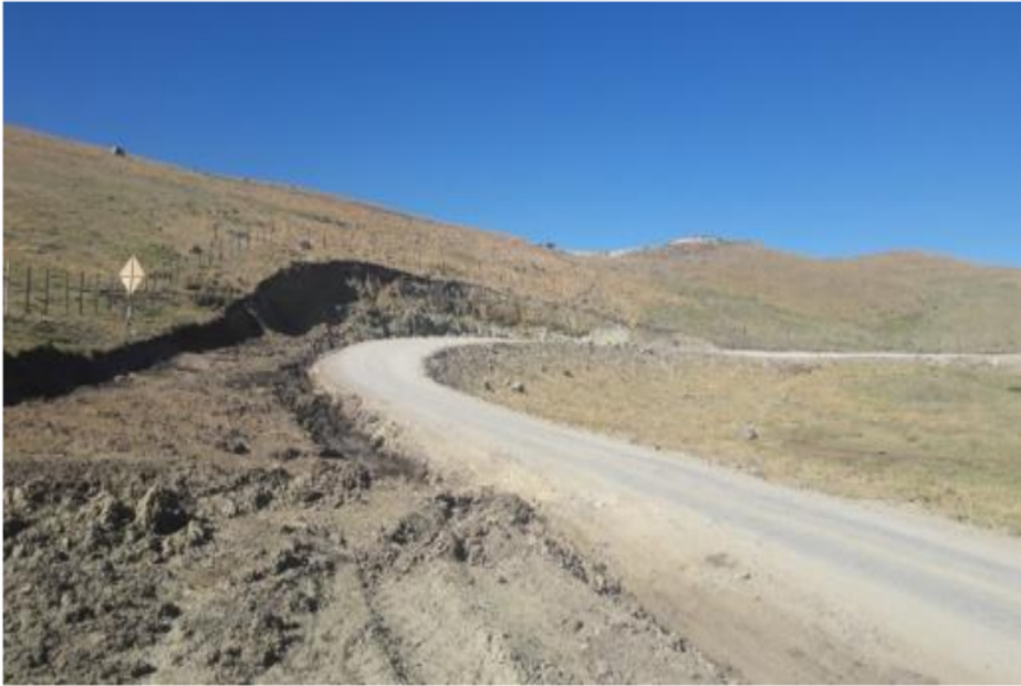
Foto N°4. Trabajos de movimiento de tierras. Zona de Corte
