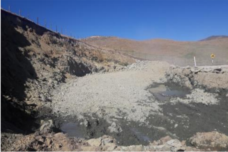
Foto N°5. Trabajos de movimiento de tierras. Mejoramiento de Subrrasante
