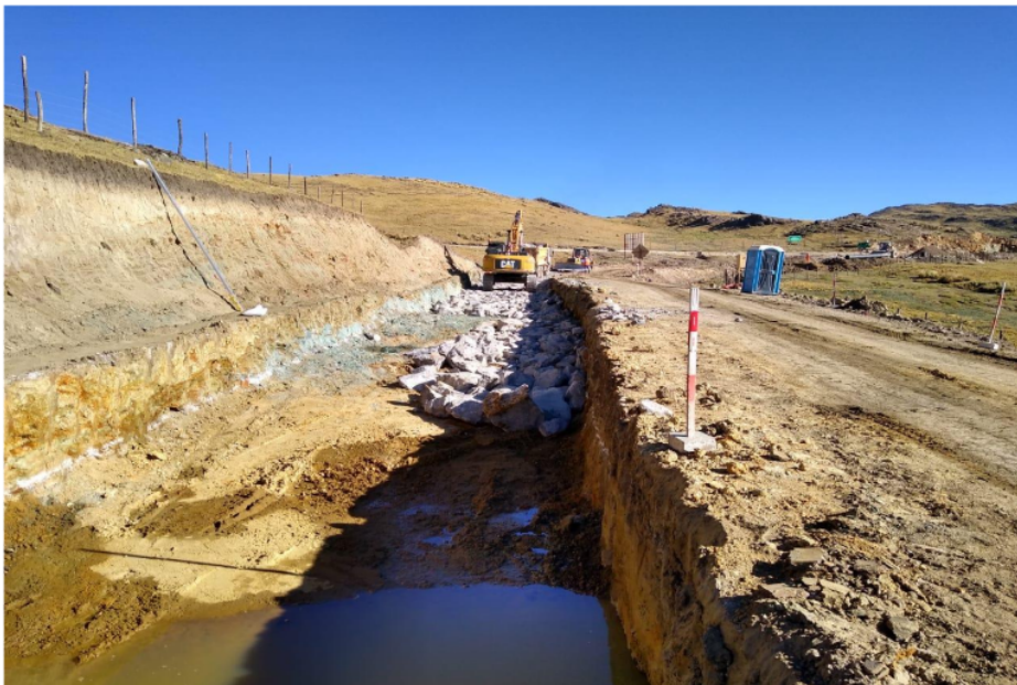
Foto N°12. Mejoramiento de Subrrasante (espolones y colchones drenante)
