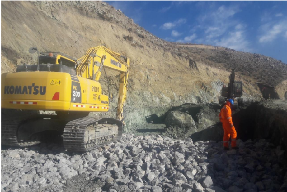
Foto N°11. Mejoramiento de Subrrasante (espolones y colchones drenante)
