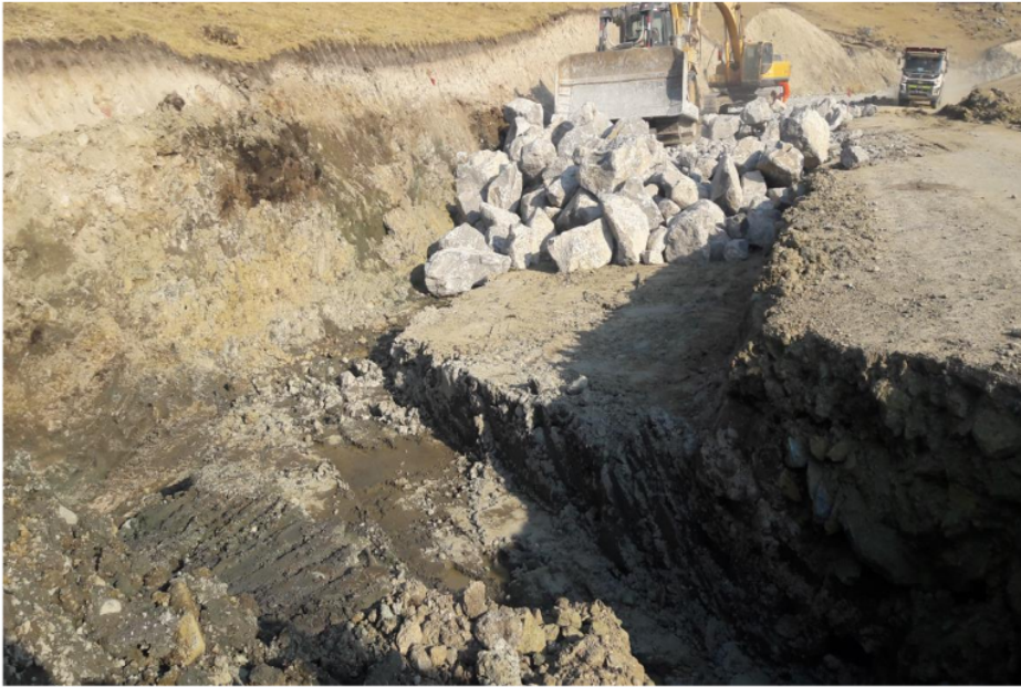
Foto N°10. Mejoramiento de Subrasante (espolones)
