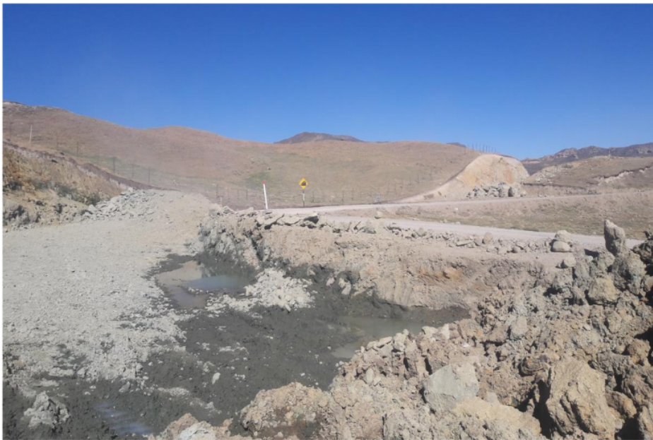
Foto N°8. Trabajos de movimiento de tierras. Mejoramiento de Subrasante
