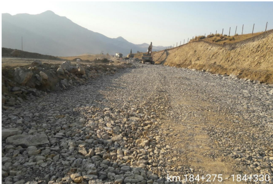
Foto N°19. Mejoramiento de Subrasante
