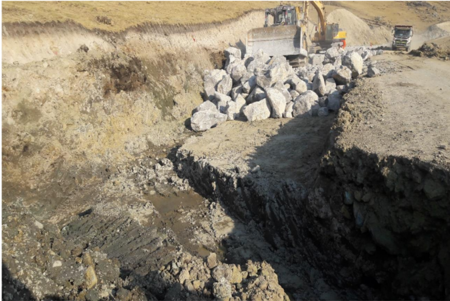
Foto N°13. Mejoramiento de Subrrasante (espolones y colchones drenante)
