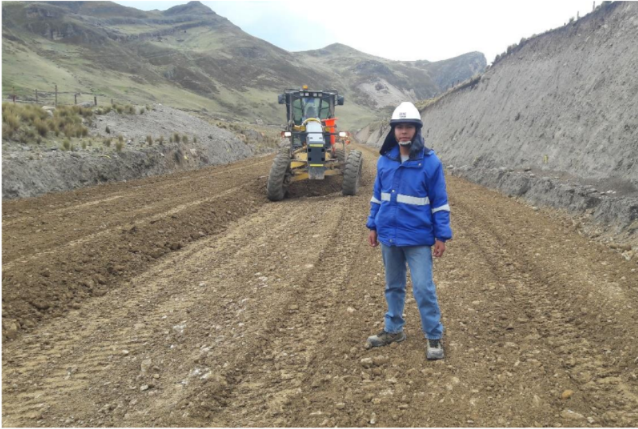
Foto N°31. Trabajos de explanaciones. Conformacion de base
