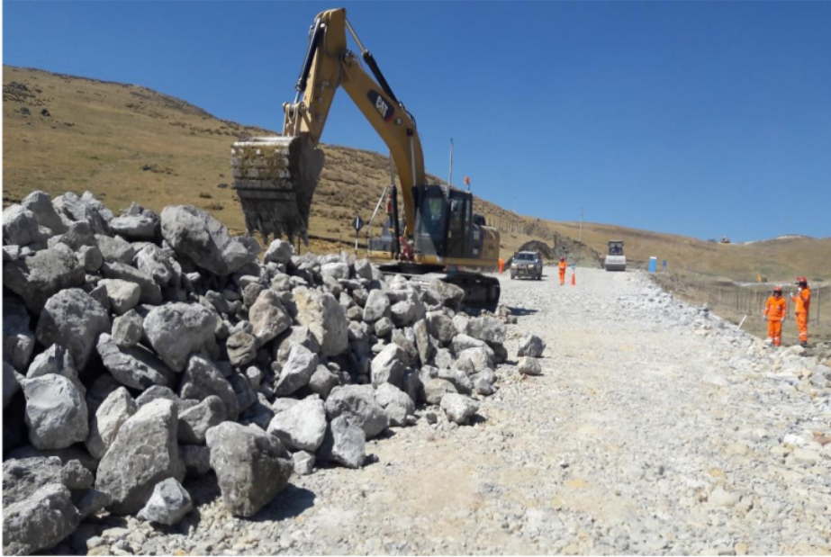
Foto N°21. Mejoramiento de Subrasante
