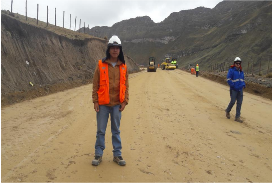
Foto N°33. Trabajos de explanaciones. Conformación de base
