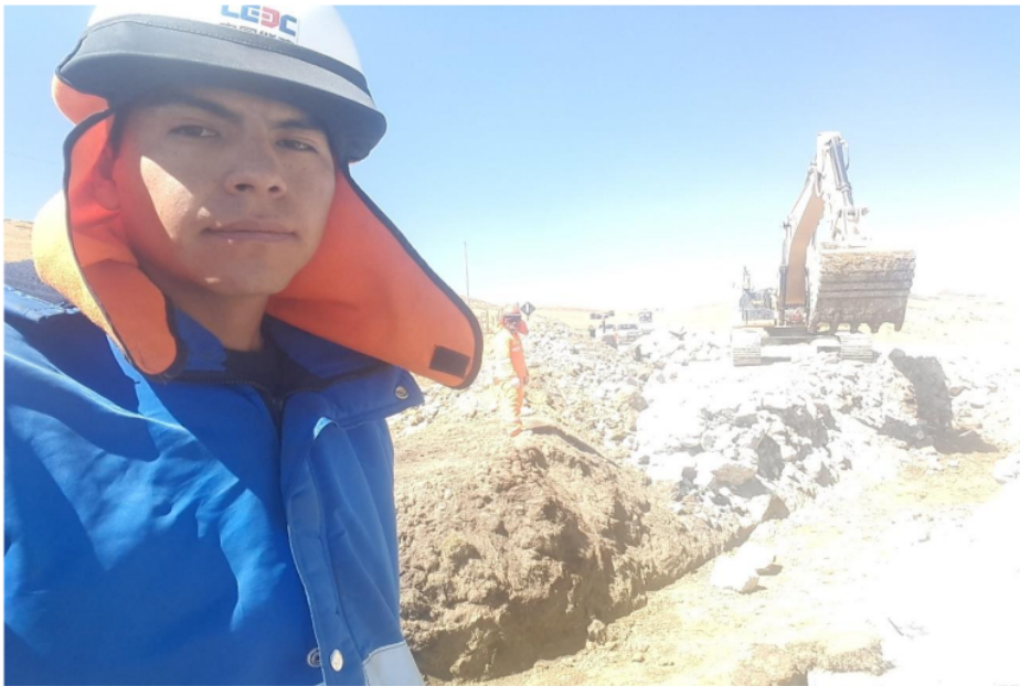
Foto N°23. Mejoramiento de Subrrasante
