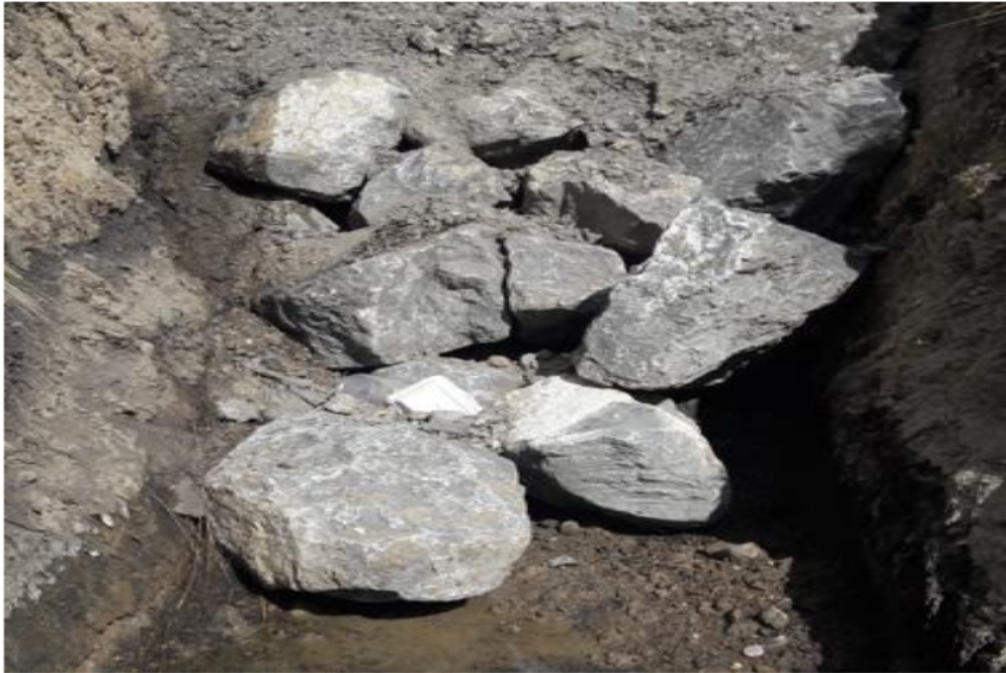
Foto N°27. Mejoramiento de Subrasante. Desfogue a traves de espolones
