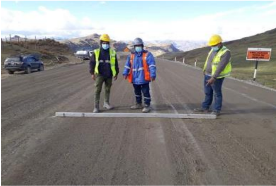
Foto N°37. Trabajos de explanaciones. Conformacion de base
