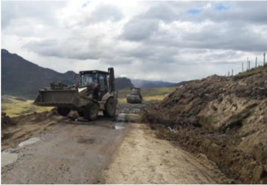
Foto N°1. Trabajos de movimiento de tierras. Zona de Corte
