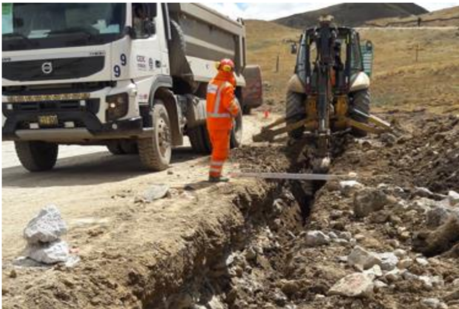
Foto N°38. Excavacion para Subdrenes.
