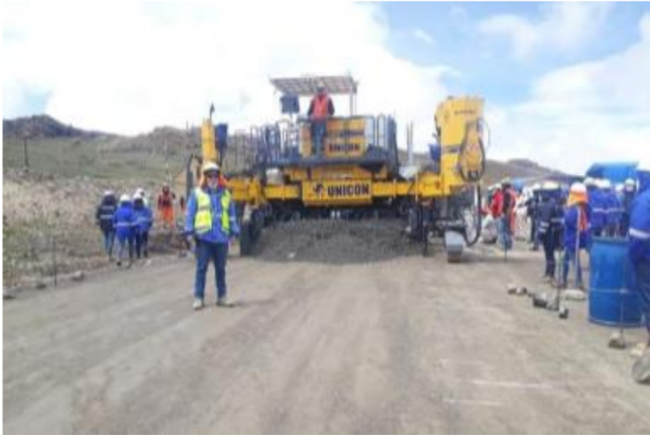
Foto N°41. Colocacion de Pavimento Rigido
