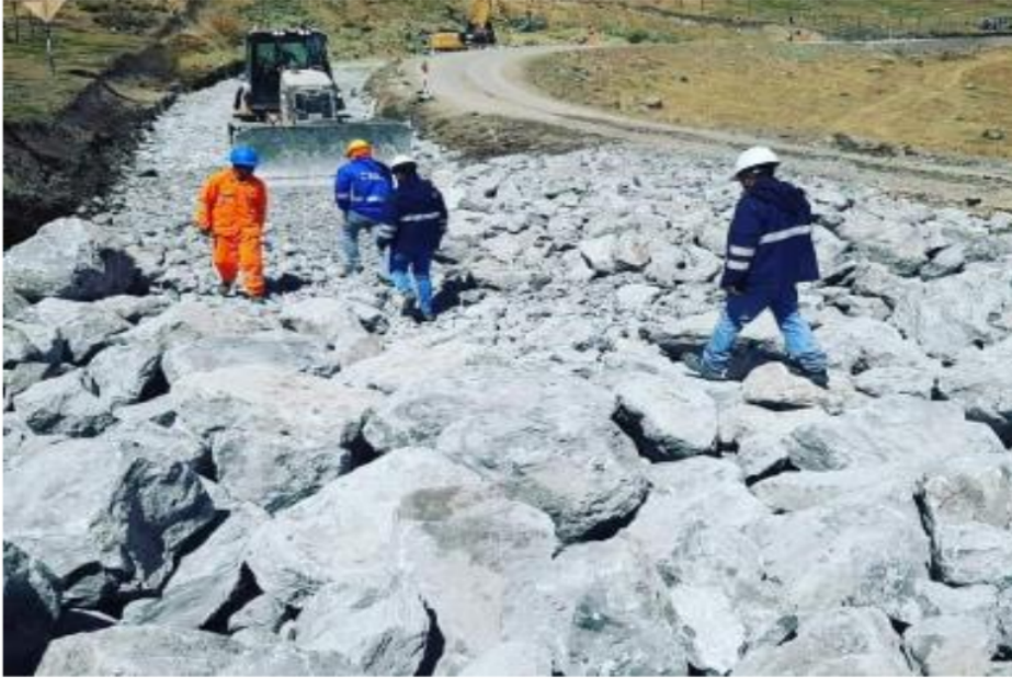
Foto N°15. Mejoramiento de Subrrasante (espolones y colchones drenante)
