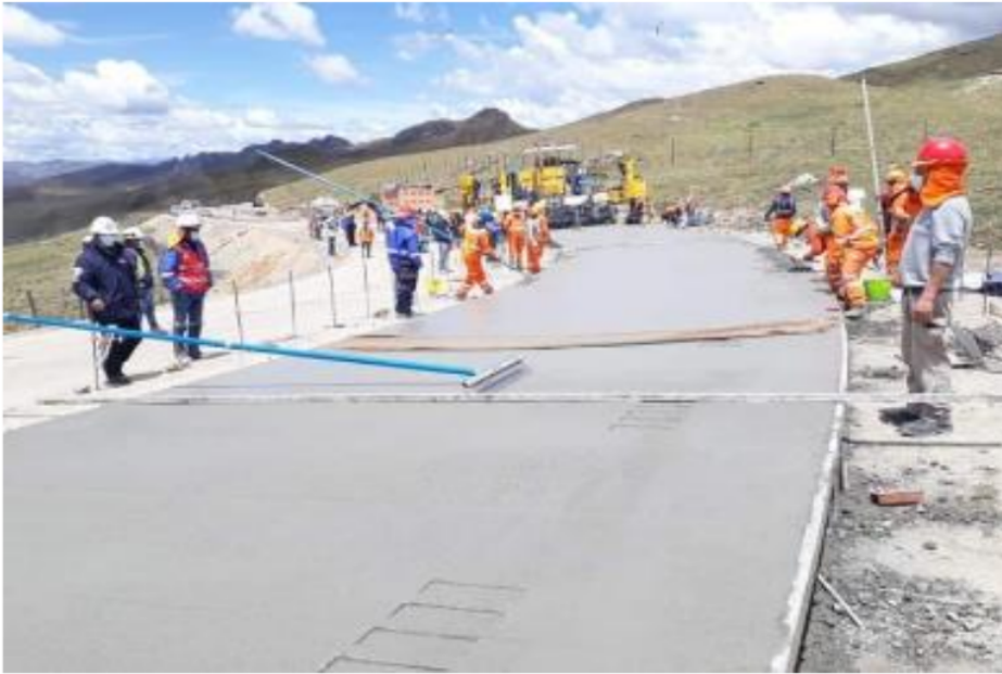
Foto N°44. Colocación de Pavimento Rígido
