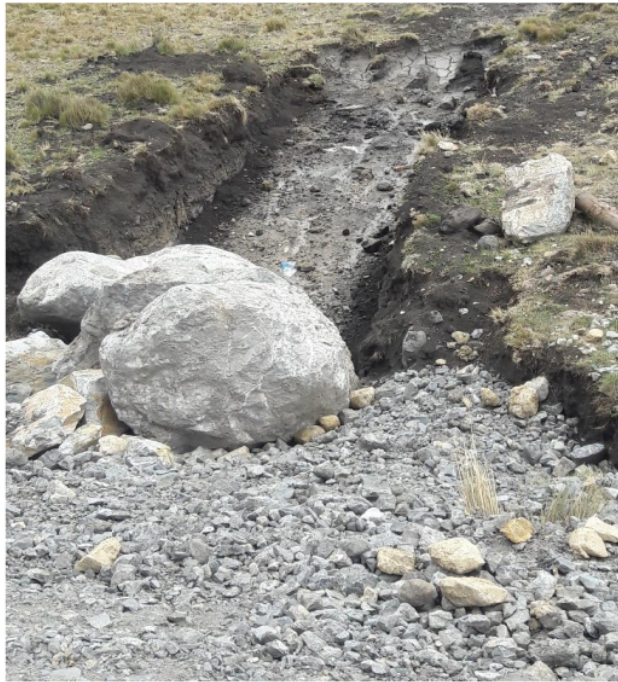
Foto N°26. Mejoramiento de Subrasante. Desfogue a traves de espiones
