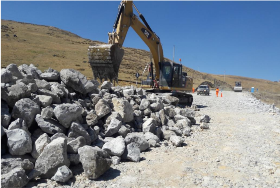
Foto N°17. Mejoramiento de Subrrasante (espolones y colchones drenante)
