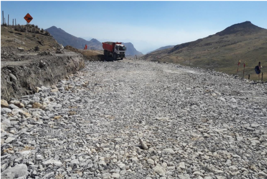
Foto N°22. Mejoramiento de Subrasante
