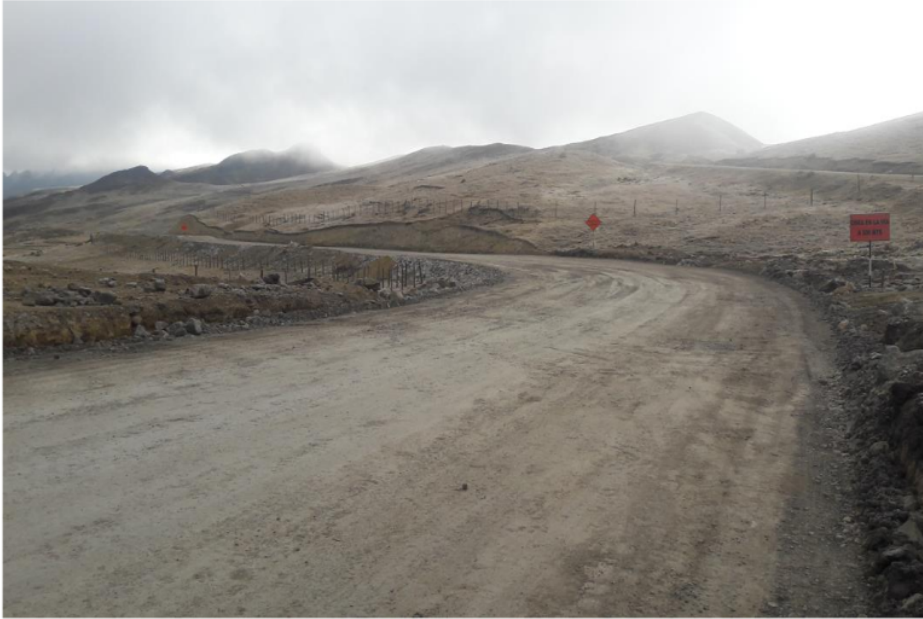
Foto N°35. Trabajos de explanaciones. Conformacion de base
