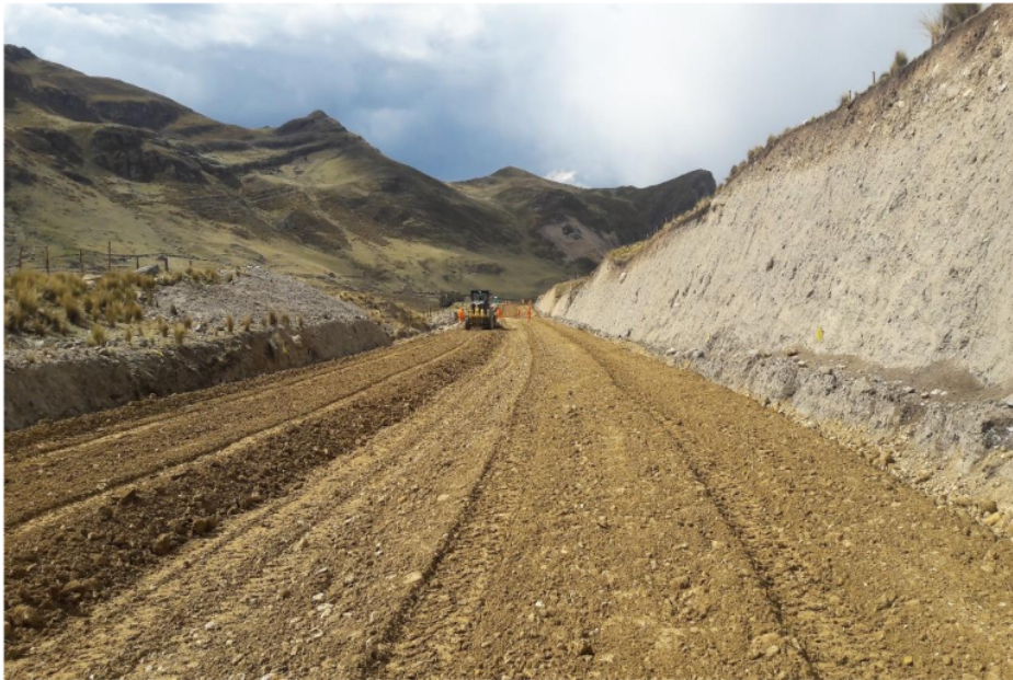
Foto N°30. Trabajos de explanaciones. Conformacion de base
