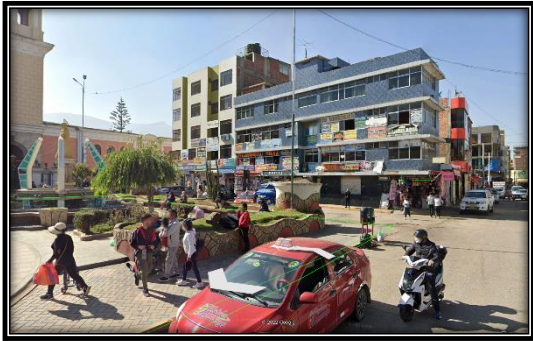
Construcciones de 5 pisos de material de concreto
