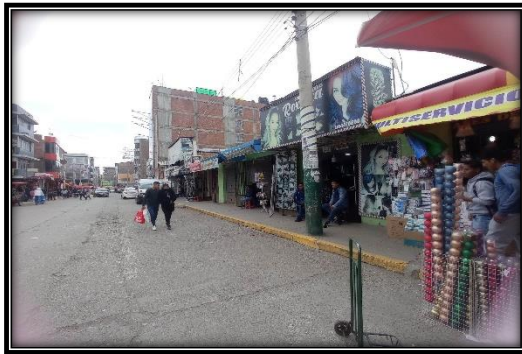
Construcciones de un solo piso
