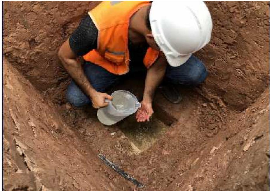
Figura 23 Excavación de la calicata C – 03
