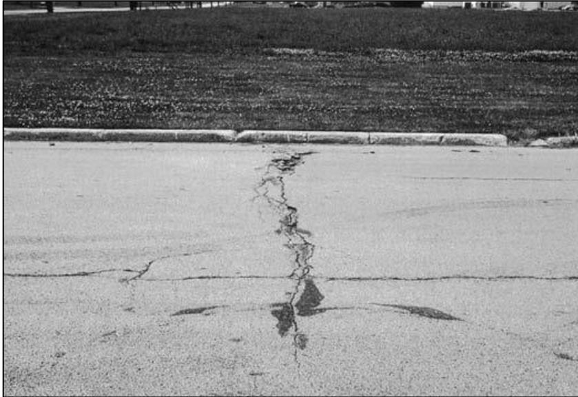
*Figura 11: Grietas longitudinales y transversales de alta gravedad
