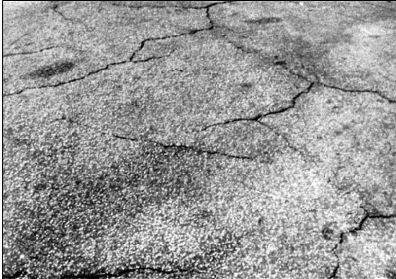
*Figura 4: Agrietamiento en bloque de alta gravedad
