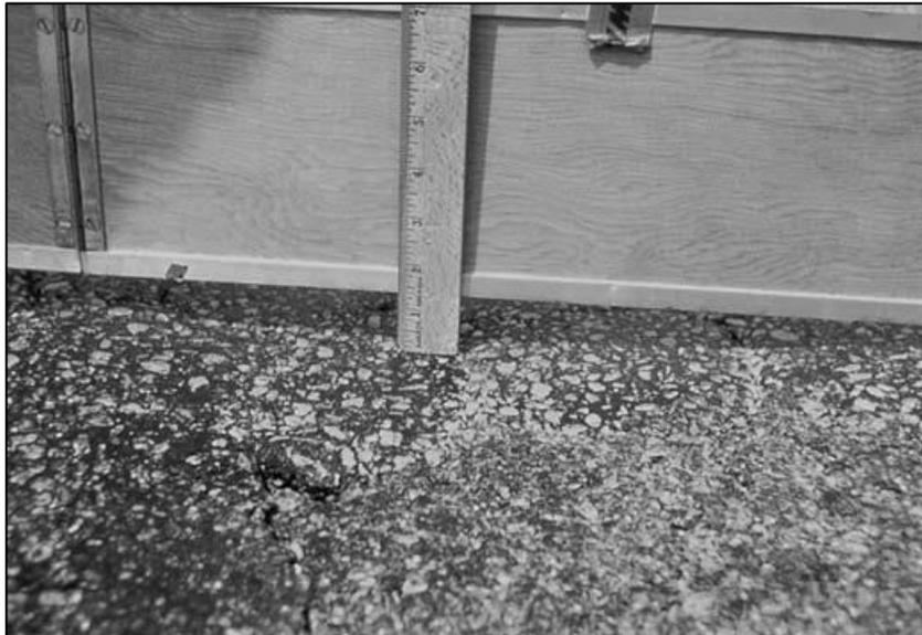
*Figura 16: Ahuellamiento de alta gravedad
