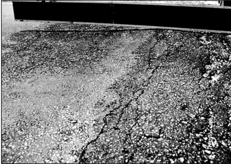
*Figura 5: Abultamientos y hundimientos de alta gravedad
