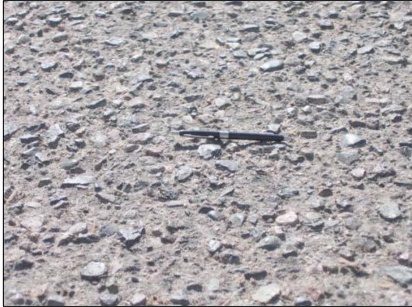
*Figura 20: Desprendimiento de agregados de alta severidad
