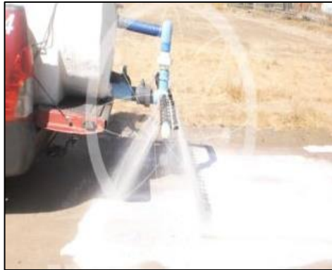
Figura 14: Maquinaria en proceso de esparción de polímero
