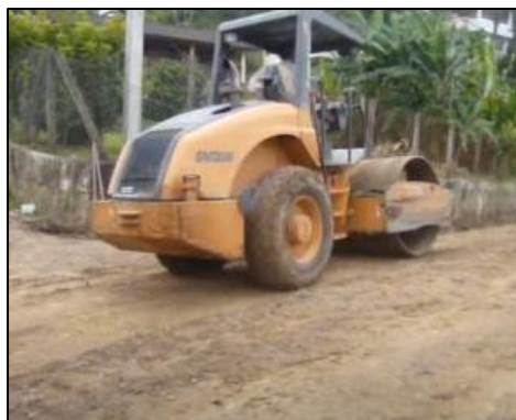
Figura 16: Rodillo realizando el proceso de compactación
