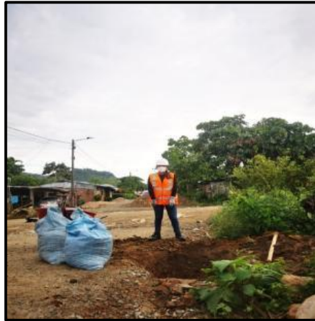
Figura 18: Excavación de calicata y extracción de material en el Jr. Atahualpa, Provincia de Satipo.
