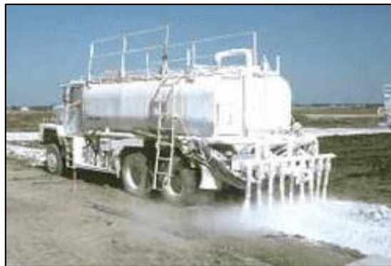
Figura 8: Estabilización con cal
