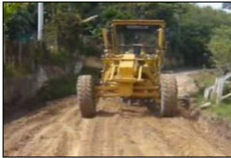
Figura 15: Maquinaria en el proceso de mezclado entre polímero y suelo
