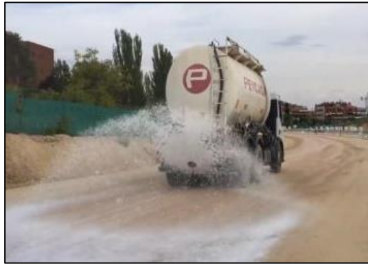
Figura 17: Riegos finales del sellado
