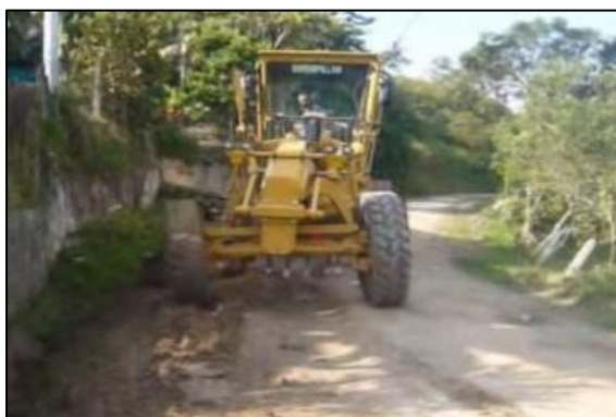
Figura 12: Maquinaria realizando proceso de limpieza
