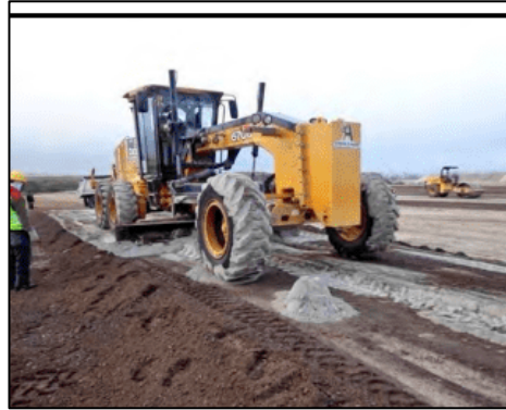
Figura 9: Estabilización con cemento
