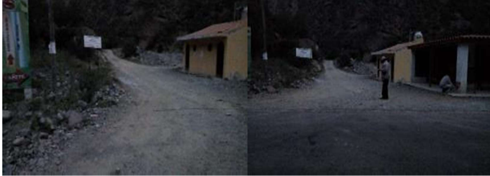
Inicio del Tramo con afirmado en estado de conservación regular (Km. 0+000)
