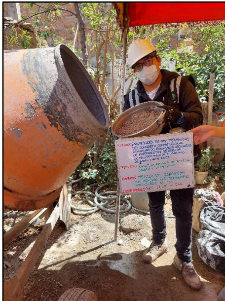
Fotografía N° 36: Vista de materiales tales como el agregado fino para la elaboración del concreto con adición con 4% de escombros reciclados, según referencia de la norma NTP 339.183.
