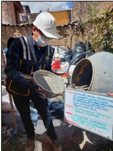
Fotografía N° 46: Vista de materiales tales como el cemento para la elaboración del concreto con adición del 6% de escombros reciclados, según referencia de la norma NTP 339.183.
