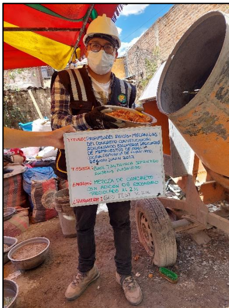
Fotografía N° 26: Vista particular de la ceniza volante con peso requerido del 2% de escombro reciclado su mezcla del concreto; según referencia de la norma NTP 339.183.
