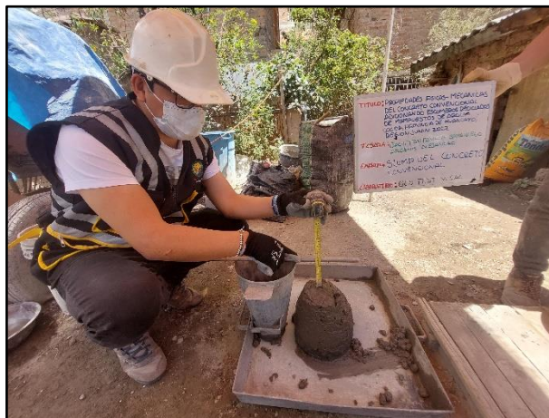
Fotografía N° 16: Medición del asentamiento del concreto convencional. Según NTP 339.035.
