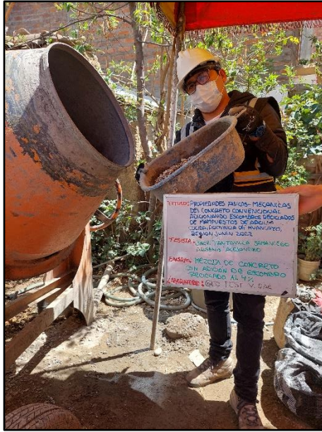
Fotografía N° 35: Vista de materiales tales como el agregado grueso para la elaboración del concreto con 4% de escombros reciclados, según referencia de la norma NTP 339.183.
