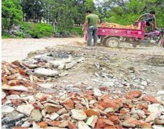
Figura N° 1. Desmontes de construcción eliminado en orillas de río
