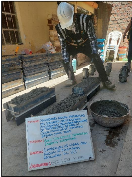
Fotografía N° 33: Elaboración de testigos rectangulares con 2% de escombro reciclado para sus respectivos tipos de ensayos, según referencia de la norma NTP 339.034 / ASTM C39.
