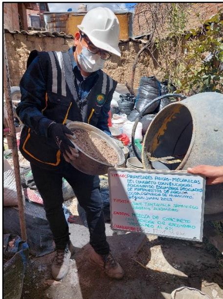
Fotografía N° 48: Vista de materiales tales como el agregado fino para la elaboración del concreto con adición del 6% de escombros reciclados, según referencia de la norma NTP 339.183.
