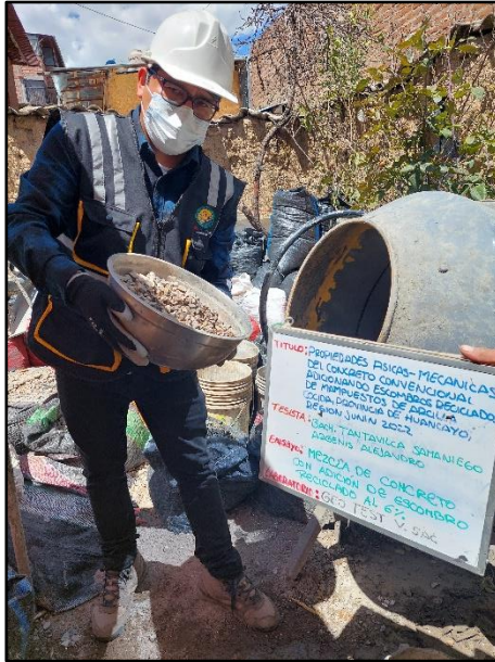
Fotografía N° 47: Vista de materiales tales como el agregado grueso para la elaboración del concreto con adición del 6% de escombros reciclados, según referencia de la norma NTP 339.183.
