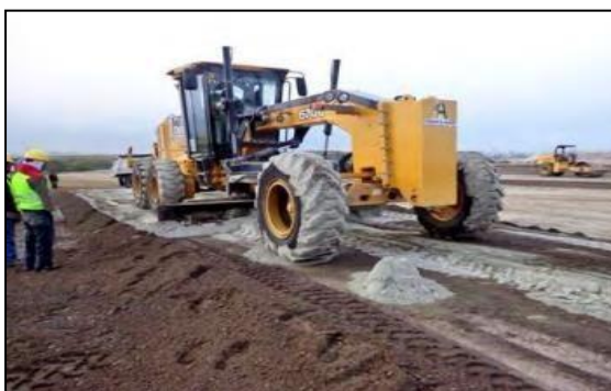
Figura 5. Tendido de cemento para estabilización de suelos natural
