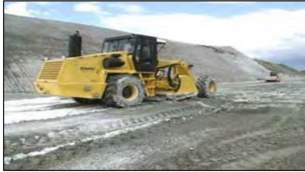
Figura 6. Estabilización con cal
