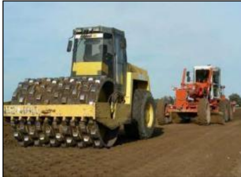
Figura 3. Proceso de estabilización por el método de compactación empleando un rodillo “pata de cabra”.
