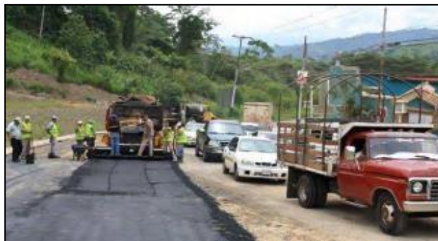
Figura 7. Proceso de estabilización de subrasante con el uso de asfalto.
