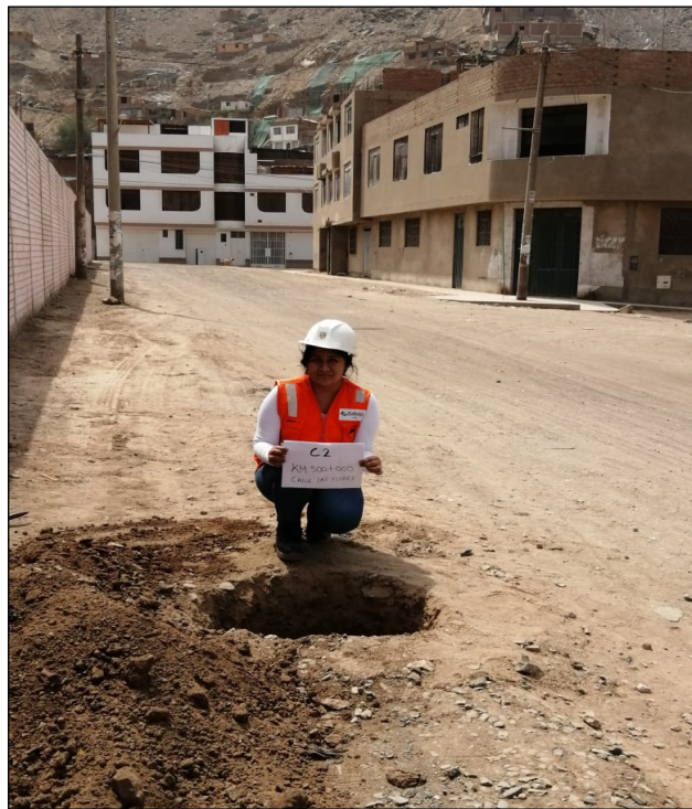
Fotografía 2. Extracción de muestra del progresivo km 0+500
