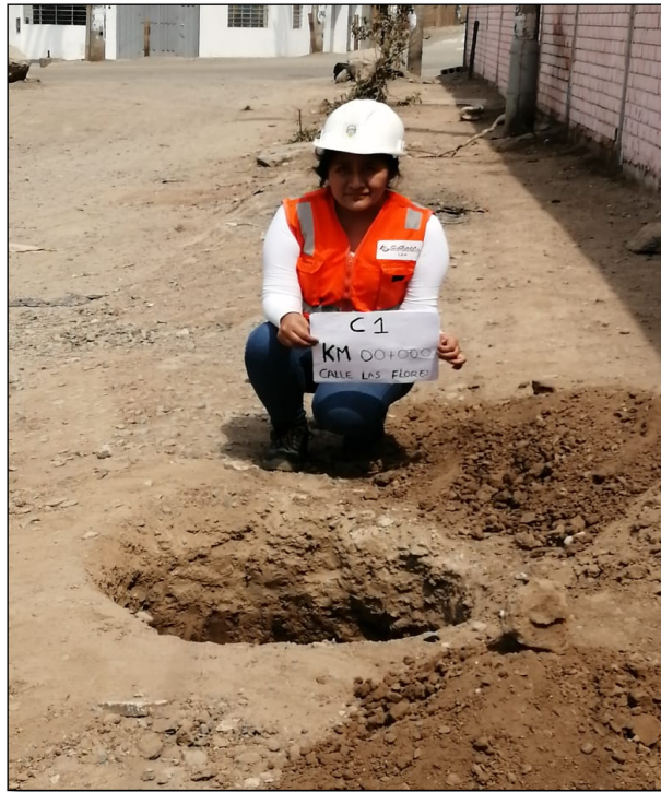
Fotografía 1. Extracción de muestra de la progresiva km 0+000.
