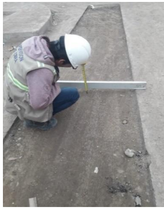
Figura 50 Verificación de nivelación para reposición de pavimento
