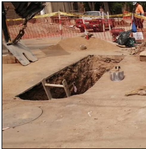
Figura 43 Corte de Ventana
