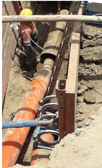
Figura 47 Empalmes de tubería HDPE
