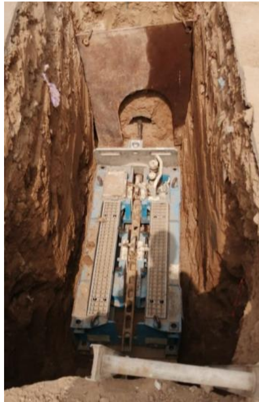
Figura 46 Colocación de equipo en ventanas del buzón
