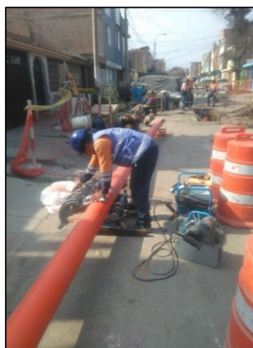
Figura 44 Termofusión o Soldadura de Tuberías
