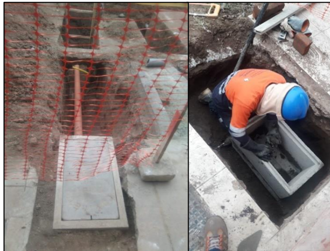
Figura 48 Empalmes de tubería HDPE
