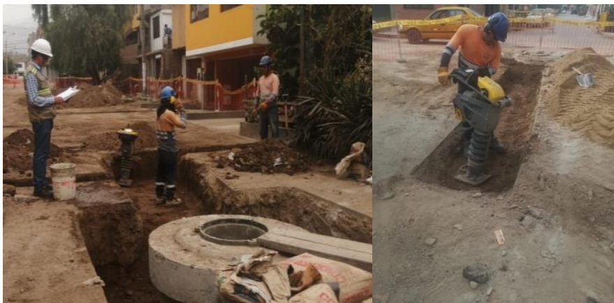
Figura 49 Relleno y compactación
