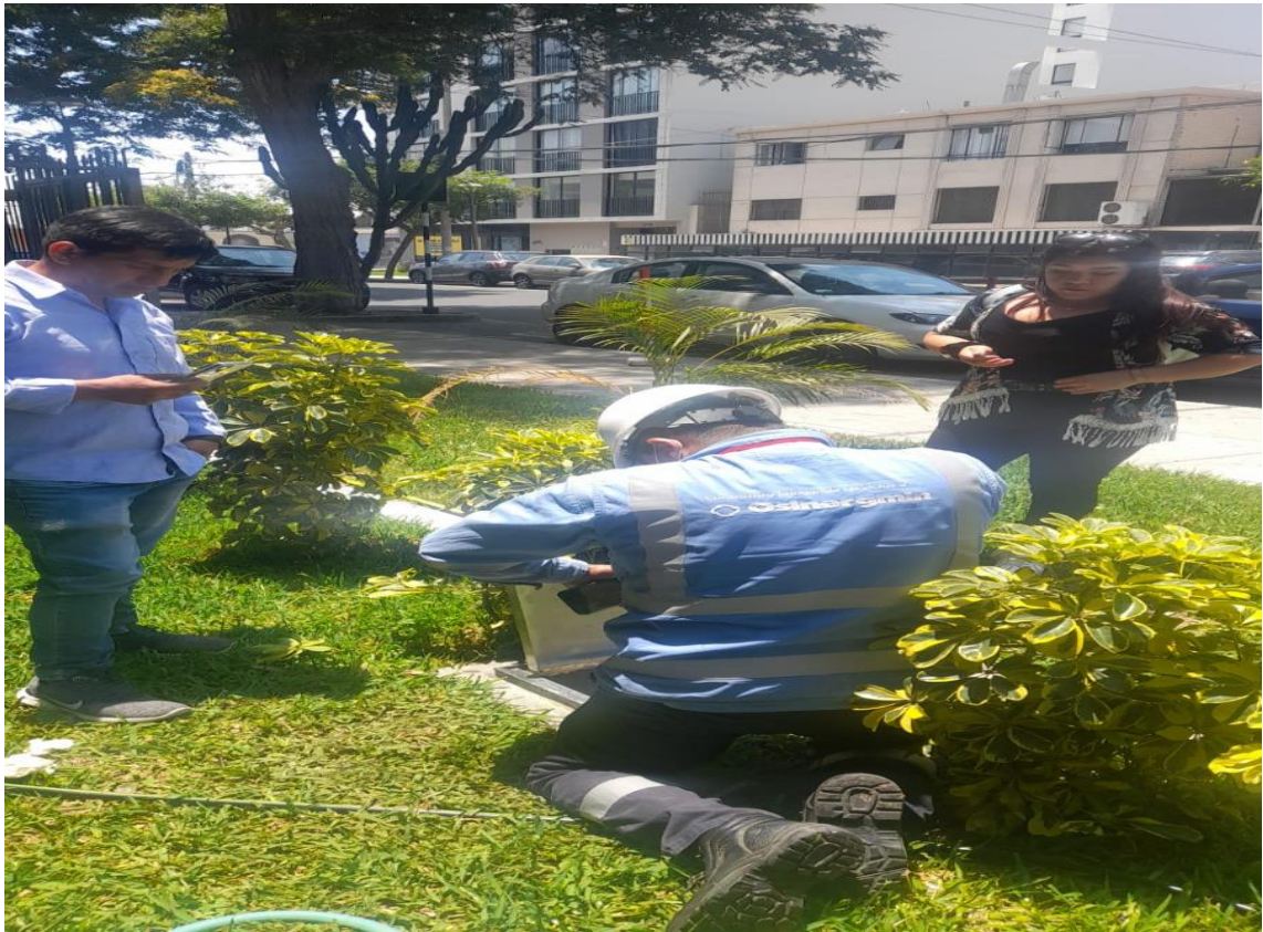
Fotografía 5: visita técnica de Osinergmin, validando red de Gas dual GLP y GNV
