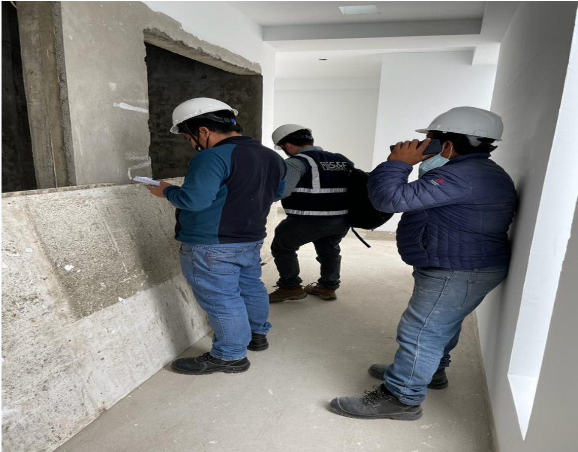
Fotografía 3: Inspección de vano para ascensor
