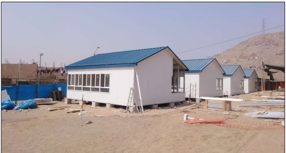
Proceso de Montaje de Estructuras – Aulas Tipo Costa
