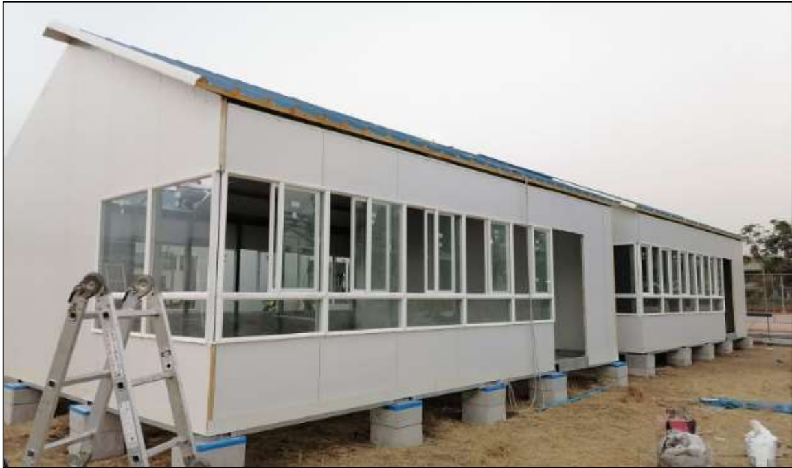
Proceso de Montaje de Estructuras – Aulas Tipo Costa
