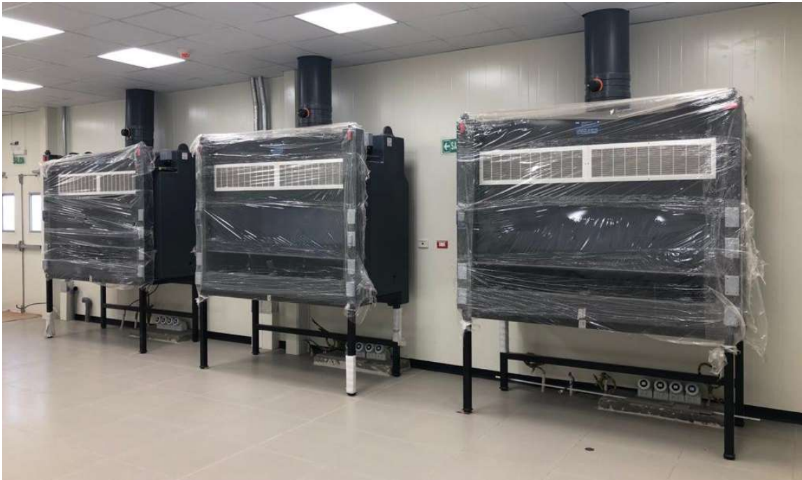
Laboratorio Químico – Vista Interior
