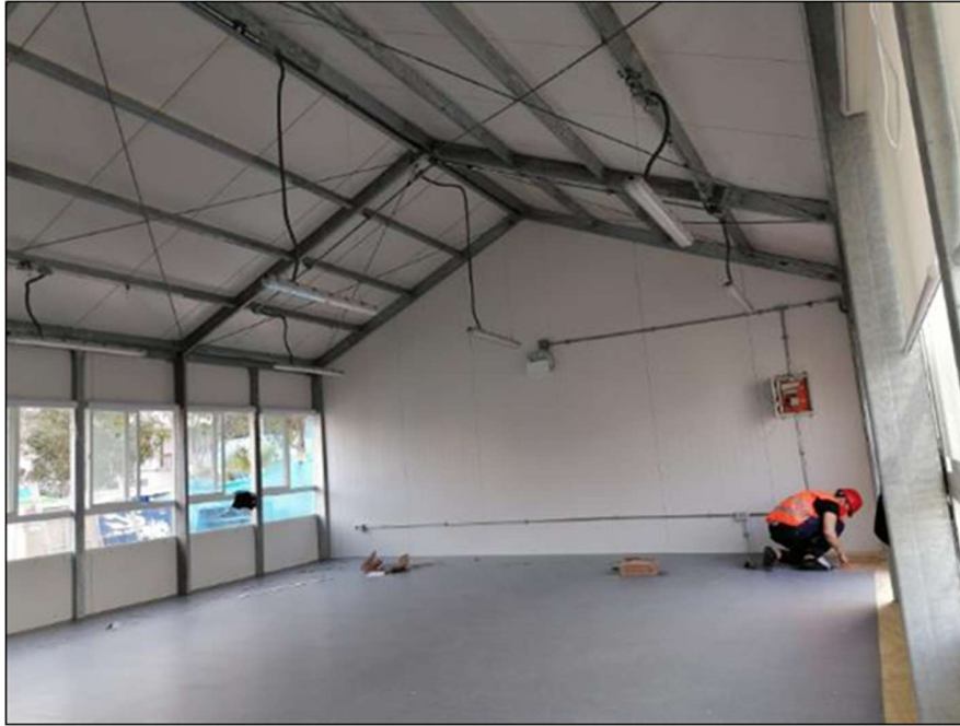
Proceso de Montaje de Estructuras – Aulas Tipo Costa
