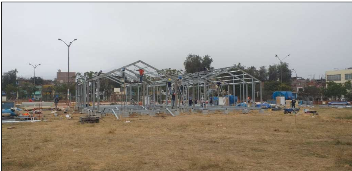
Proceso de Montaje de Estructuras – Aulas Tipo Costa
