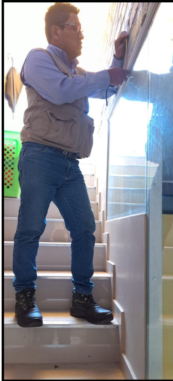
Recolección de datos de la losa aligerada de 20 cm de altura.
