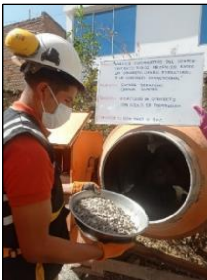
Fotografía N° 24: Vista de materiales tales como agregado grueso para la elaboración del concreto con adición de poliestireno expandido al 0.025%. Según NTP 339.183
