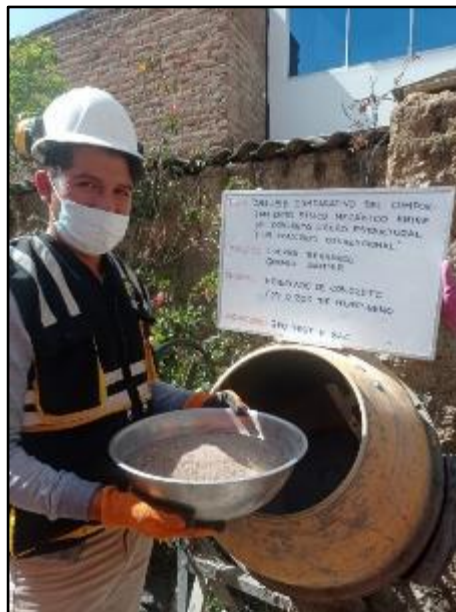
Fotografía N° 60: Vista de materiales tales como agregado fino para la elaboración del concreto con adición de poliestireno expandido al 0.20%. Según NTP 339.183.
