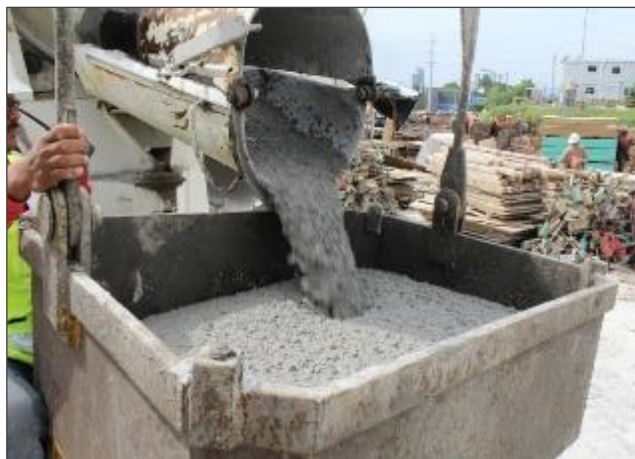
Figura 2: Concreto en obra.
