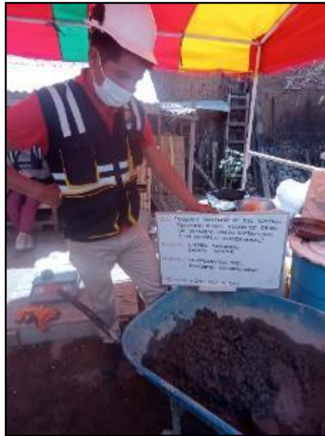
Fotografía N° 17: Medición de la temperatura del concreto convencional. Según NTP 339.184.
