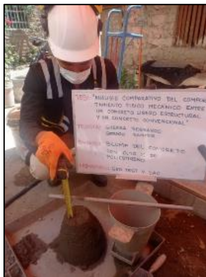
Fotografía N° 53: Medición del asentamiento del concreto con adición de poliestireno expandido al 0.10%.
