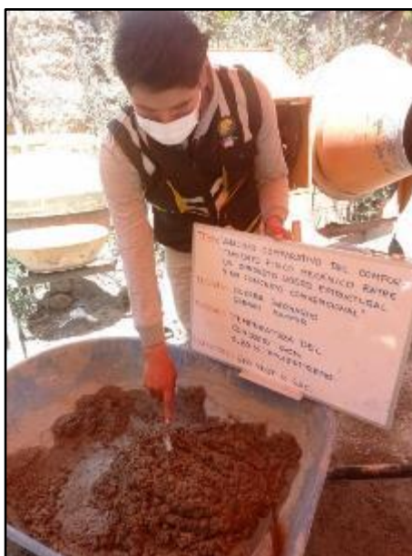
Fotografía N° 64: Medición de la temperatura del concreto con adición de poliestireno expandido al 0.20%. Según NTP 339.184 FUENTE: Elaboración propia.
