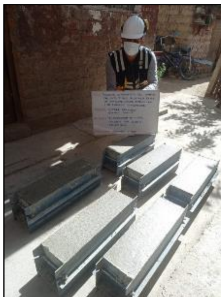
Fotografía N° 70: Elaboración de vigas de concreto con adición de poliestireno expandido al 0.20%. Según NTP 339.183.
