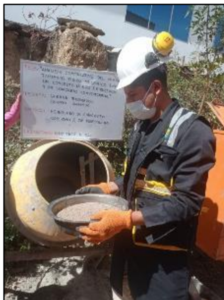
Fotografía N° 48: Vista de materiales tales como agregado fino para la elaboración del concreto con adición de poliestireno expandido al 0.10%. Según NTP 339.183.
