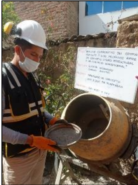
Fotografía N° 61: Vista de materiales tales como cemento para la elaboración del concreto con adición de poliestireno expandido al 0.20%. Según NTP 339.183.
