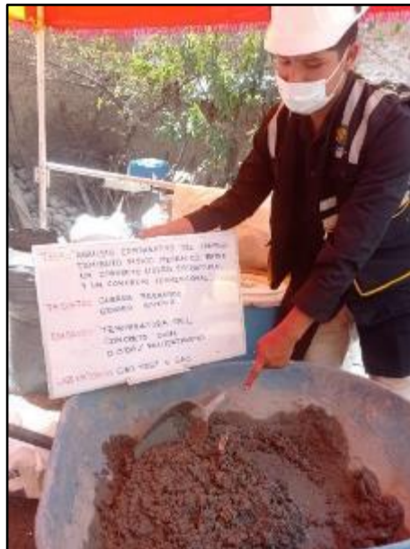
Fotografía N° 52: Medición de la temperatura del concreto con adición de poliestireno expandido al 0.10%. Según NTP 339.184 FUENTE: Elaboración propia.
