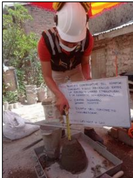
Fotografía N° 18: Medición del asentamiento del concreto fresco convencional. Según NTP 339.035.
