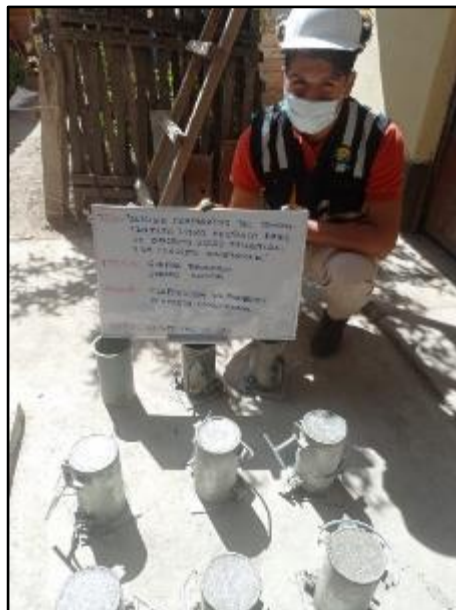
Fotografía N° 22: Elaboración de probetas de concreto convencional. Según NTP 339.183.
