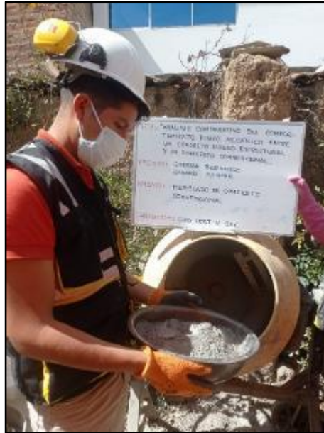
Fotografía N° 15: Vista de materiales tales como cemento para la elaboración del concreto convencional. Según NTP 339.183.
