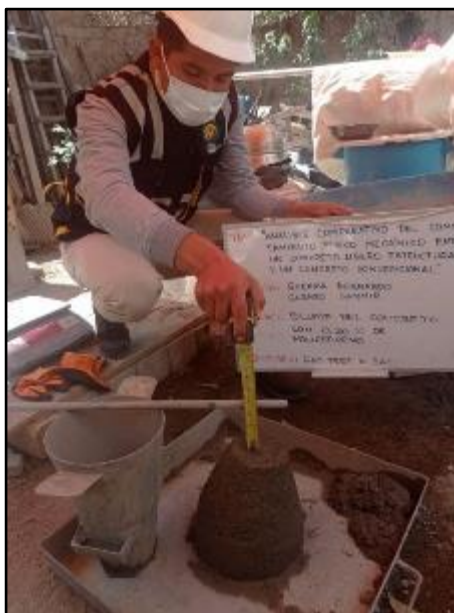
Fotografía N° 65: Medición del asentamiento del concreto con adición de poliestireno expandido al 0.20%. Según NTP 339.035
