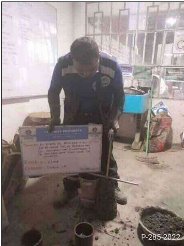
Fotografía 19. Medición del asentamiento del concreto mezclado durante 1.5 minutos.
