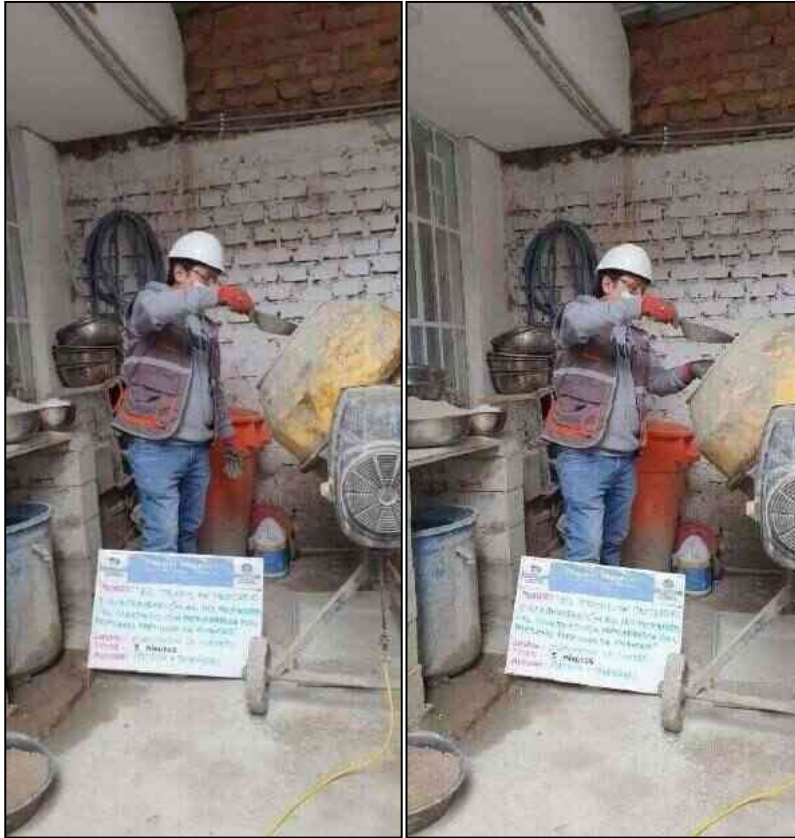
Fotografía 11. Preparación de las mezclas de concreto para un tiempo de mezclado de 5 minutos.
