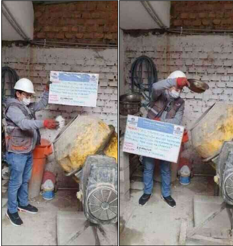
Fotografía 9. Preparación de las mezclas de concreto para un tiempo de mezclado de 1.5 minutos.
