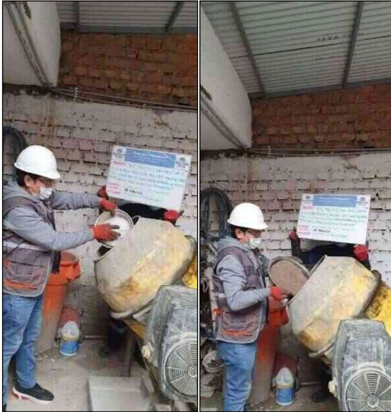
Fotografía 13. Preparación de las mezclas de concreto con macrofibras para un tiempo de mezclado de 15 minutos.
