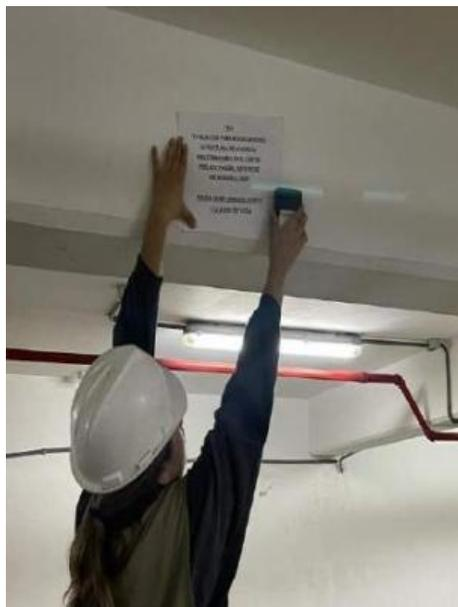
*Fotografía N° 4:* Identificación de aceros en vigas con escáner
