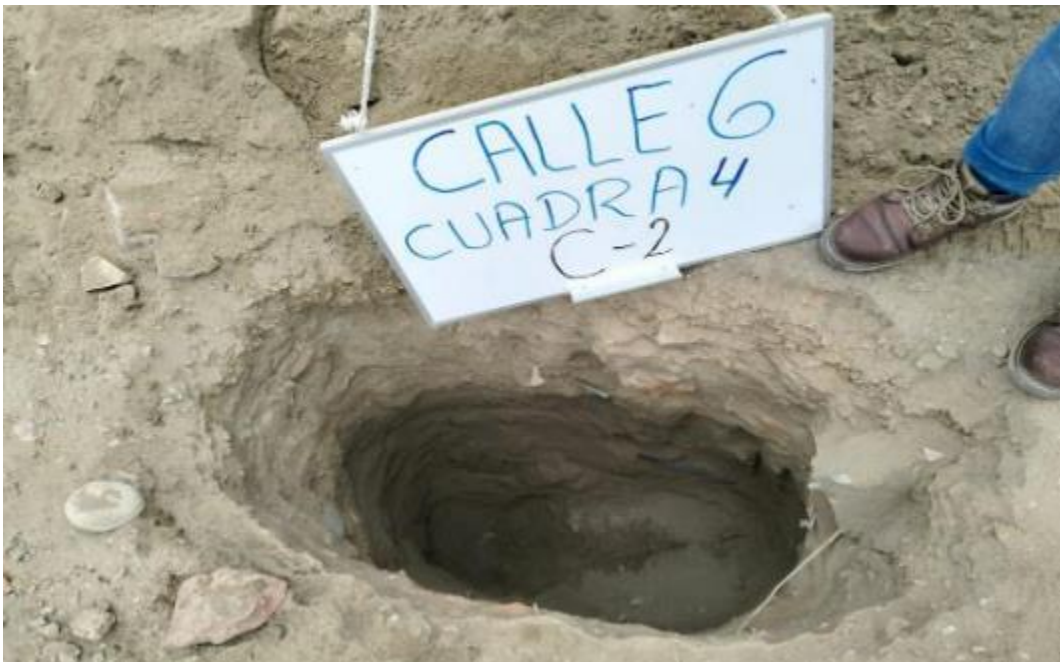
Foto N° 4.- Calicata C-2 a 1.80m de profundidad.
