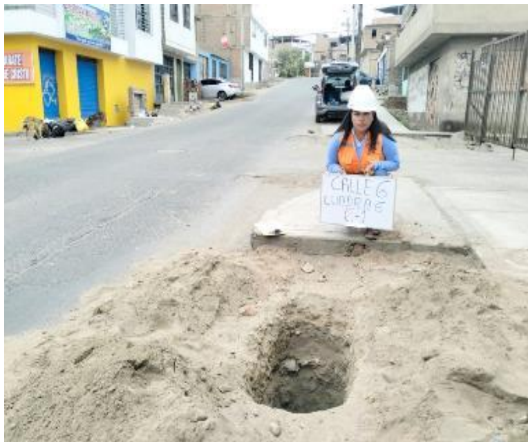
Figura 9. Calicata – C1 Fuente: Elaboración propia
