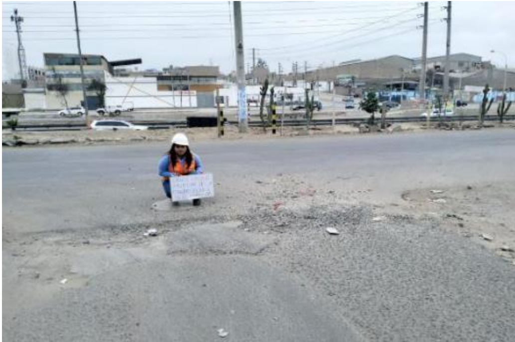
Foto N° 14.- Se observa asentamiento de 5cm, huecos, baches, peladuras fisuras.
