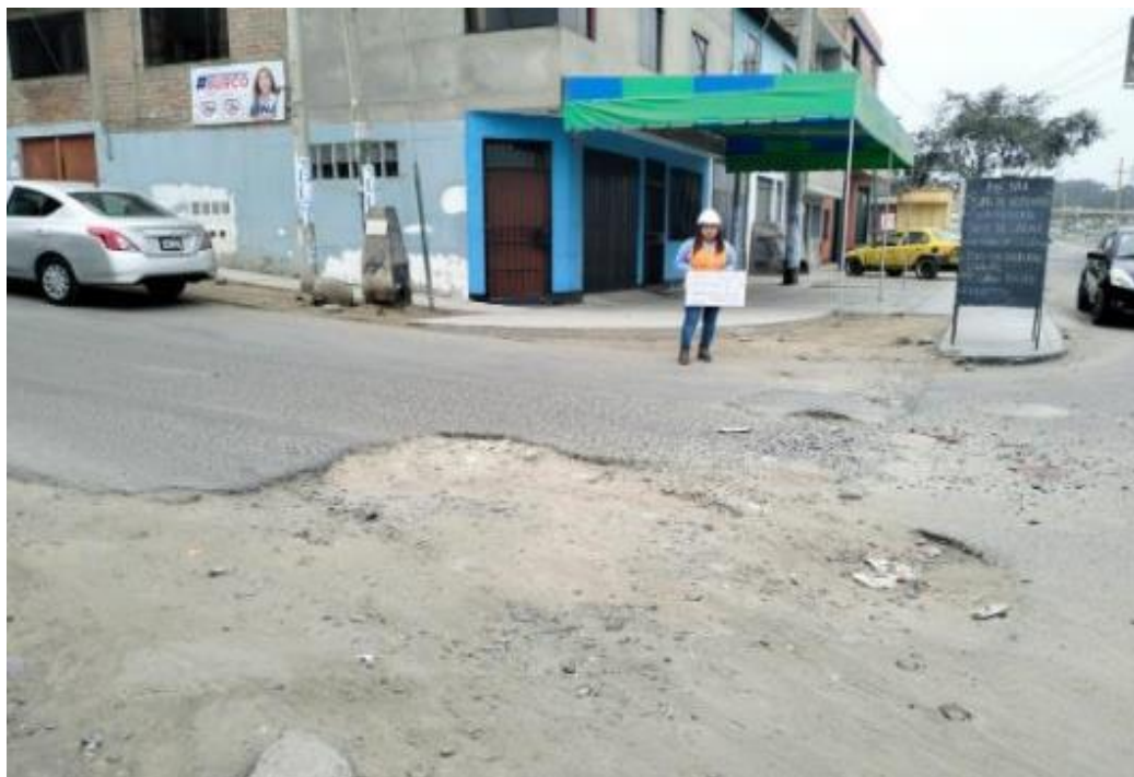
Foto N° 14.- Se observa asentamiento de 5cm, huecos, baches, peladuras fisuras.
