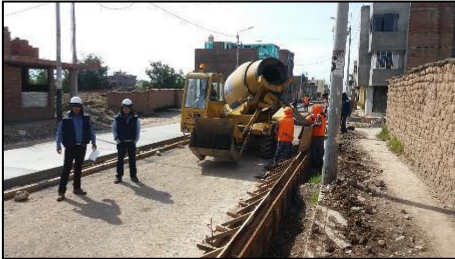
Figura 29 Objetivos de la Ejecución del Proyecto en la progresiva 0+080
