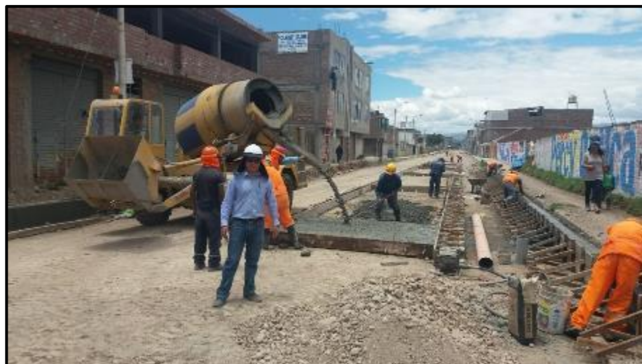
Figura 28 Control de espesor de concreto 0.20 m en el Jr. San Martín-Av. Coronel Parra progresiva 00+225
