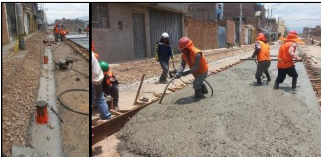
Figura 39 Control de calidad del Concreto – progresiva 0+180
