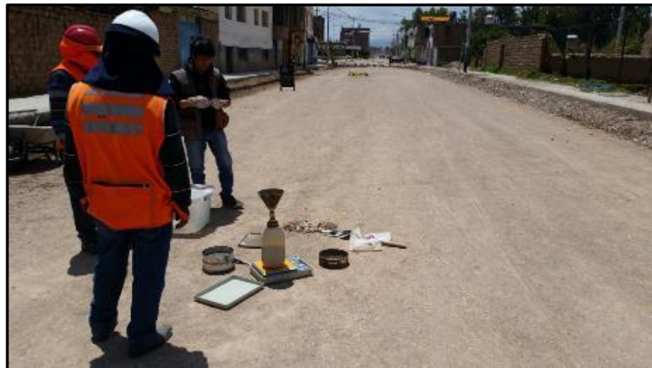
Figura 34 Prueba de densidad de Campo en la progresiva 0+060
