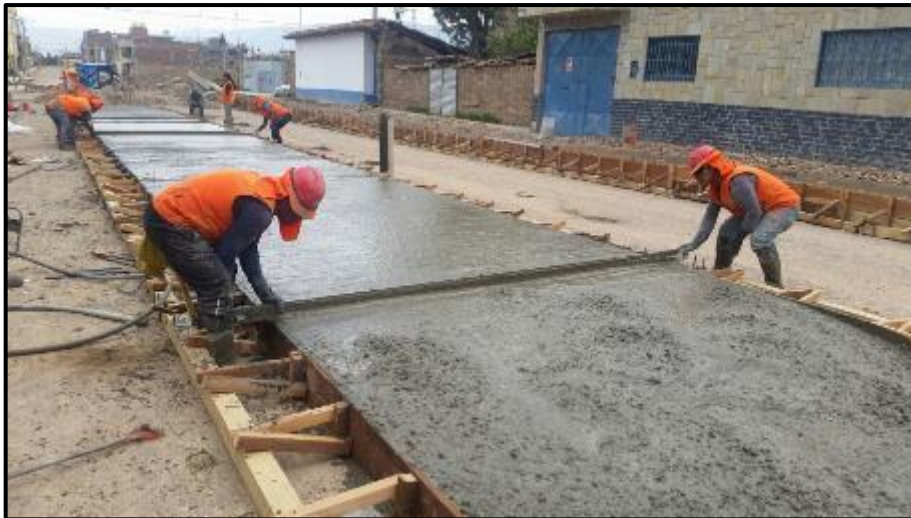
Figura 38 Vaciado de cuatro paños por día – progresiva 0+160
