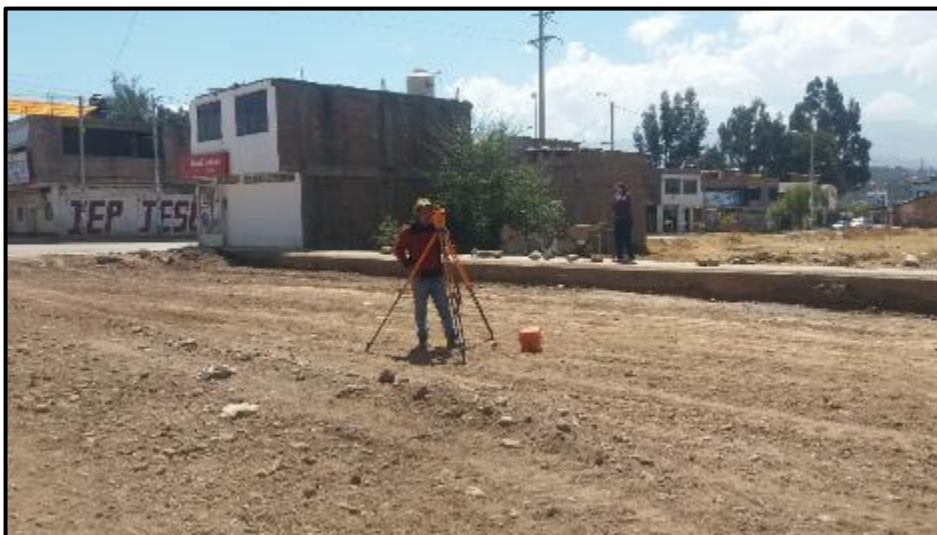
Figura 23 Partida trazo y replanteo en la progresiva 0+020
