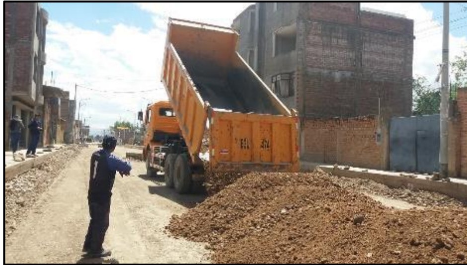
Figura 33 Colocación de material Granular en la progresiva 0+160
