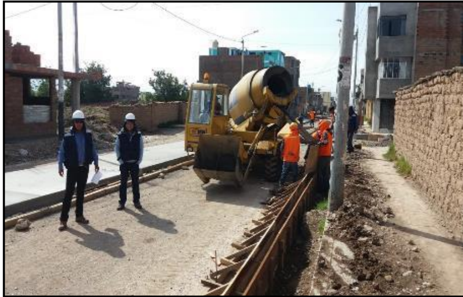
Figura 31 Colocación de concreto en sardinel con autohormigonera en progresiva 0+080
