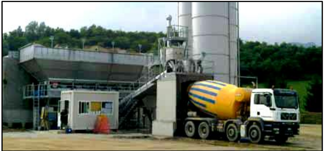
Figura 9 Planta de dosificación del Concreto
