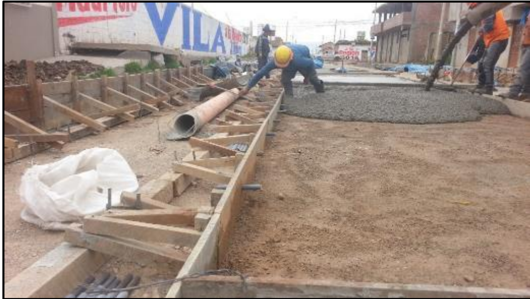
Figura 32 Trabajabilidad del concreto en la progresiva 0+150
