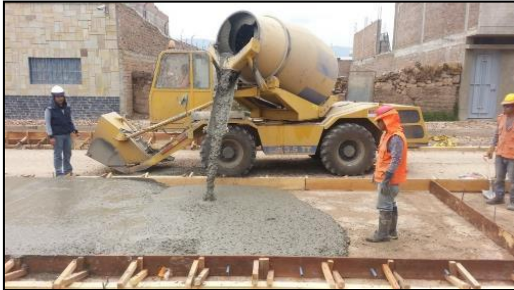
Figura 30 Colocación de concreto en la progresiva 0+160
