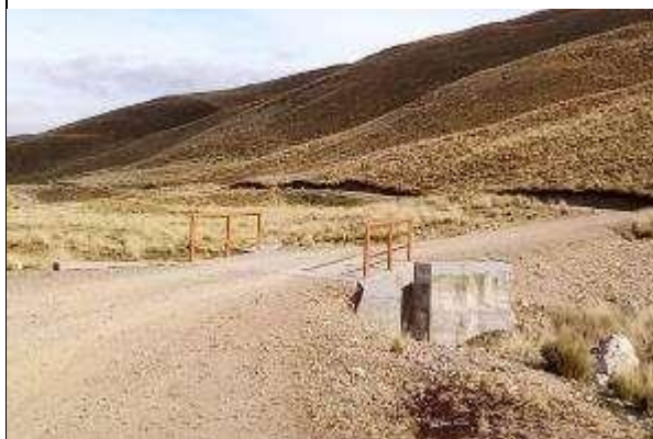
Foto N° 04 SEÑALIZACION DE CURVAS
