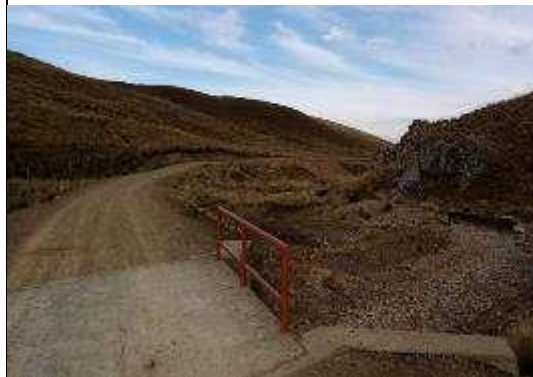
Foto N° 02 PONTON DE CONCRETO
