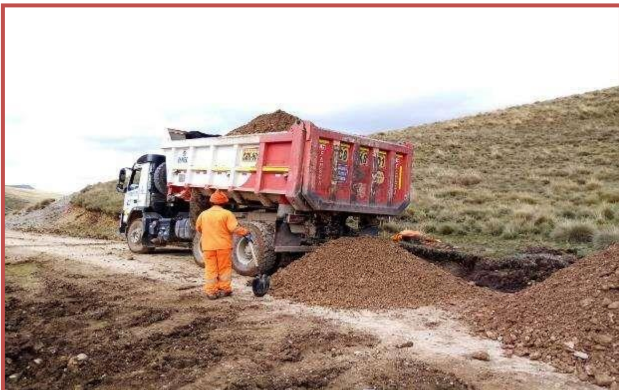
04. SE OBSERVA EL DESCARGUE DEL MATERIAL DE CANTERA PARA MEJORAMIENTO DE SUB-RASANTE
