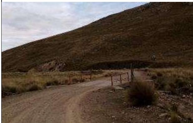
Foto N° 01 PONTON DE CONCRETO
