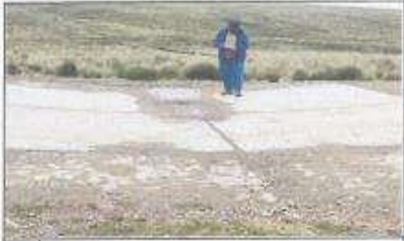
10 Baden N° 01 De concreto - Estado de Conservación Buena Pag. 01+150.00
