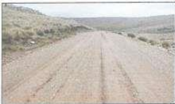
13 Cuneta De Tierra Lado Izquierdo - Estado de Conservación Buena Pag. 01+549.00
