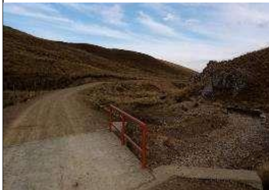
Foto N° 02 PONTON DE CONCRETO
