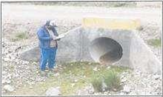
14 Alcantarilla Tmc N° 02 (D=0.32) - Estado de Conservación Buena Pag. 01+500.00
