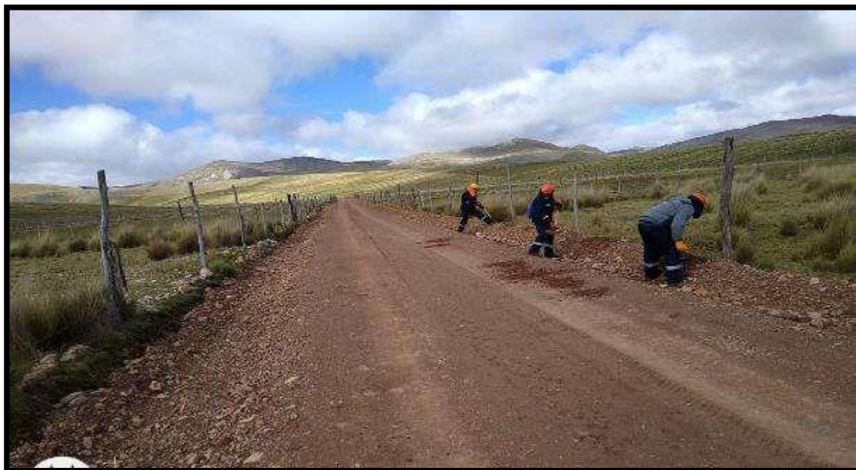
Figura No 01: Estado actual de la superficie de rodadura.
