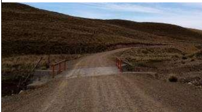
Foto N° 03 PONTON DE CONCRETO
