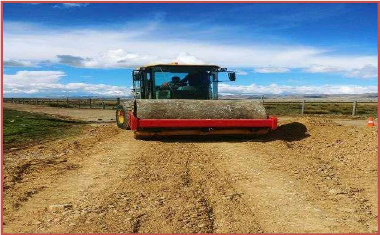
06. SE OBSERVA EL COMPACTADO CON MATERIAL DE CANTERA
