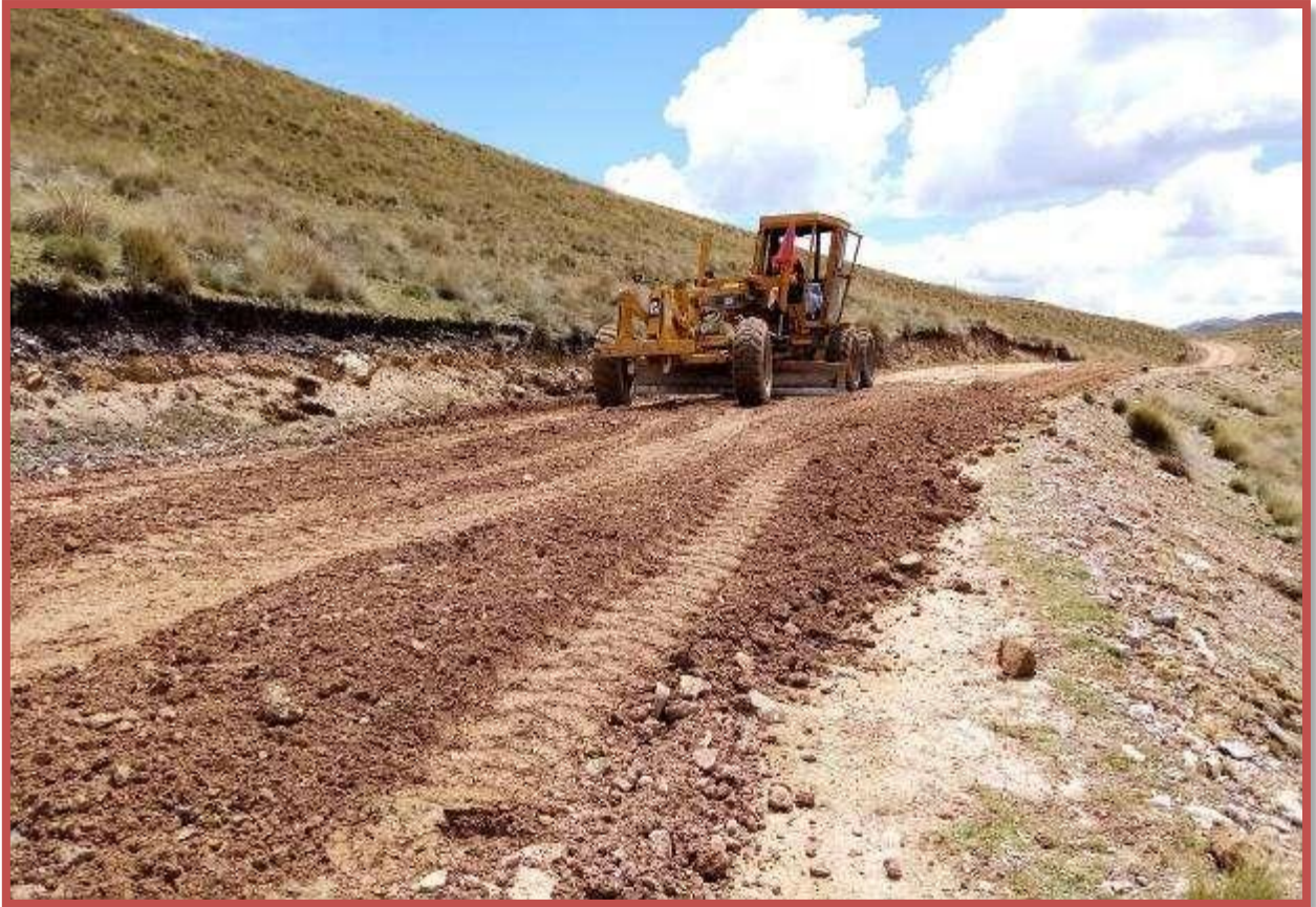
05. SE OBSERVA EL NIVELADO CON MATERIAL DE CANTERA
