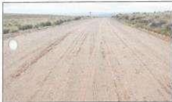
09 (Fin)Cuneta De Tierra Ambos Lados - Estado de Conservación Buena Pag. 01+150.00
