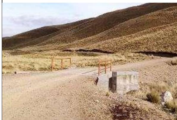
Foto N° 04 SEÑALIZACION DE CURVAS
