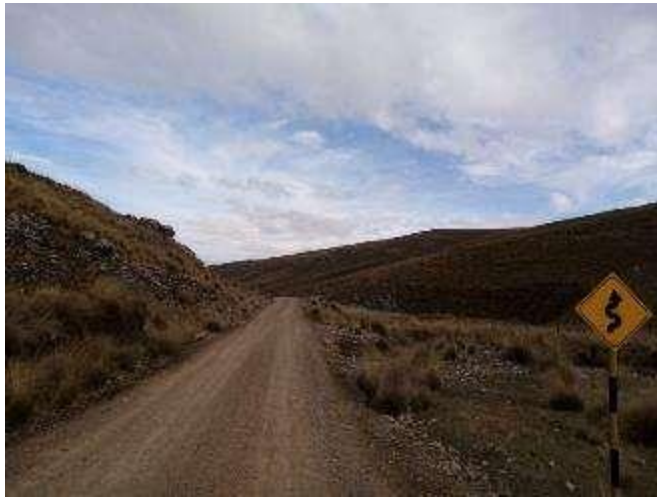
Foto N° 03 SEÑALIZACION DE CURVAS
