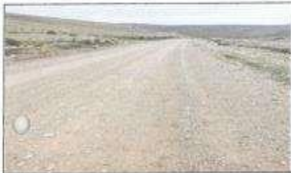
11 (Inicio)Cuneta De Tierra Lado Izquierdo - Estado de Conservación Buena Pag. 01+302.00
