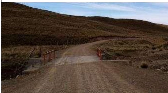
Foto N° 03 PONTON DE CONCRETO
