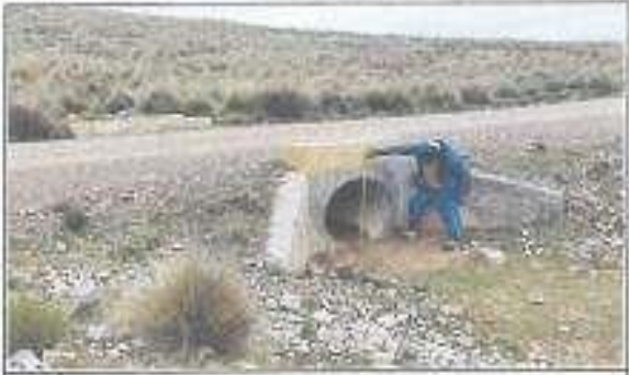
12 Alcantarilla Tmc N° 01 (D=0.32) - Estado de Conservación Buena Pag. 01+352.00
