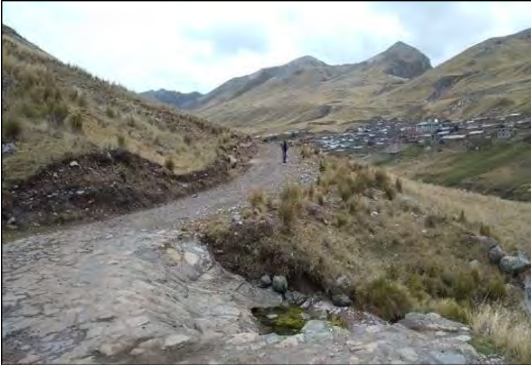
Fotografía 16. Camino vecinal a SuitucanCHA. Vista desde la Progresiva 1+380.
