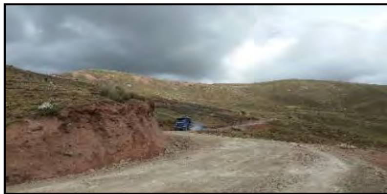
Ilustración 17. Superficie de rodadura no pavimentada
