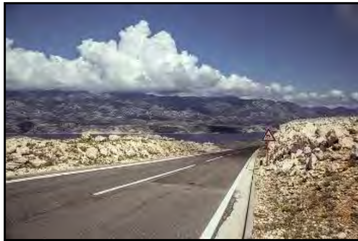
Ilustración 18. Superficie de rodadura pavimentada.
