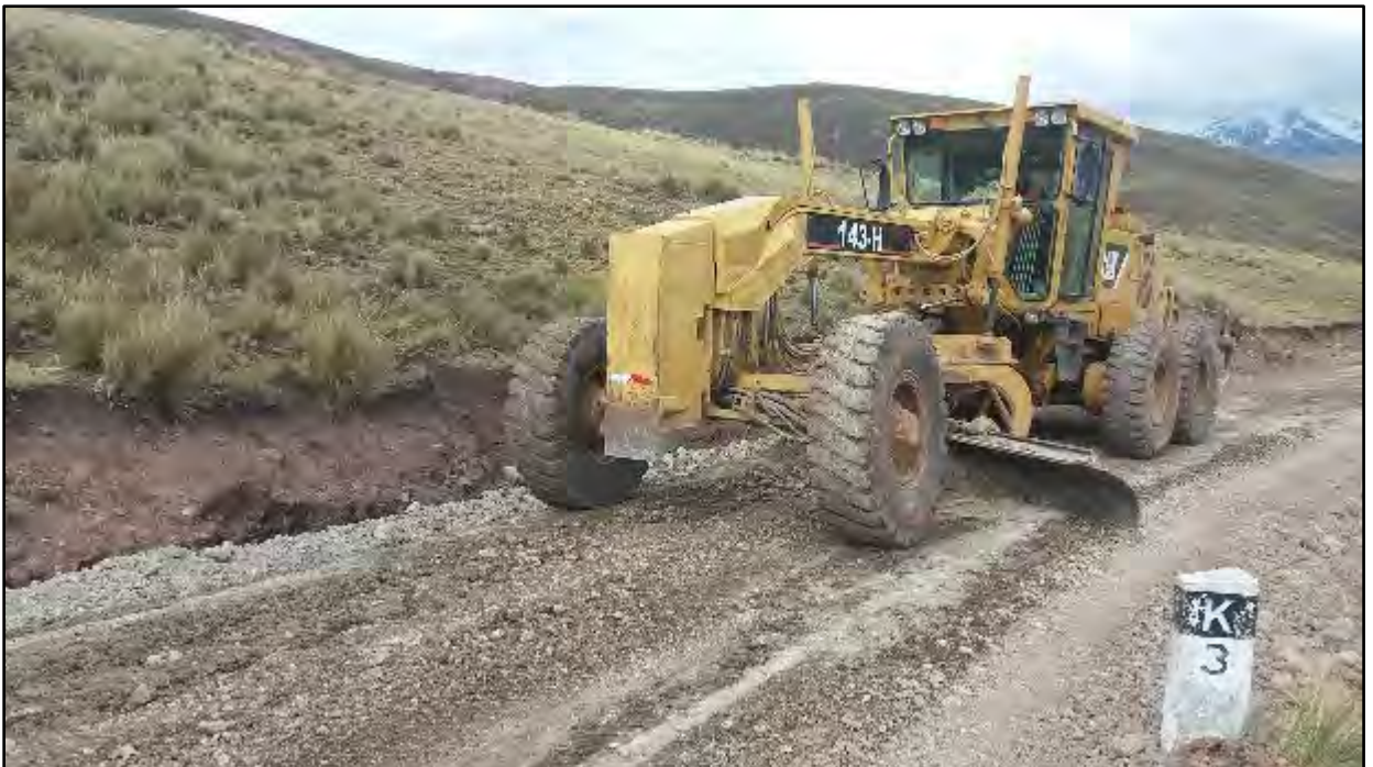
Fotografía 8. Mezcla y Conformación del Material según la sección 302B.07 del Manual de Especificaciones Técnicas Generales. Progresiva 3+000.
