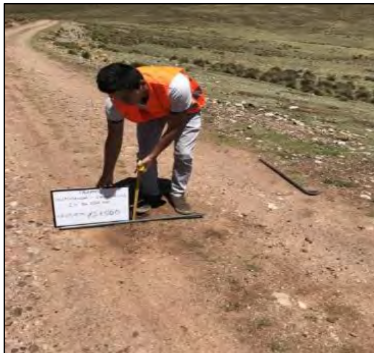
Fotografía 26. Control de calidad en el tramo N°03. Progresiva 15+500.
