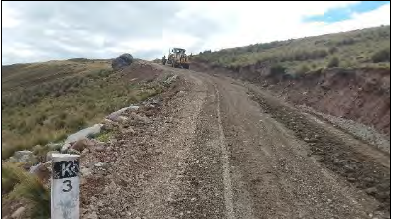
Fotografía 5. Perfilado de Cunetas según el Manual Técnico de Mantenimiento Periódico. Progresiva 3+000.
