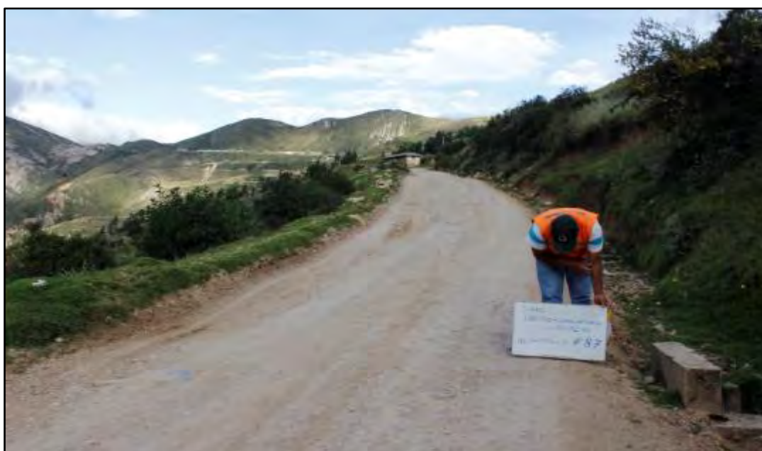
Fotografía 23. Control de densidad de campo.
