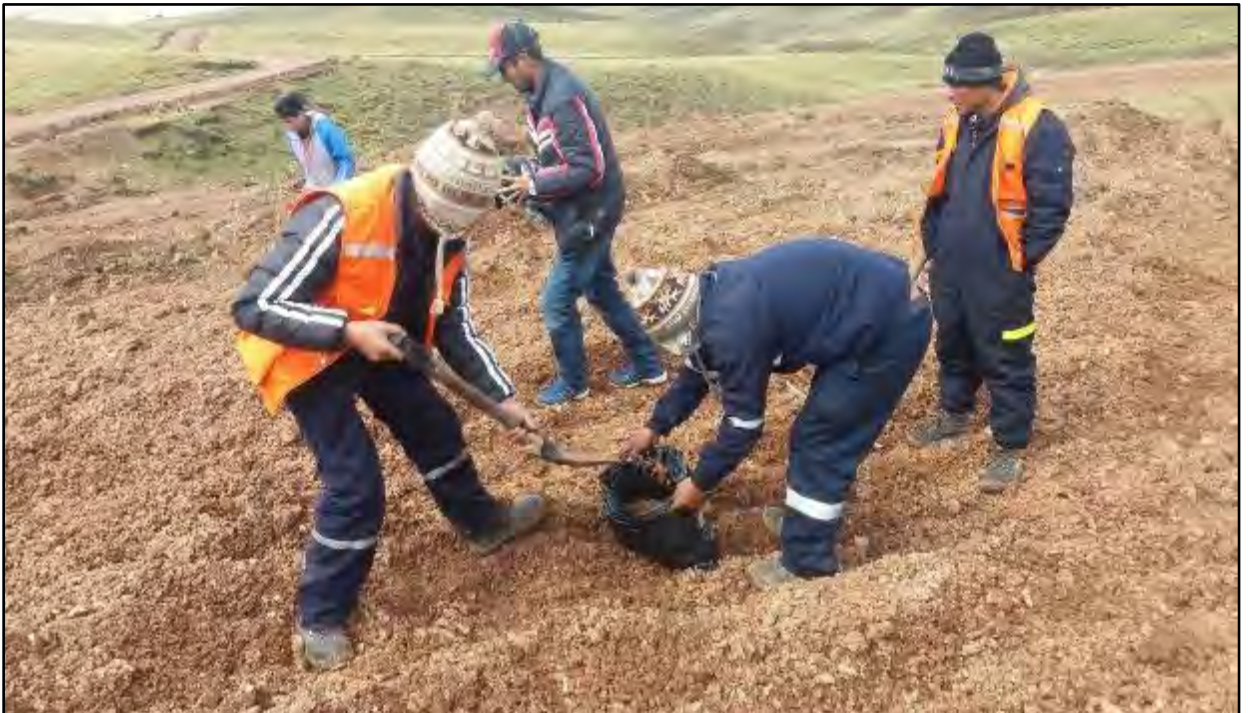
Fotografía 12. Extracción de muestras de material para su análisis y posterior uso como cantera. Progresiva 8+650.
