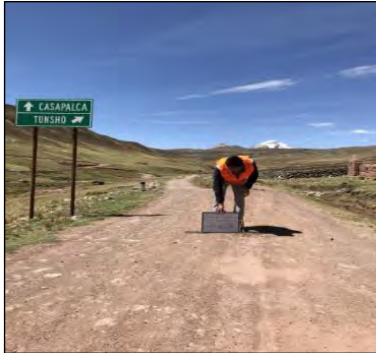
Fotografía 25. Control de calidad en el tramo N°02. Progresiva 7+640.
