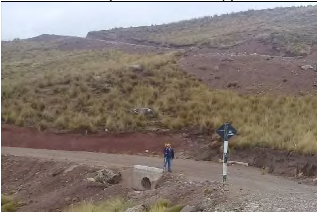
Fotografía 18. Inicio de levantamiento topográfico
