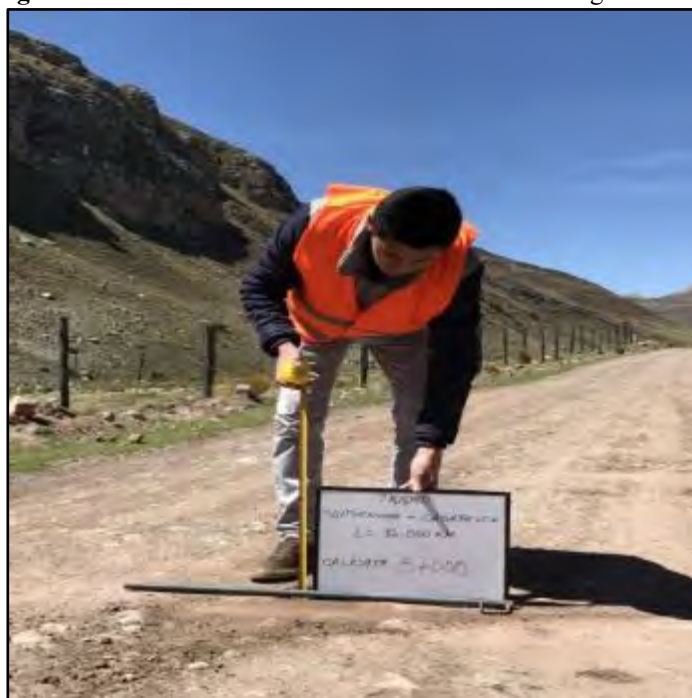
Fotografía 24. Control de material colocado en la vía. Progresiva 5+000.
