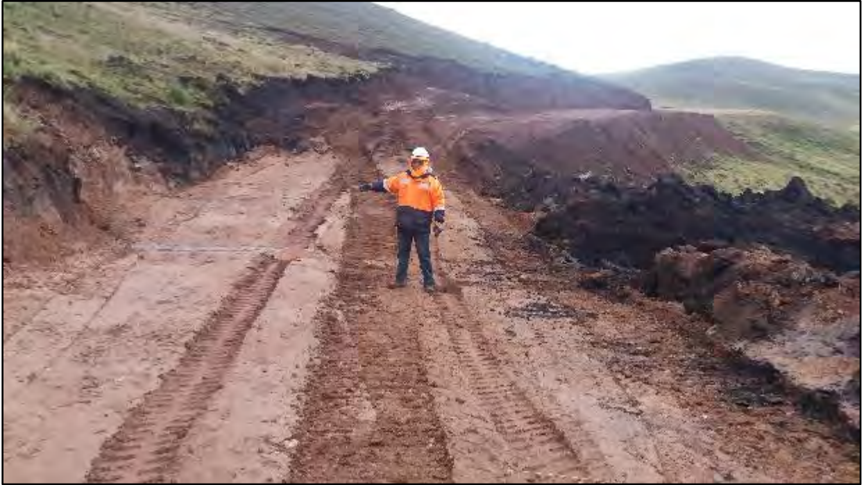
Fotografía 13. Vista de zonas llenas de bofedales y alto nivel freático. Progresiva 14+550.
