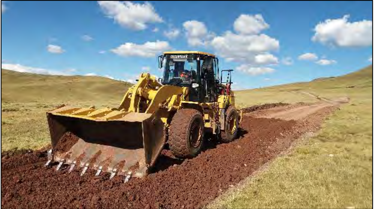
Fotografía 7. Extensión del Material según la sección 302B.07 del Manual de Especificaciones Técnicas Generales. Progresiva 10+250.
