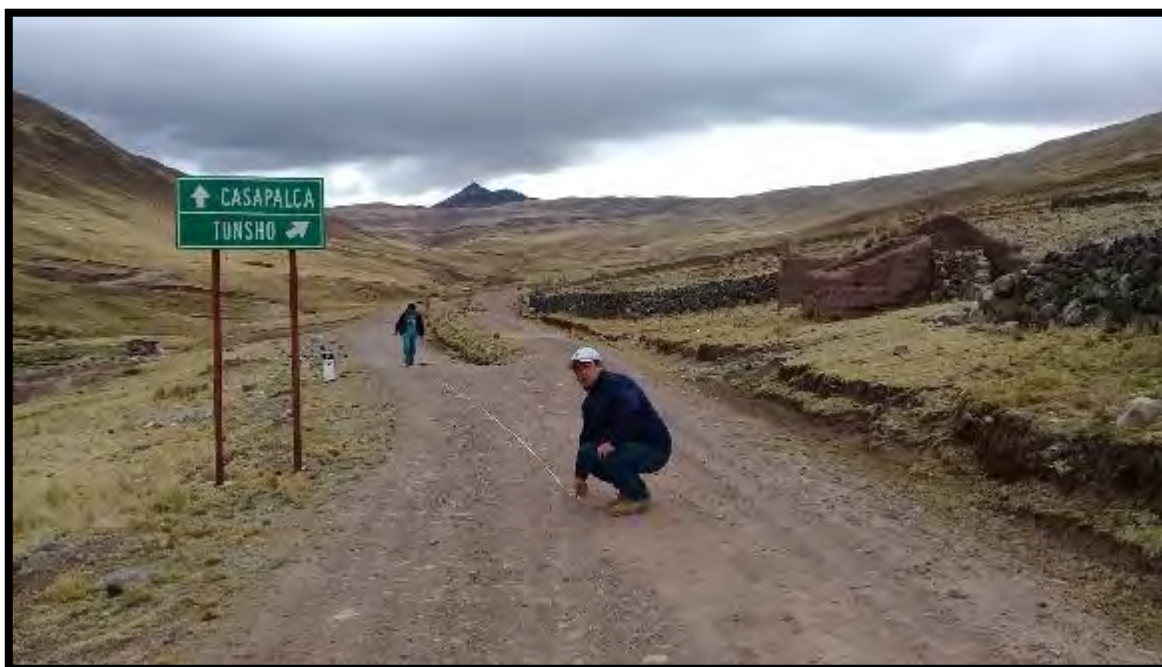
MEDICION Y PINTADO DE PROGRESIVAS
