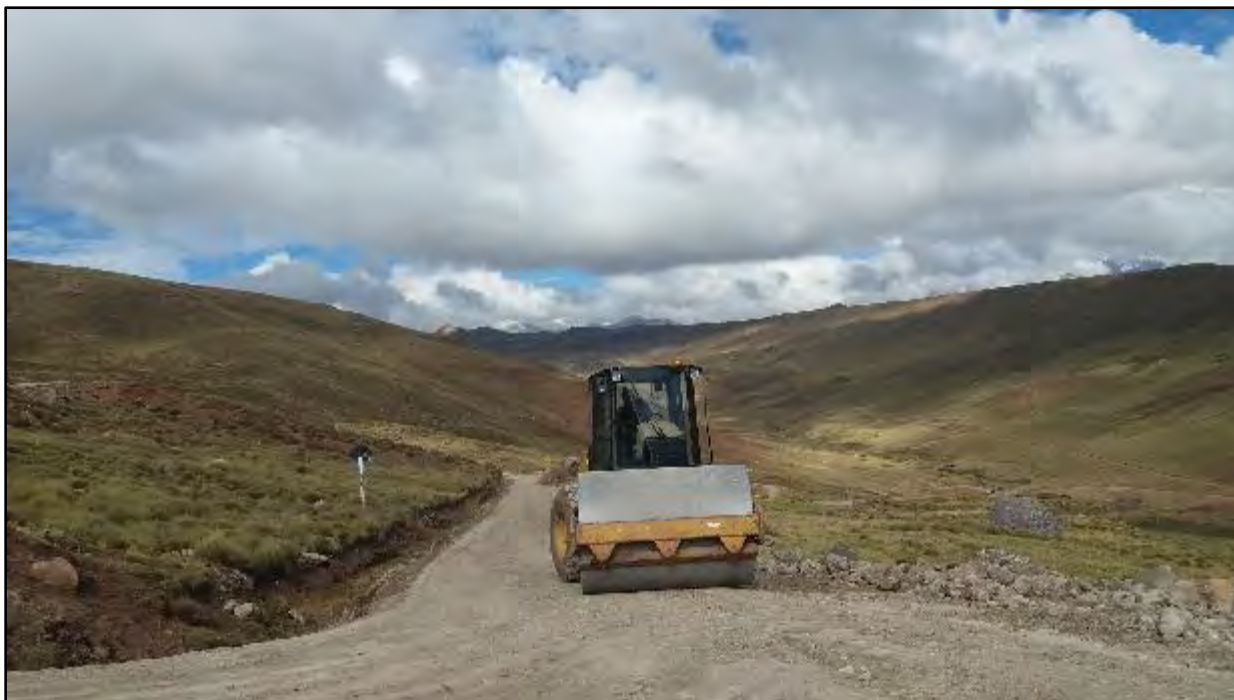
Fotografía 10. Compactación según la sección 302B.08 del Manual de Especificaciones Técnicas Generales. Progresiva 7+400.
