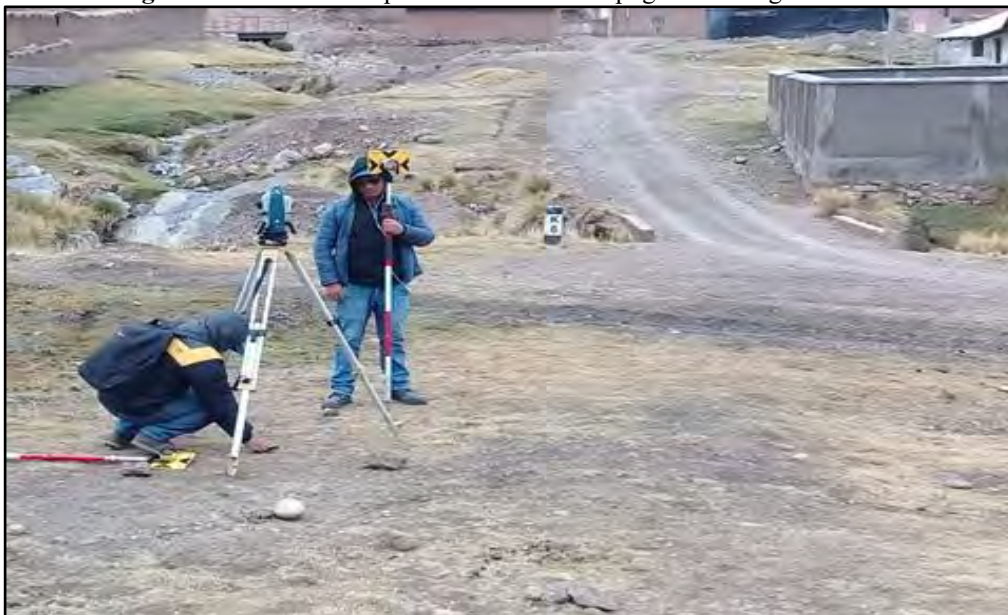
Fotografía 17. Colocación para levantamiento topográfico. Progresiva 0+000.
