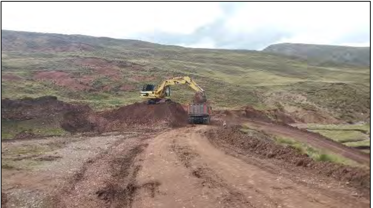
Fotografía 2. Carguío y transporte de material seleccionado según lo indica la sección 300B.04 del Manual de Especificaciones Técnicas. Progresiva 8+650.
