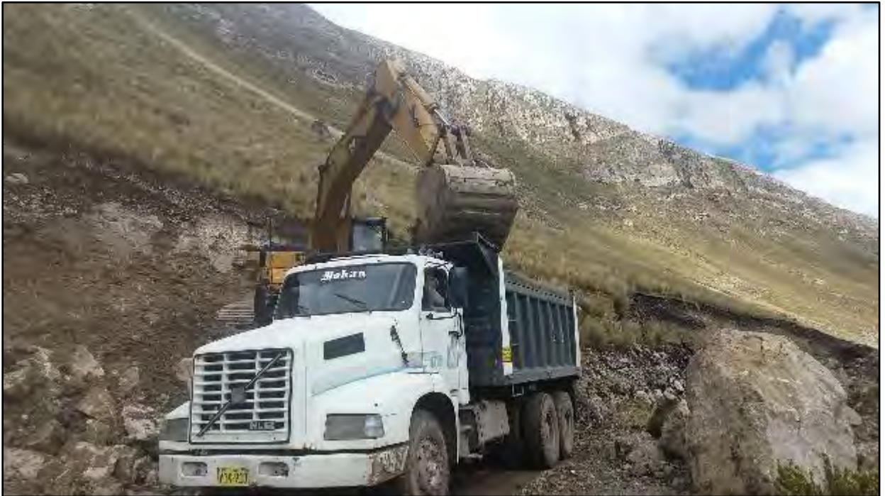
Fotografía 3. Carguío y transporte de material seleccionado según lo indica la sección 300B.04 del Manual de Especificaciones Técnicas. Progresiva 2+300.
