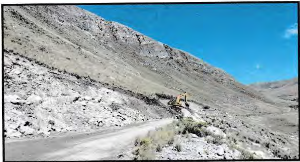
Fotografía 2: Vista de cantera 1.
