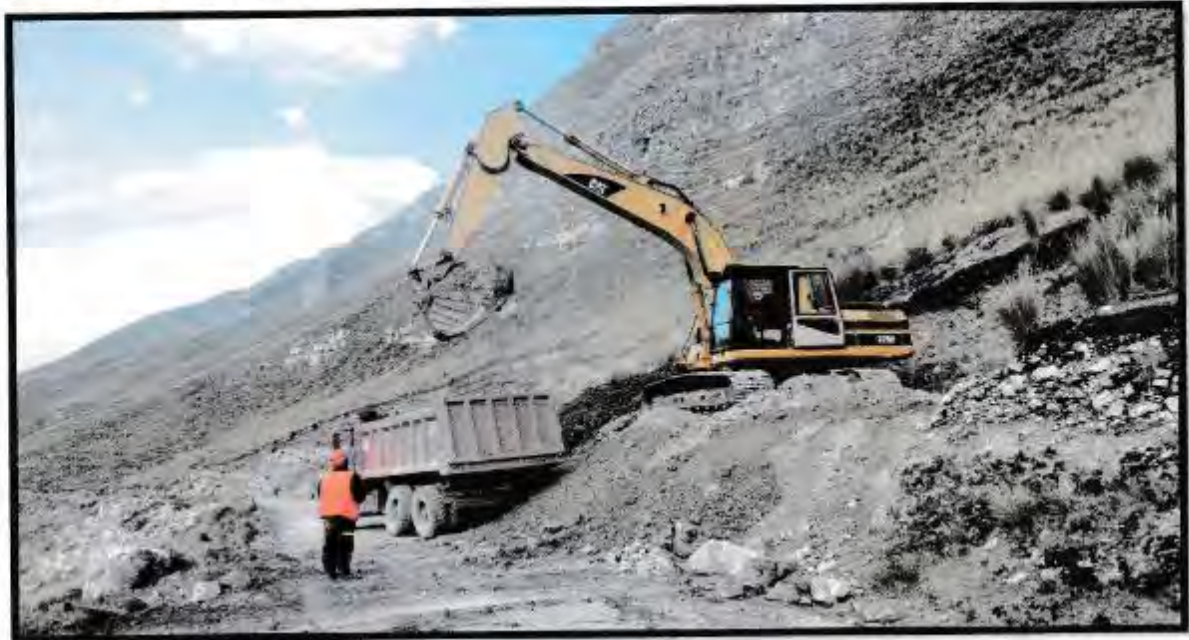
Fotografía 1: Vista de cantera 1.
