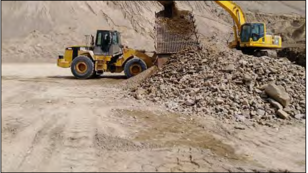
Fotografía 1. Explotación del Material según la sección 5.5.1 Manual del Diseño de Carreteras no Pavimentadas de Bajo Volumen de Transito, progresiva 2+300.
