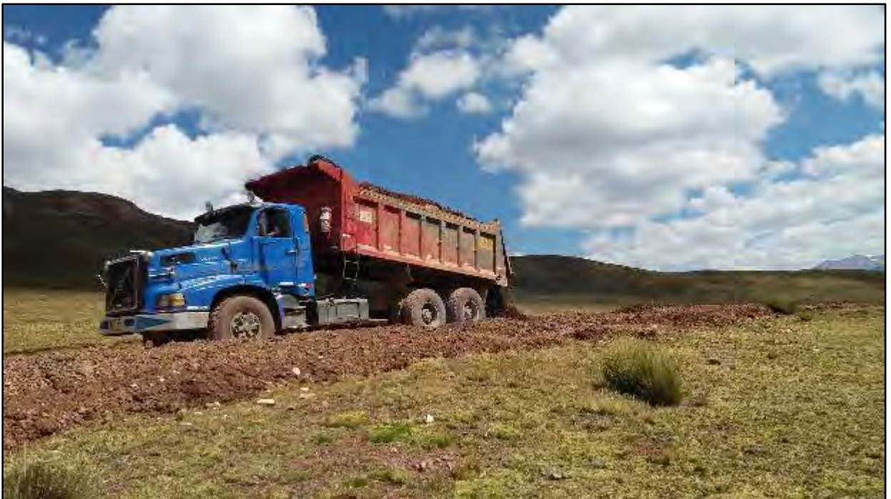
Fotografía 6. Transporte y colocación del Material según la sección 302B.06 del Manual de Especificaciones Técnicas Generales. Progresiva 14+500.
