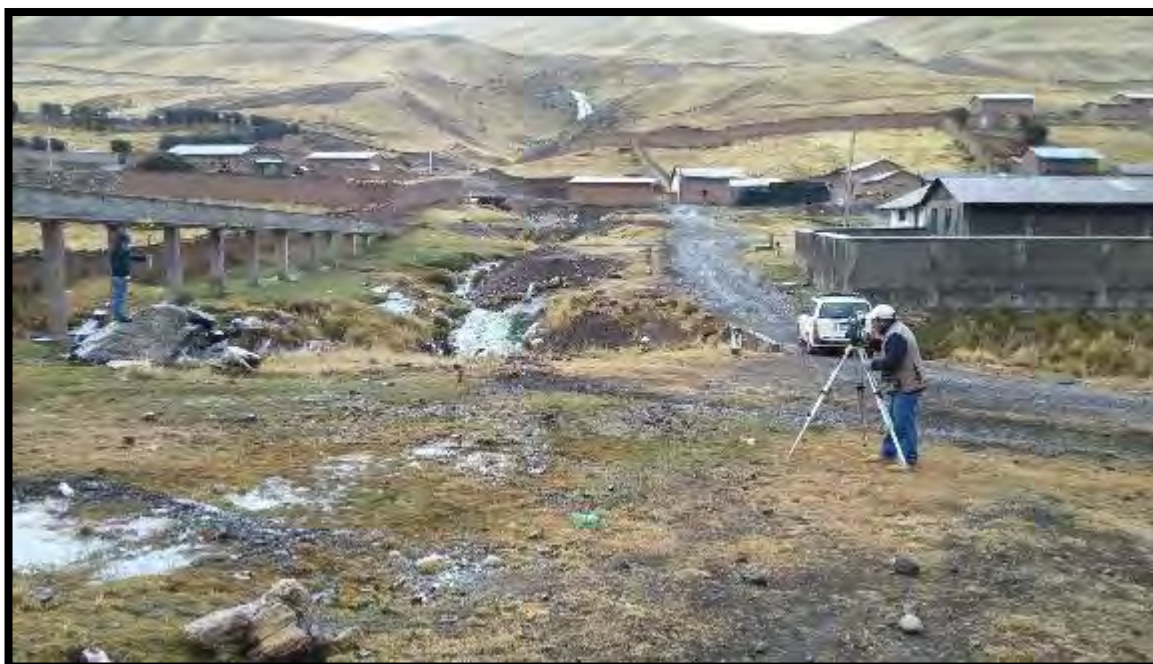
INICIO DE LOS TRABAJOS DE TOPOGRAFIA KM-0+000
