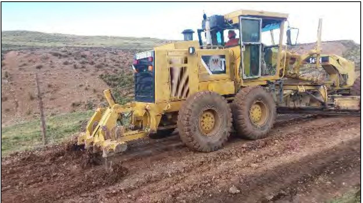
Fotografía 4. Escarificado de Plataforma para su reposición según lo estipulado en el Manual Técnico de Mantenimiento Periódico. Progresiva 4+570.
