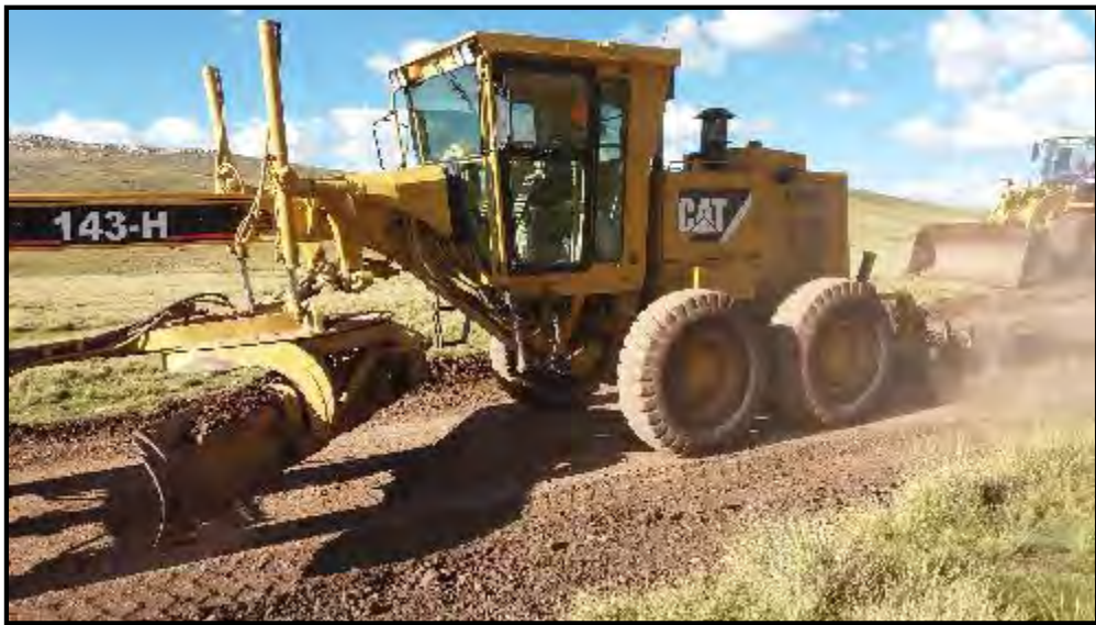
Ilustración 11. Escarificado de la sub rasante.
