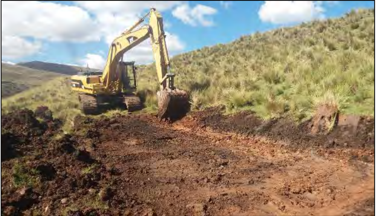
Fotografía 11. Apertura de vía debido a que el proyecto contemplaba tramos que no fueron intervenidos anteriormente. Progresiva 14+000.
