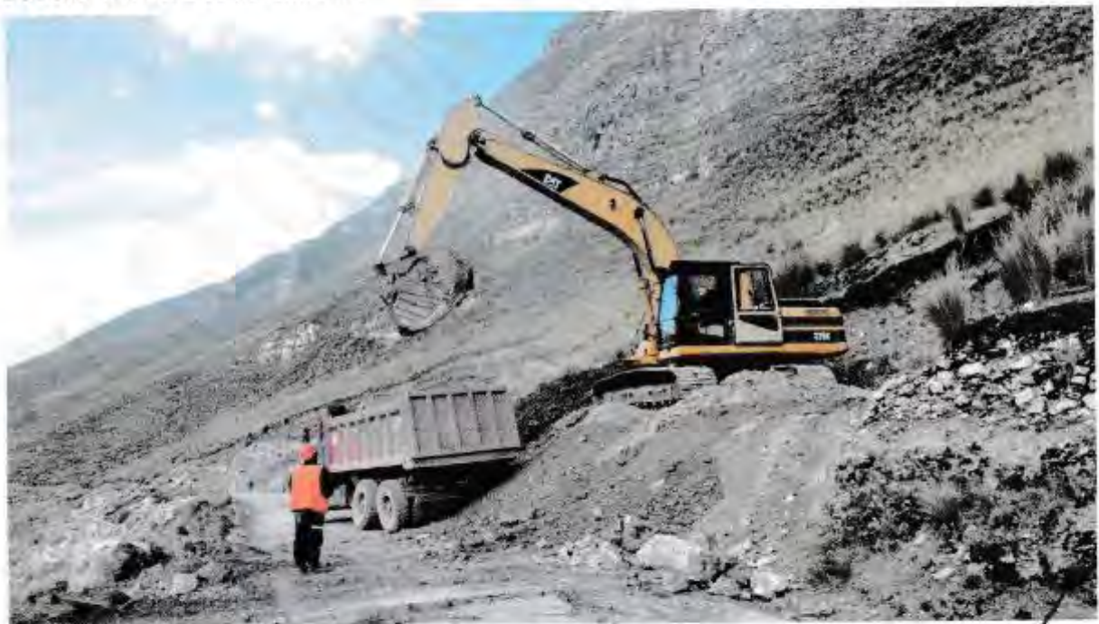
FOTO N° 01: Vista de la Cantera I
