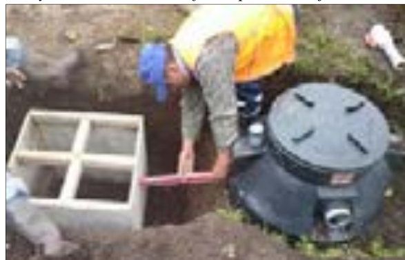
Figura 31 Excavación para la caja de lodos y nivelación del encofrado para la caja de lodos
