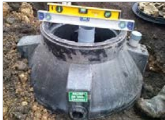
Figura 31 Excavación para la caja de lodos y nivelación del encofrado para la caja de lodos
