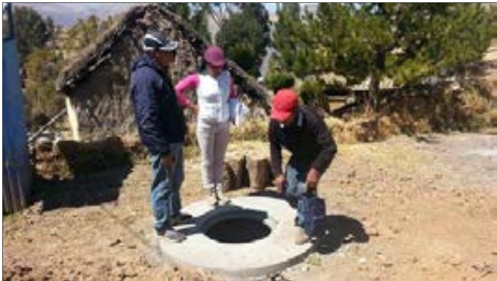
Figura 13 Pozo percolador – inspección con el supervisor y el residente
