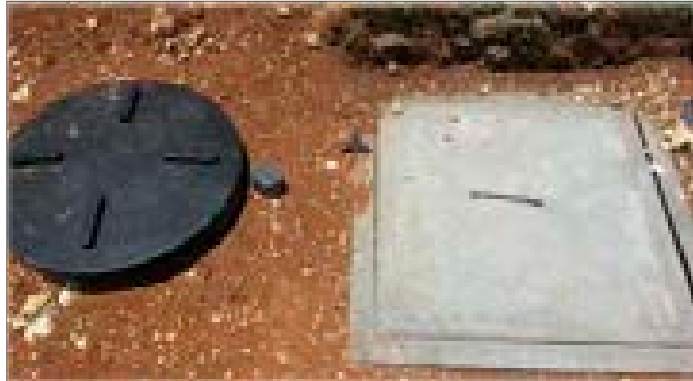
Figura 29 Instalación biodigestores y cajas de lodo para los modulo UBS
