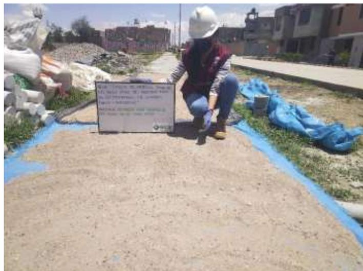
**Imagen 02:** Vista general del proceso de secado del agregado fino, con el propósito de uniformizar y no caer en el repetitivo acto de reajustar el diseño de mezcla.
