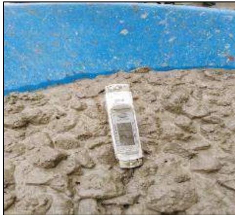
*Figura 14. Medición de la temperatura del concreto fresco*
