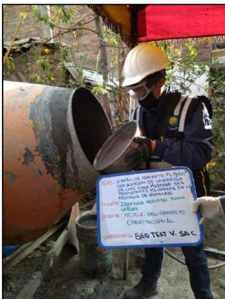
Fotografía N° 13: Se observa cómo se vierte el agregado fino para la elaboración del concreto convencional, de acuerdo a la norma NTP 339.183.
