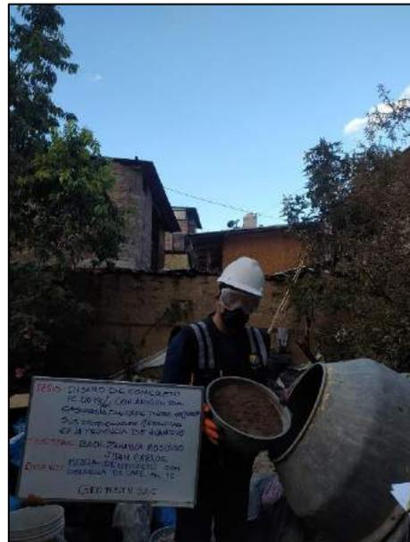
Fotografía N° 24: Se observa cómo se vierte el agregado fino para la elaboración del concreto con adición del 1% de cascarilla de café, de acuerdo a la norma NTP 339.183.
