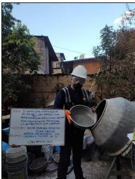
Fotografía N° 22: Se observa cómo se vierte el cemento para la elaboración del concreto con adición del 1% de cascarilla de café, de acuerdo a la norma NTP 339.183.
