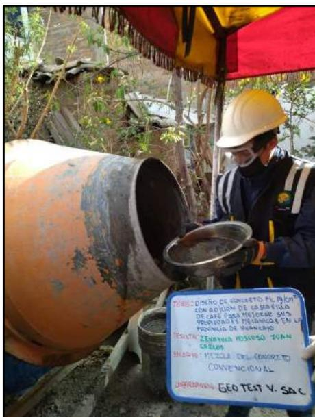
Fotografía N° 14: Se observa cómo se vierte el agua para la elaboración del concreto convencional, de acuerdo a la norma NTP 339.183.
