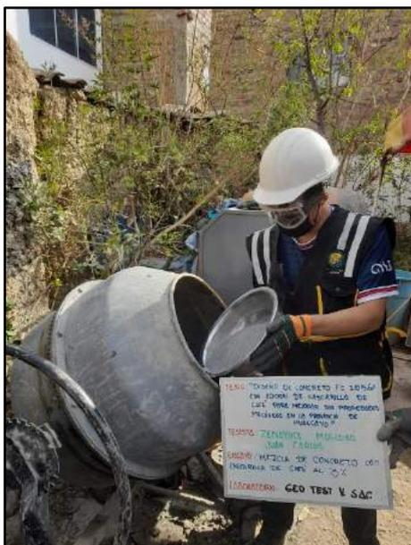
Fotografía N° 50: Se observa cómo se vierte la cascarilla de café con un porcentaje del 3% para su mezcla en el concreto, de acuerdo a la norma NTP 339.183.
