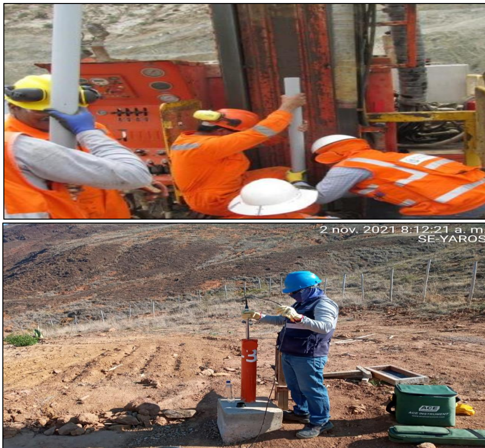
Figura N° 51: Proceso de instalación de los inclinómetros verticales en la Subestación Yaros
