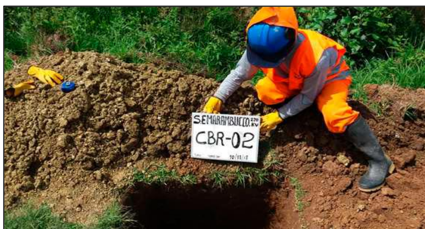
Figura N° 35: Excavación de calicatas en el área de estudio
