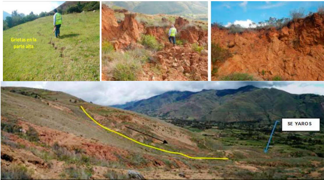
Figura N° 55: Deslizamiento de la parte alta de la ladera de la Subestación Yaros
