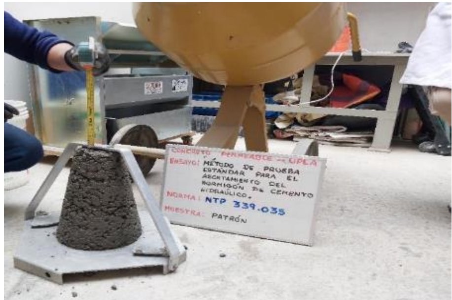
Fotografía 21: Medición de asentamiento en cono Abrams.
